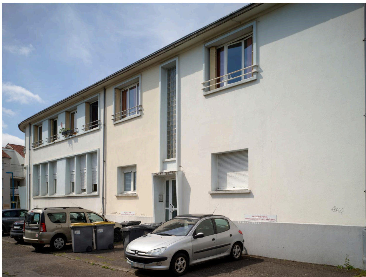
L'ancienne coopérative Michelin de la cité : élévation sur la rue Marcel-Michelin.
