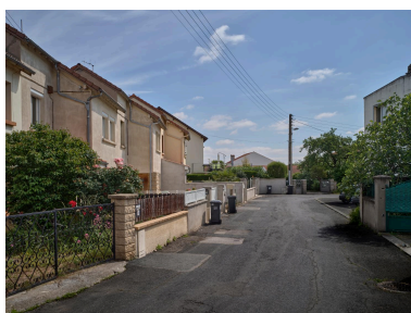
Vue partielle de la cité sur la rue Marcel-Michelin, près de la coopérative. Phot. Christian Parisey IVR84_20246301348NUC4A
