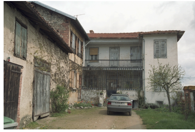
Vue d'ensemble de la féculerie des Trouillères (1987 A1 1646). Phot. Thierry Monnet IVR82_20044200487ZE
