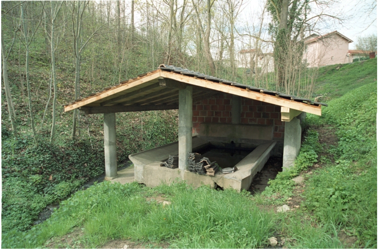
Vue d'ensemble du lavoir des Trouillères (1987 A1 64, 65).
