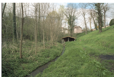
Vue générale du lavoir des Trouillères (1987 A1 64, 65).
