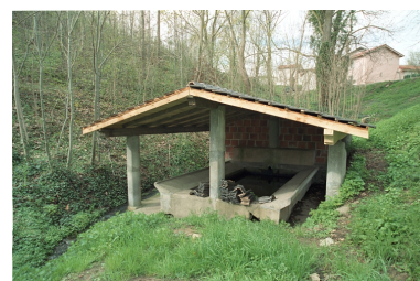
Vue d'ensemble du lavoir des Trouillères (1987 A1 64, 65).
