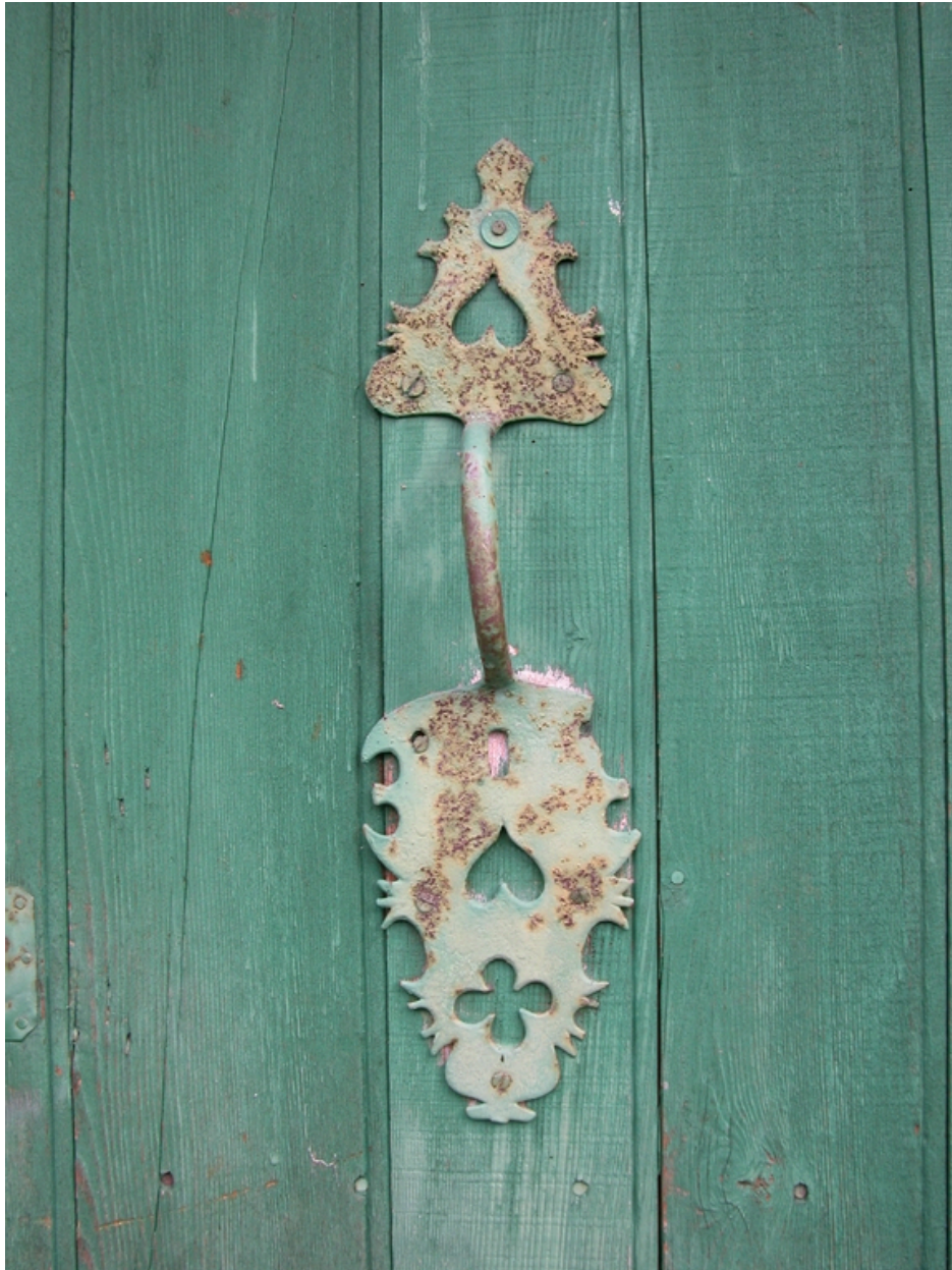
Détail de ferrure de porte.
