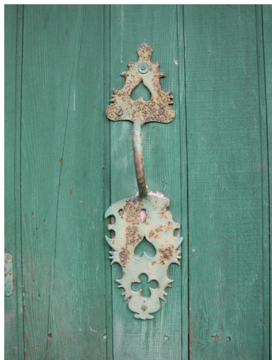
Détail de ferrure de porte. Phot. Caroline Guibaud IVR82_20124201164NUCA
