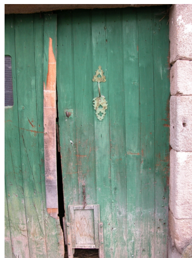
Détail d'une porte. Phot. Caroline Guibaud IVR82_20124201163NUCA
