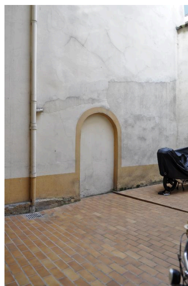
Cour : ancienne porte de communication avec le 50 rue d'Anvers Phot. Catherine Guégan IVR84_20176900992NUCA
