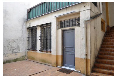
Bâtiment sur cour, extension plus récente en rez-de-chaussée Phot. Catherine Guégan IVR84_20176900989NUCA
