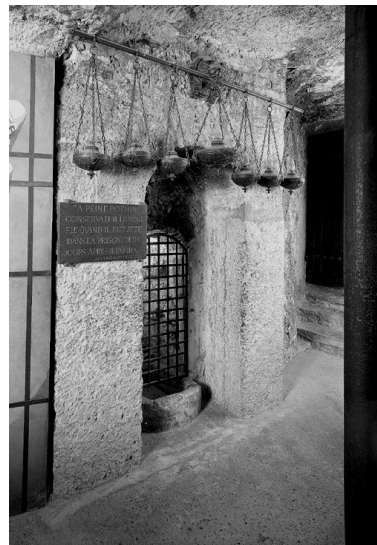
Grande applique au- dessus de l'entrée du cachot Phot. Jean-Marie Refflé IVR82_20016900786P
