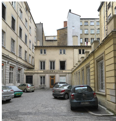
Vue d'ensemble du bureau du syndicat de la soie localisé sur le site de la société Morel Journal
