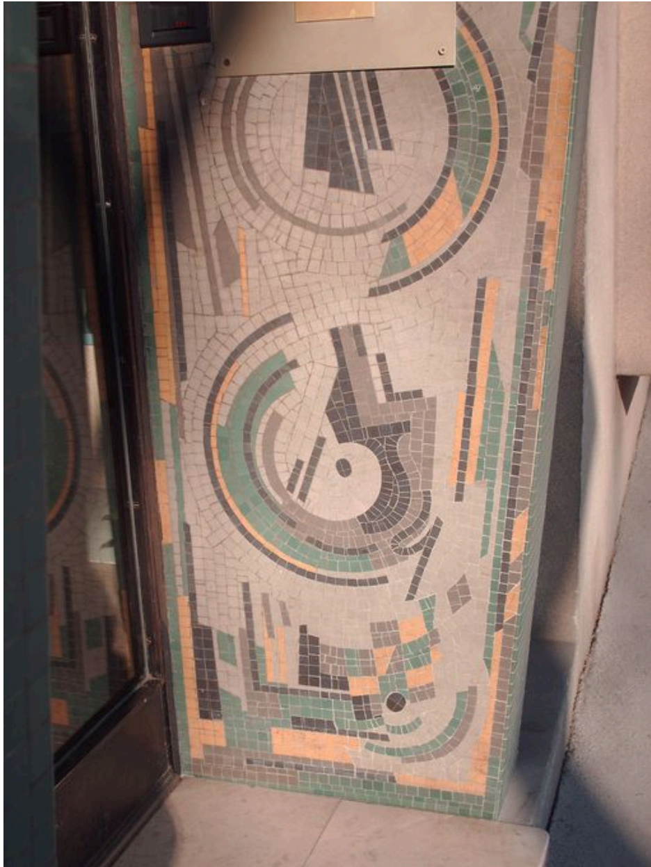
Porte d'entrée ornée d'une mosaïque : détail de la partie droite
