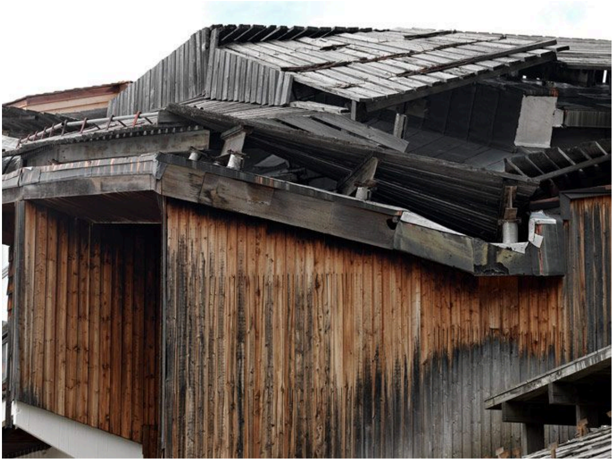
Détail de couverture
