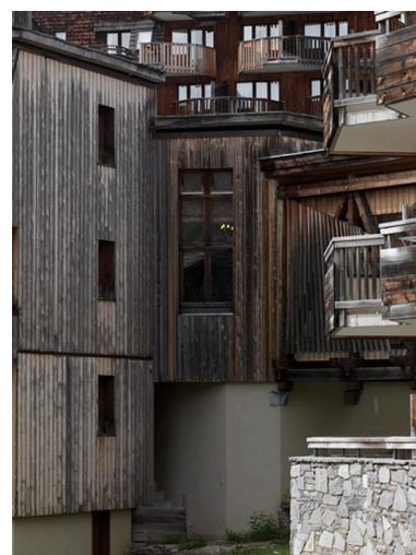
Soubassement en ciment enduit surmonté d'un essentage de planches Phot. Eric Dessert IVR82_20097400682NUCA
