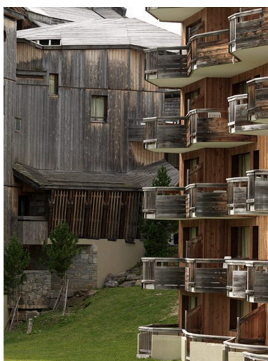
Soubassement en ciment avec parement de moellons surmonté d'un essentage de planches Phot. Eric Dessert IVR82_20097400681NUCA
