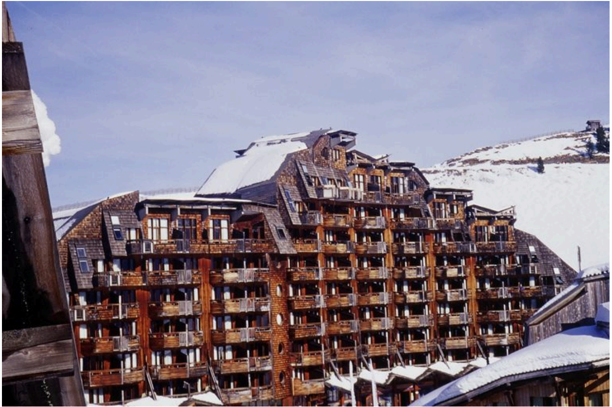
Exemple d'immeuble à silhouette fragmentée
