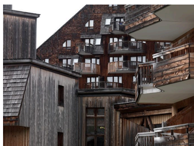
Façade recouverte d'un essentage de planches verticales ou de tavaillons Phot. Eric Dessert IVR82_20097400683NUCA
