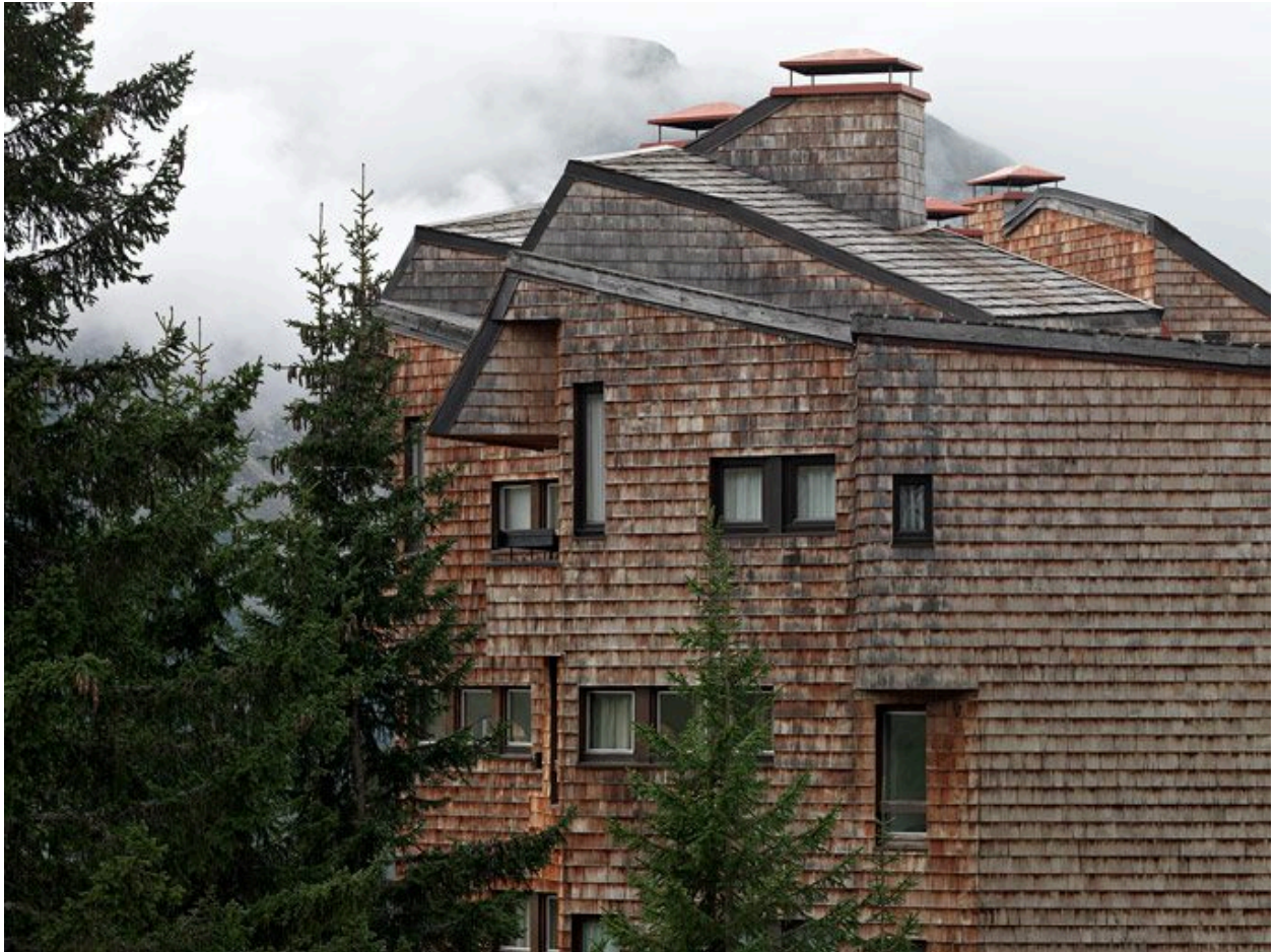
Façade recouverte d'un essentage de tavillons
