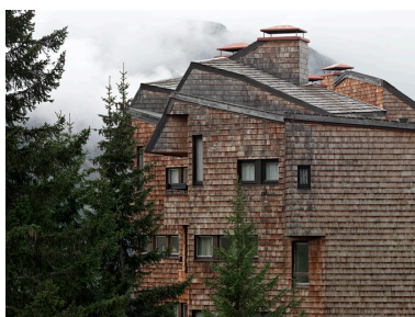
Façade recouverte d'un essentage de tavaillons Phot. Eric Dessert IVR82_20097400718NUCA
