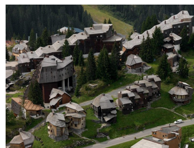
L'Araucarya et le Thuya depuis le nord. Les toitures en cascade Phot. Eric Dessert IVR82_20097400630NUCA
