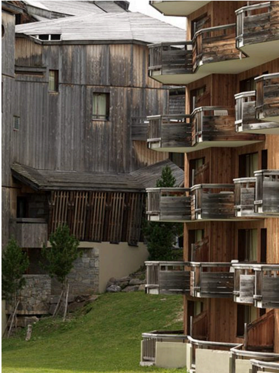
Soubassement en ciment avec parement de moellons surmonté d'un essentage de planches
