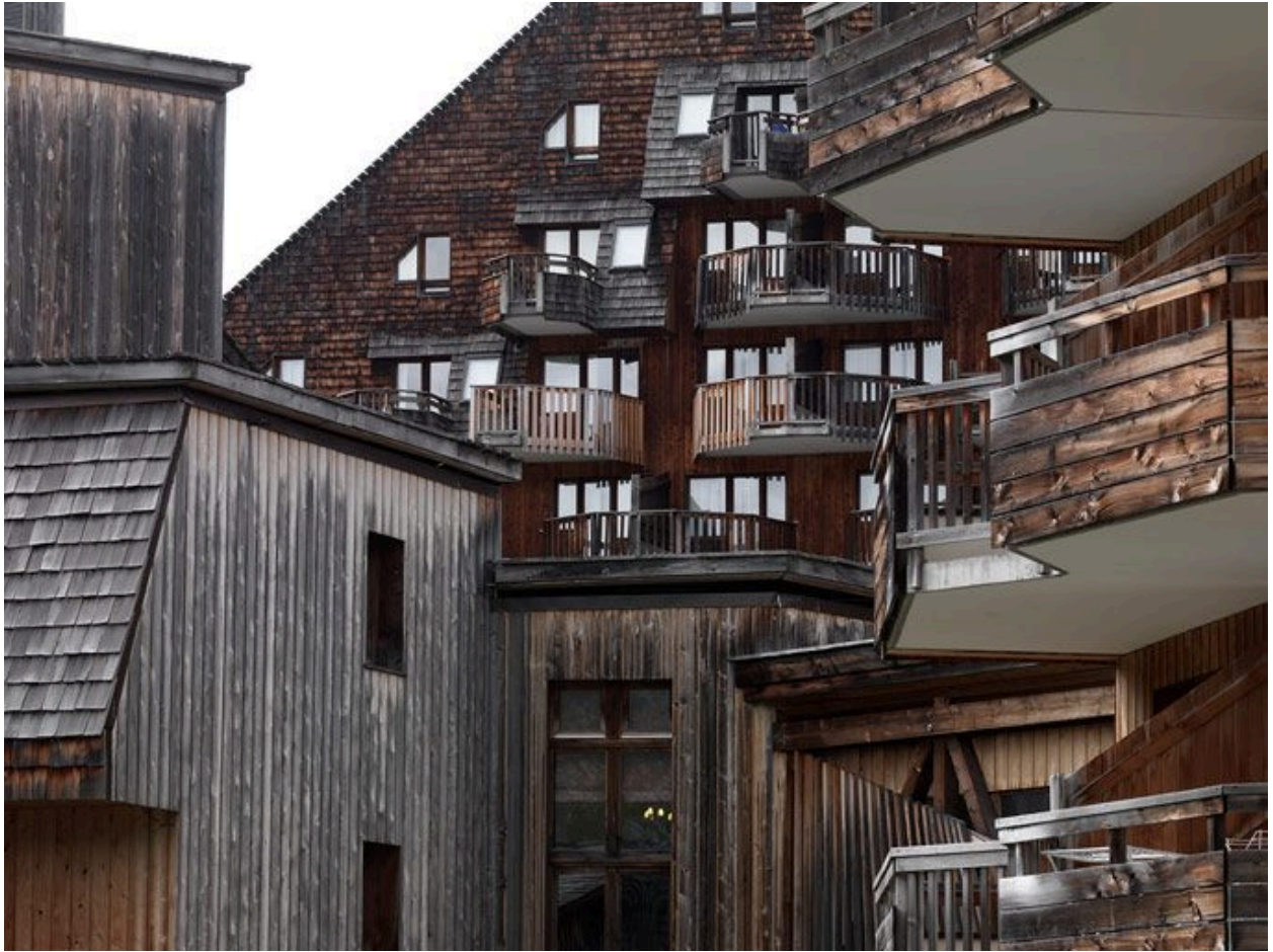
Façade recouverte d'un essentage de planches verticales ou de tavaillons
