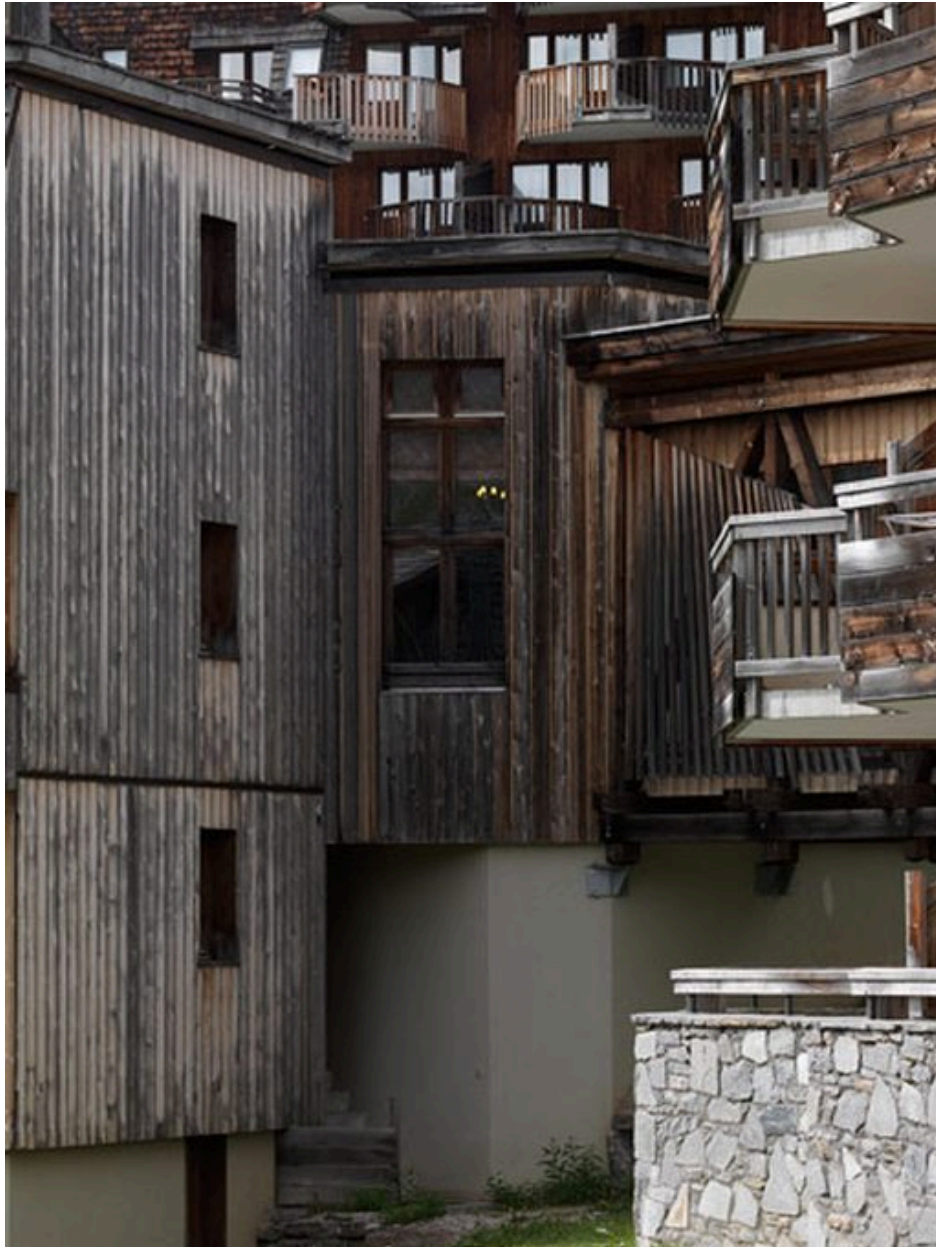
Soubassement en ciment enduit surmonté d'un essentage de planches
