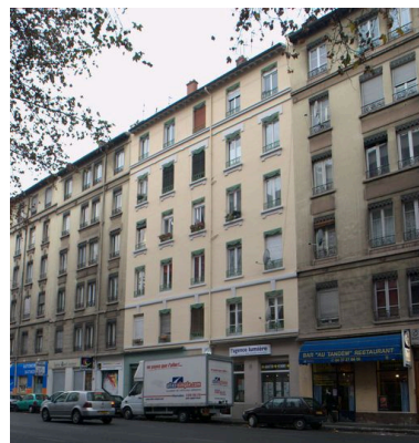
Elévation principale depuis le nord-est Phot. Maryannick Chalabi IVR82_20086900717NUCA
