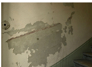
Trace de l'ancien décor peint de la cage d'escalier Phot. Maryannick Chalabi IVR82_20086900640NUCA
