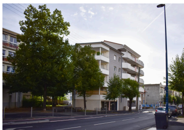
Travée d'angle ouest et façade sur le boulevard Phot. Félicie Fougère IVR84_20256300444NUCA
