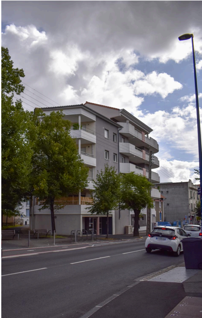
Travée d'angle est et façade sur le boulevard
