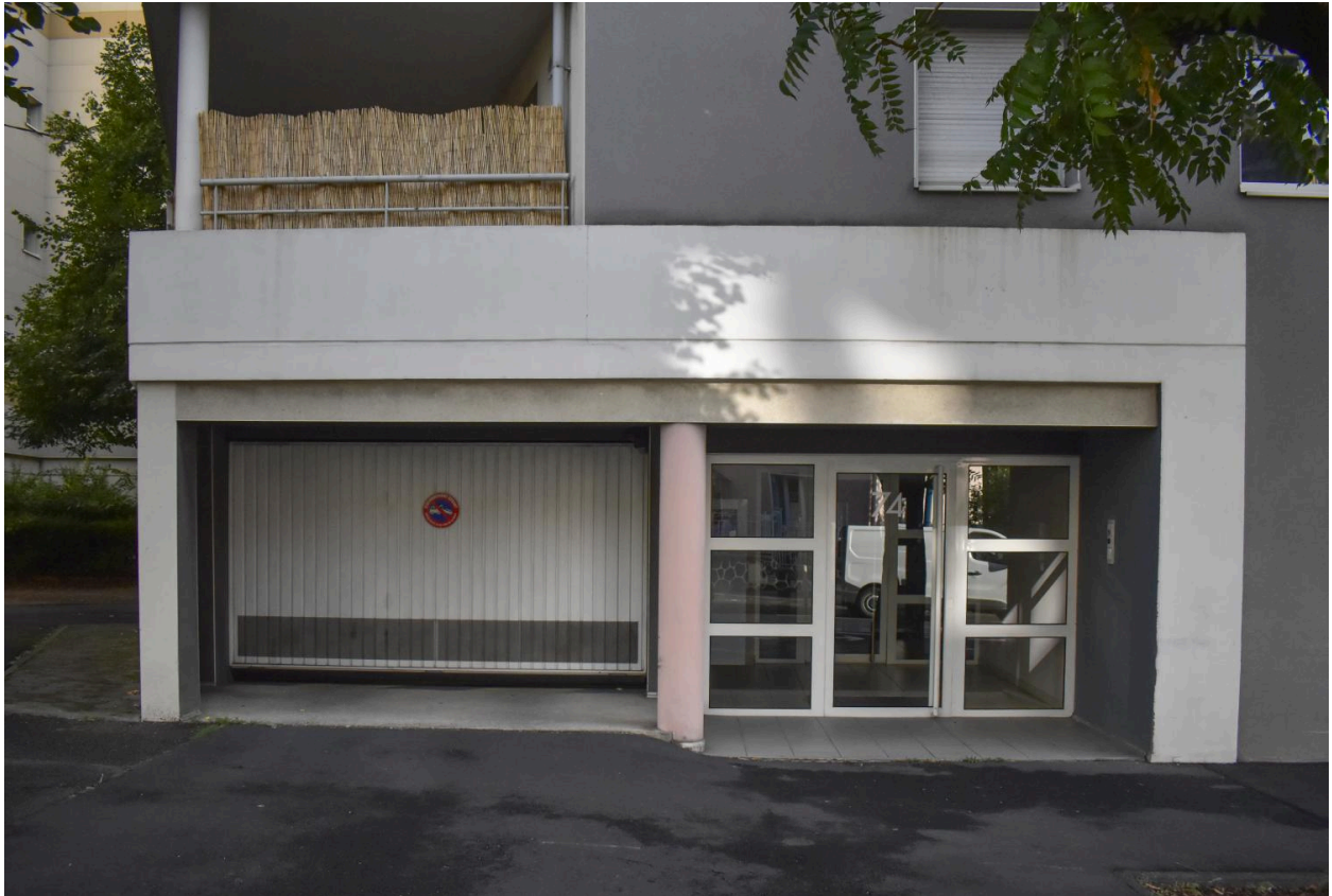
Porte d'entrée sur le boulevard
