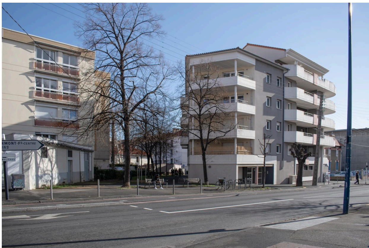
Travée d'angle orientale. Débouché de la rue de Vallières
