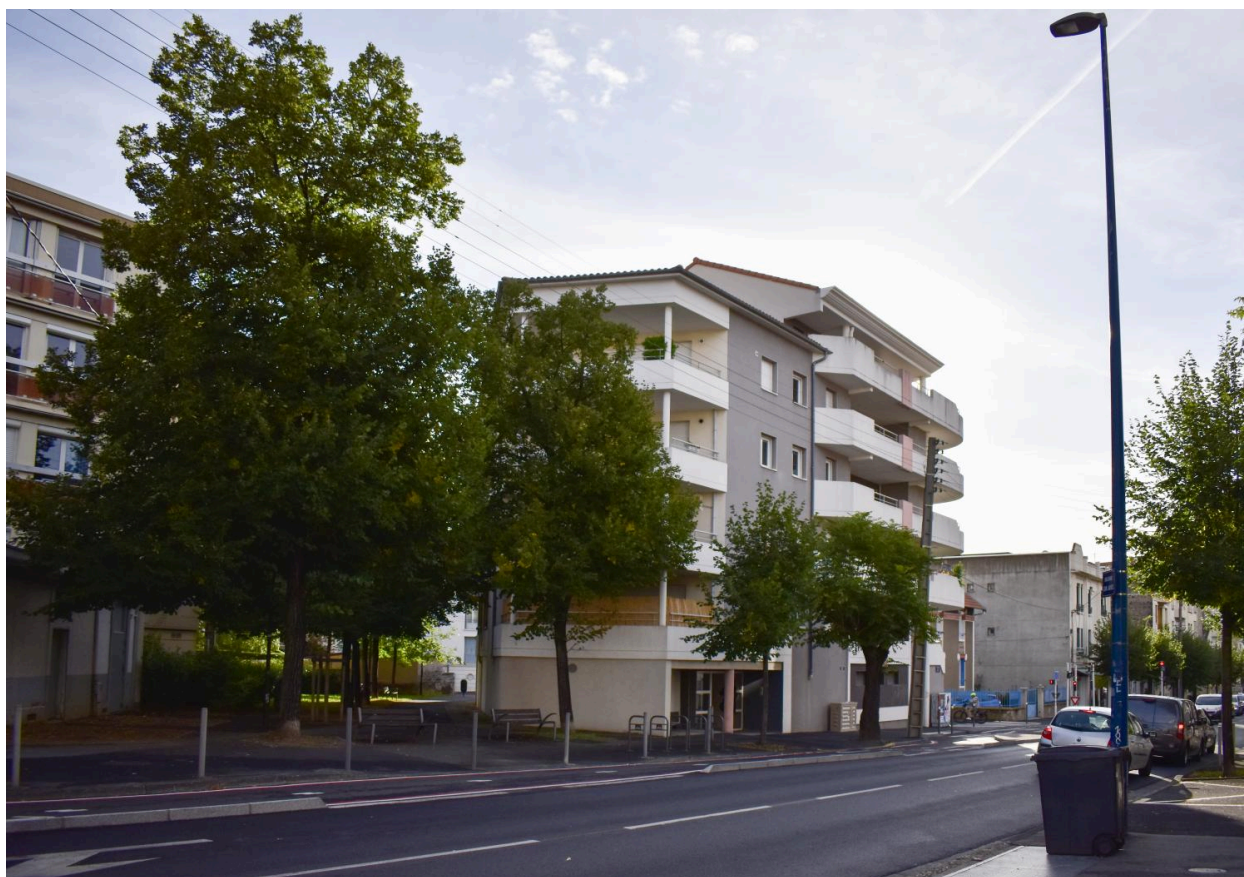
Travée d'angle ouest et façade sur le boulevard
