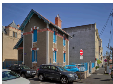
Contexte urbain, vis-à-vis oriental. Façade et jardin latéral Phot. Christian Parisey IVR84_20236300396NUC4A
