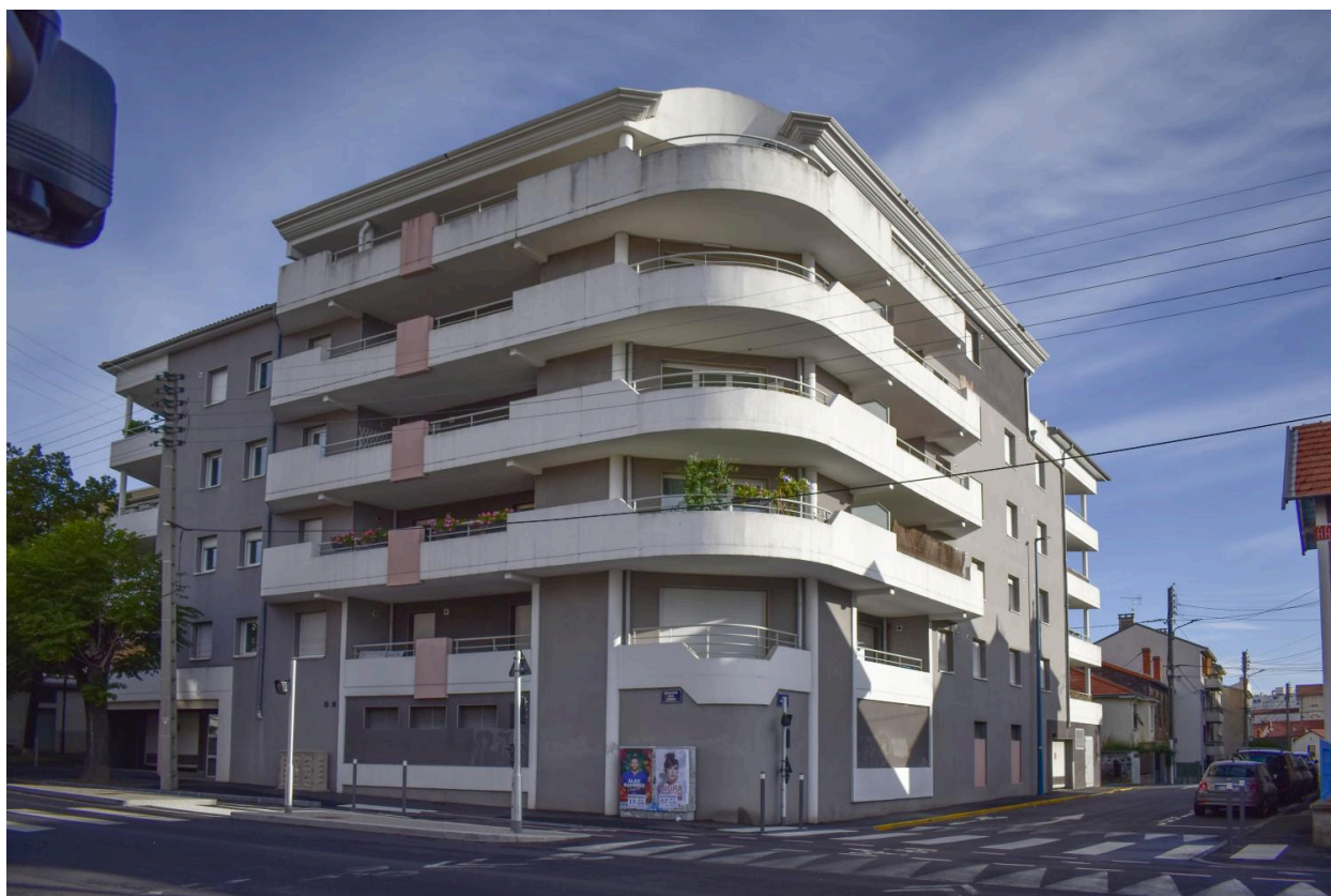
Travée d'angle est et façade sur le boulevard
