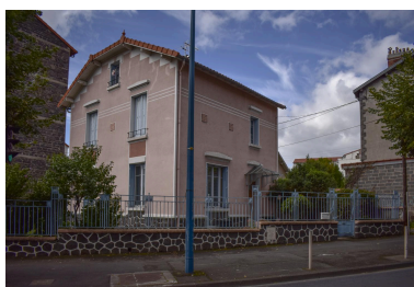
Contexte urbain, vis-à-vis méridional. Façade vers la rue André- Theuriet et élévation latérale sur le boulevard Jean-Jaurès Phot. Félicie Fougère IVR84_20256302181NUCA
