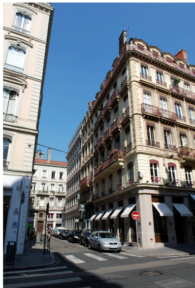
Vue de situation depuis la rue du Président-Edouard-Herriot Phot. Véronique Belle IVR82_20096904804NUCA
