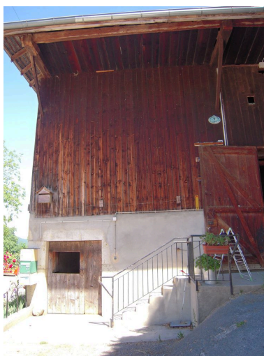
Vue de la partie ouest de la façade principale donnant sur la première étable. Phot. Clémence Serve IVR82_20117400862NUCA
