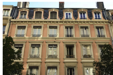
Façades 5 et 7, rue Mercière, partie supérieure Phot. Bernard Ducouret IVR82_20046900974NUCA
