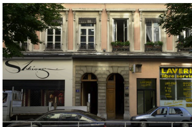
Façades 5 et 7, rue Mercière, détail des deux premiers niveaux Phot. Bernard Ducouret IVR82_20046900973NUCA
