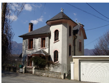
Façade sur rue Phot. François Fouger IVR82_20097300546NUCA
