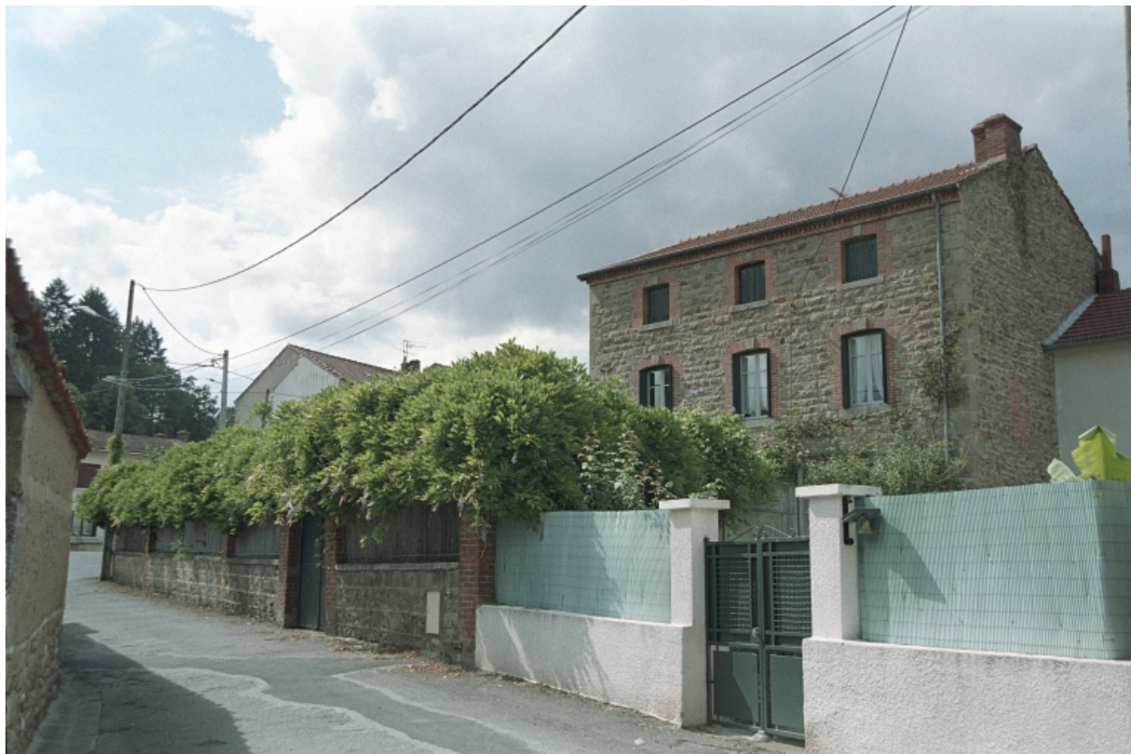
Au Bourg, maison d'industriel (1986 C2 958). Bâtiment en moellons avec baie à encadrements et corniche en brique chaîne d'angle en pierre de taille. Vue d'ensemble de trois-quart latéral droit.
