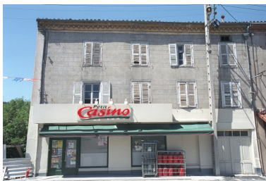
Au Bourg, maison avec commerce (1986 C2 1290). Bâtiment avec enduit à faux appareillage et génoise. Vue d'ensemble de face donnant sur la place de l'église. Phot. Thierry Monnet IVR82_20034201945ZE
