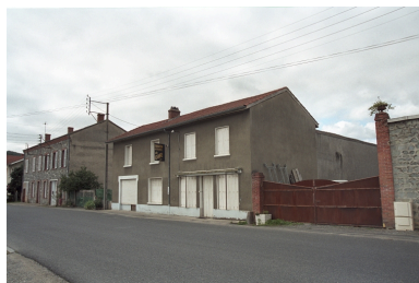
A la Gare, commerce à encadrements en bois, vue d'ensemble de trois-quarts (1986 A 1049). Phot. Thierry Monnet IVR82_20034200884ZE
