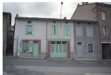
Au Bourg, ancien commerce (1986 C2 779, 780). Bâtiment datant de la dème moitié du 19e siècle, ancienne ferme (?) remaniée avec reperçement de baies à encadrement de brique pour en faire un commerce. Bâtiment aujourd'hui divisé en deux parcelles. Phot. Thierry Monnet IVR82_20034200882ZE
