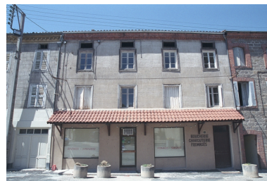
Au Bourg, maison avec commerce (1986 C2 724). Bâtiment avec enduit à faux appareillage et génoise. Vue d'ensemble de face donnant sur la place de l'église. Phot. Thierry Monnet IVR82_20034201946ZE
