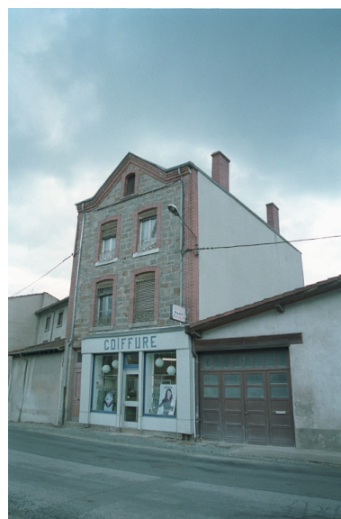
Aux Promenades, maison et commerce (1986 B2 928). Bâtiment en moellons, encadrements, chaîne d'angle et corniche en brique ; fronton triangulaire pour l'étage de combles. Vue d'ensemble de trois-quarts latérale droite. Phot. Thierry Monnet IVR82_20034200782ZE
