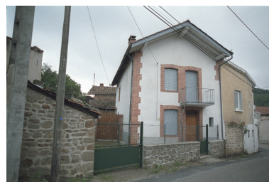
Goutard, maison (1986C2 1052). Bâtiment à encadrements et chaîne d'angle en brique. Vue d'ensemble de trois-quarts. Phot. Thierry Monnet IVR82_20034200786ZE
