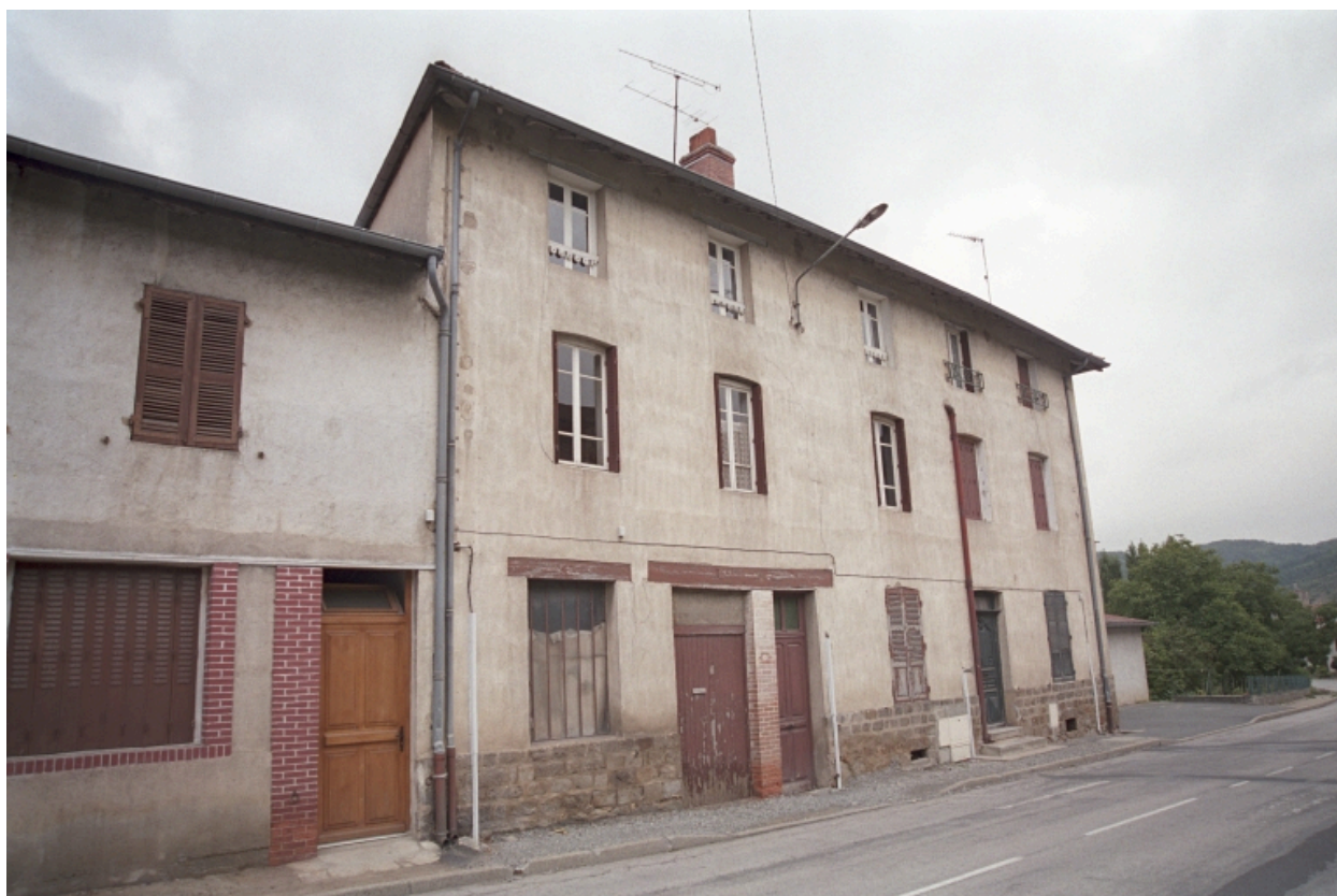
Croix Besson, maison et commerce (1986 B2 1012, 1013). Bâtiment en pisé enduit ; rez-de-chaussée modifié. Vue d'ensemble de trois-quarts latérale gauche.
