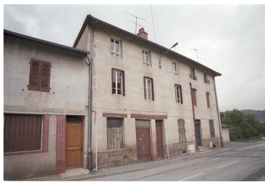
Croix Besson, maison et commerce (1986 B2 1012, 1013). Bâtiment en pisé enduit ; rez-de-chaussée modifié. Vue d'ensemble de trois-quarts latérale gauche. Phot. Thierry Monnet IVR82_20034200783ZE
