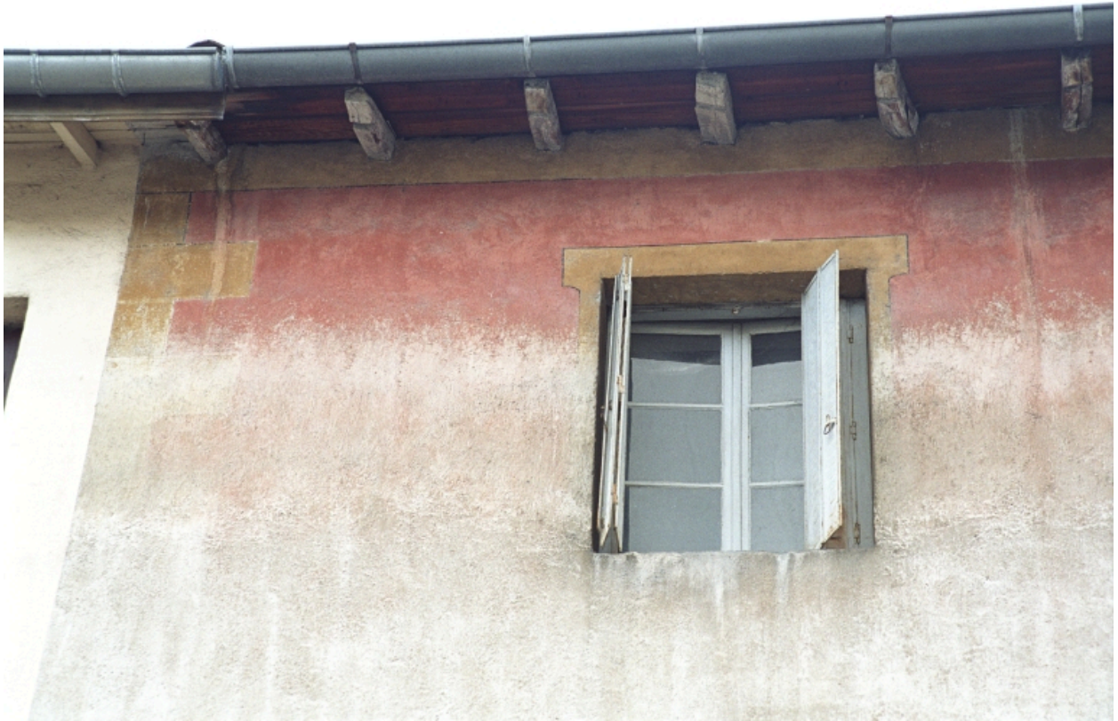
Le Bourg, Maison avec commerce alimentaire (1986 C2 709), vue partielle de la partie haute avec le décor peint (encadrement des baies, faux chaînage d'angle)
