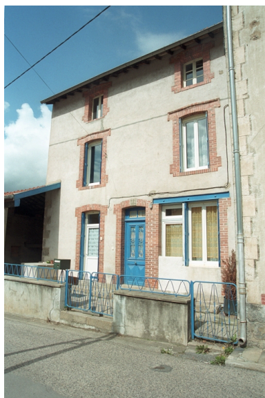
Au Bourg, maison (1986 C2 959, 1202). Vue d'ensemble de la façade principale. Phot. Thierry Monnet IVR82_20034200757ZE
