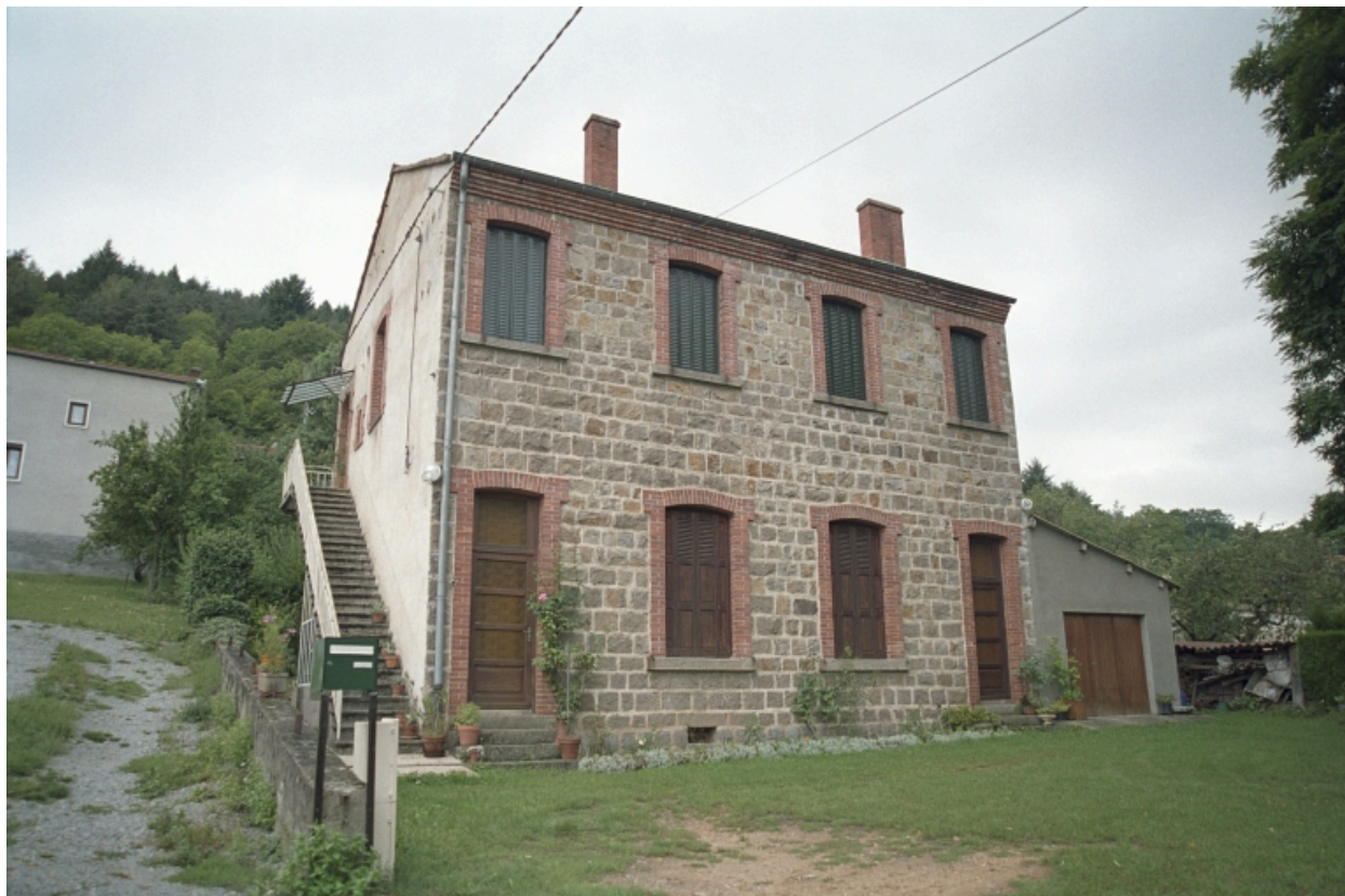
Goutard, maison à double logis (1986 C2 1035). Bâtiment en moellons, avec encadrements, corniche et chaînage d'angle en brique. Vue d'ensemble de trois-quarts avant gauche.
