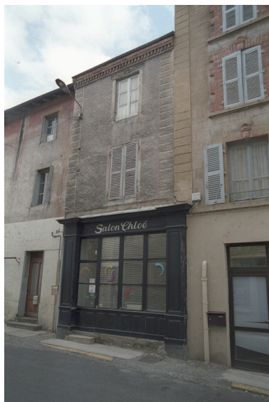
Au Bourg, maison et commerce (1986 C2 710). Bâtiment à encadrements et devanture en bois ; enduit ciment gravé d'une fausse chaîne d'angle. Phot. Thierry Monnet IVR82_20034200881ZE
