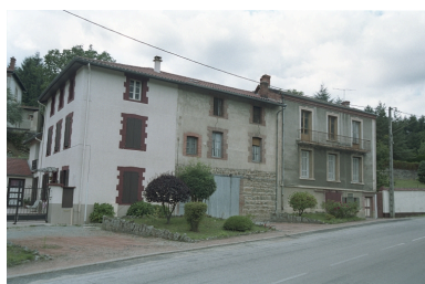
Aux Promenades, maison (1986 B2 901). Bâtiment enduit ciment, décor peint en trompe l'oeil : encadrement mouluré. Vue d'ensemble de face. Phot. Thierry Monnet IVR82_20034200789ZE
