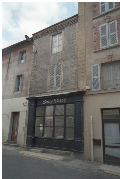
Au Bourg, maison et commerce (1986 C2 710). Bâtiment à encadrements et devanture en bois ; enduit ciment gravé d'une fausse chaîne d'angle. Phot. Thierry Monnet IVR82_20034200881ZE
