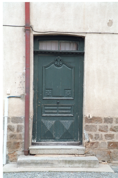
Croix Besson, maison et commerce (1986 B2 1012, 1013). Bâtiment en pisé enduit ; rez-de-chaussée modifié. Détail de la porte d'entrée. Phot. Thierry Monnet IVR82_20034200784ZE
