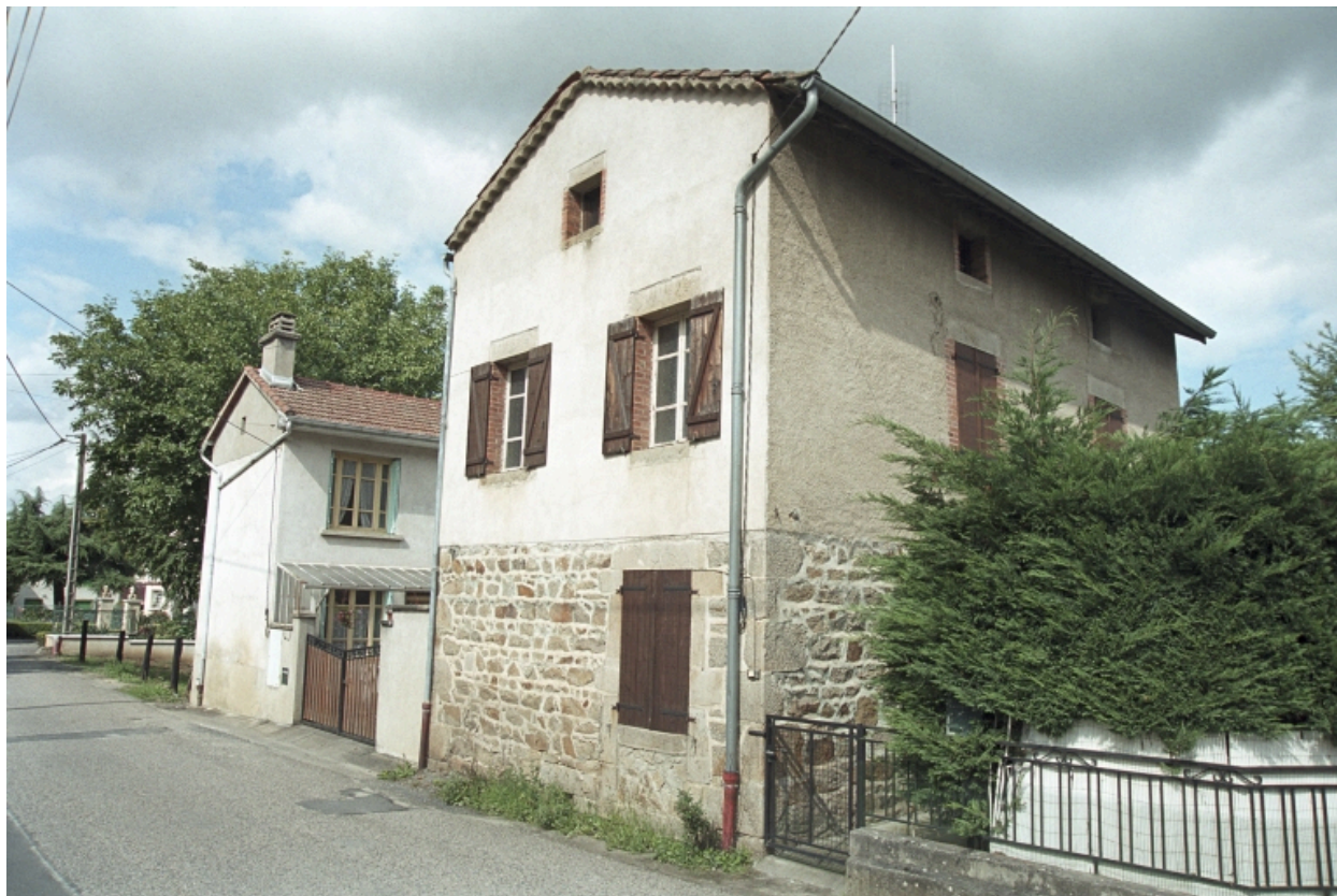
Au Bourg, maison datée 1885 (1986 C2 1025). Vue d'ensemble de trois quarts.
