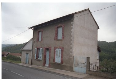
Maison au Gipaud (1986 C2 697). Vue d'ensemble de trois-quarts. Phot. Thierry Monnet IVR82_20034200787ZE
