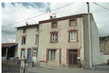
Au Bourg, maison (1986 C2 956). Bâtiment en moellons avec fausse chaîne d'angle à redants peints en trompe-l'oeil, encadrements en brique, rez-de-chaussée remanié. Vue d'ensemble de trois-quarts latérale droite. Phot. Thierry Monnet IVR82_20034200780ZE
