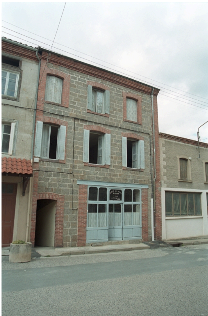
Au Bourg, maison avec commerce (1986 C2 725). Bâtiment en moellons avec chaîne d'angle et corniche en brique. Vue d'ensemble de face.
