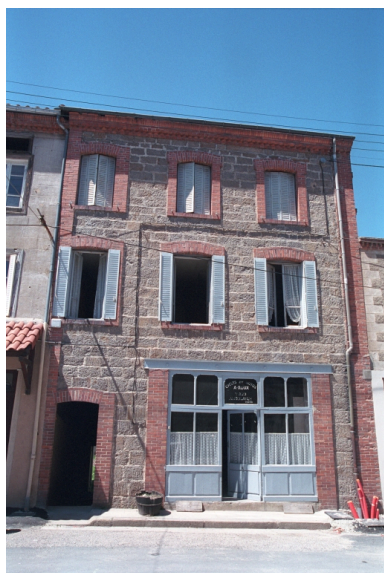
Au Bourg, maison avec commerce (1986 C2 725). Bâtiment en pierre de taille avec encadrement et corniche en brique. Vue d'ensemble de face donnant sur la place de l'église. Phot. Thierry Monnet IVR82_20034201947ZE
