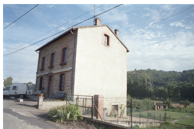
Goutard, maison (1986 C2 1412 a). Bâtiment en moellons avec baie à encadrements en brique sur la façade avant, pisé pour les autres, chaîne d'angle en pierre de taille. Vue d'ensemble de trois-quart latéral droit. Phot. Thierry Monnet IVR82_20034200794ZE
