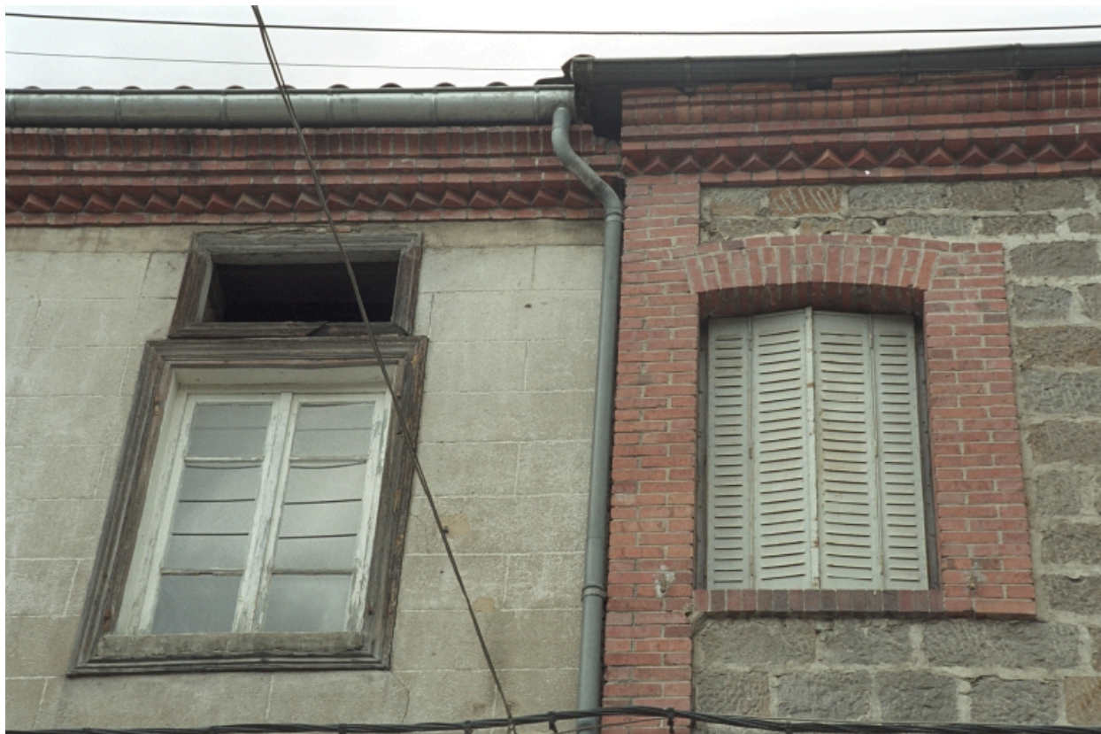
Au Bourg, maison avec commerce (1986 C2 725). Bâtiment en moellons avec chaîne d'angle et corniche en brique. Détail des baies et corniches.
