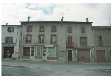
Aux Promenades, maison et commerce (1986 B2 953). Bâtiment à encadrements de brique dans sa partie gauche, enduite ciment avec faux appareillage gravé, partie droite de l'édifice plus récente. Vue d'ensemble de face.
