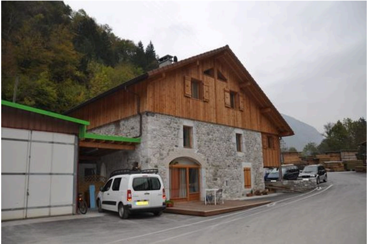
Elévation sud-ouest du bâtiment du moulin
