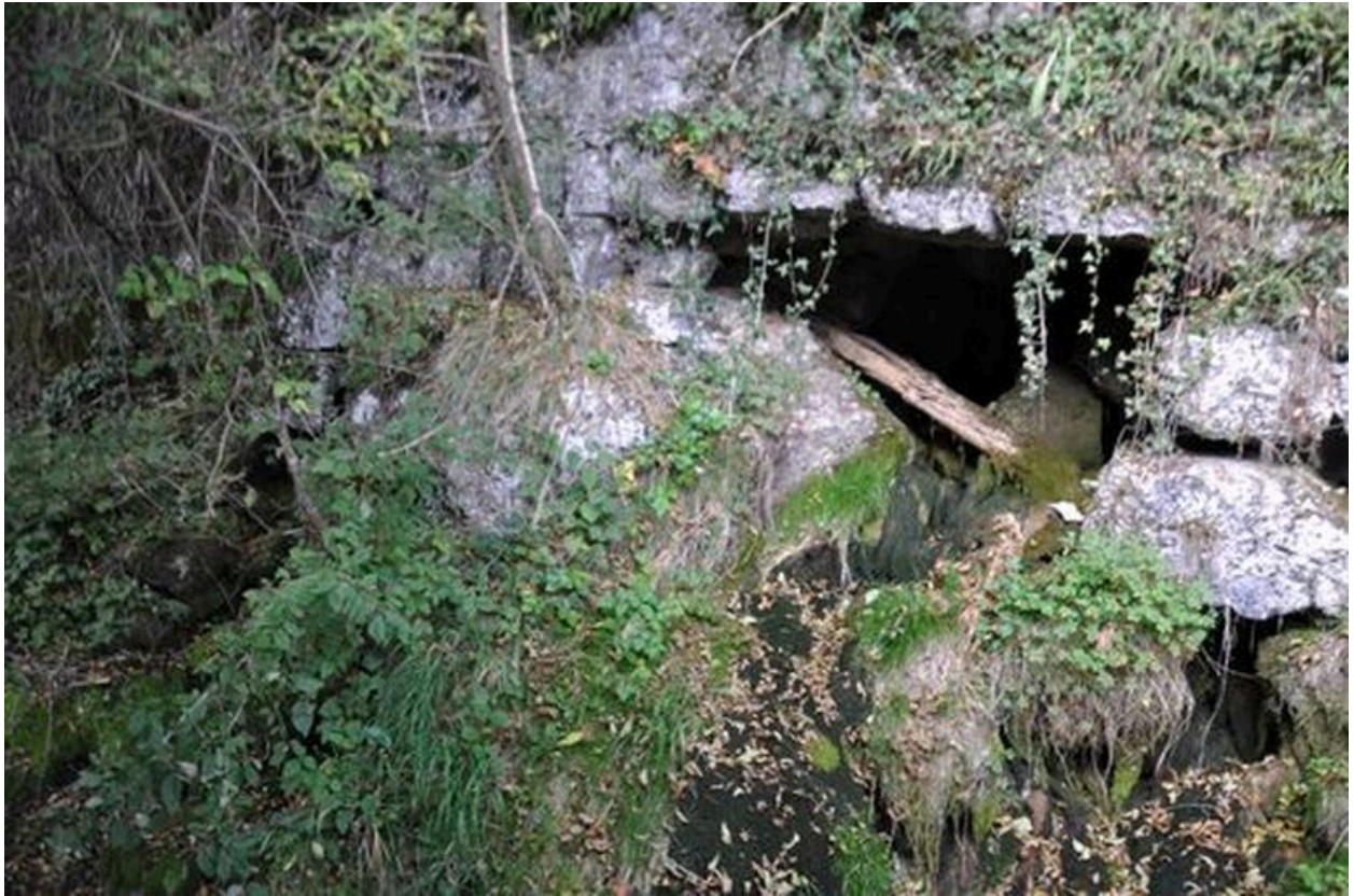
Ancien canal souterrain de la cascade de Morette
