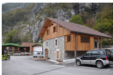
Elévation sud-est du bâtiment du moulin Phot. Samir Mahfoudi, Autr. Samir Mahfoudi IVR82_20107403105NUCA
