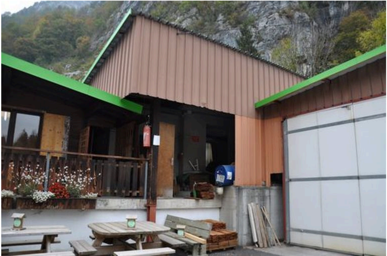
Entrée de la centrale hydroélectrique
