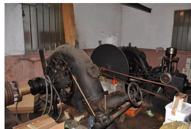
Groupe de deux turbine Magnat- Simon de la centrale hydro-électrique Phot. Samir Mahfoudi, Autr. Samir Mahfoudi IVR82_20107403110NUCA
