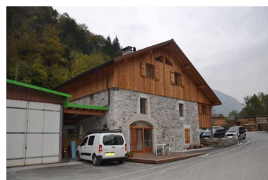
Elévation sud-ouest du bâtiment du moulin Phot. Samir Mahfoudi, Autr. Samir Mahfoudi IVR82_20107403107NUCA
