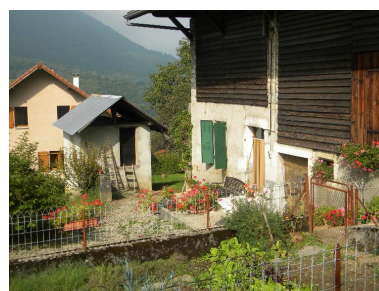
Vue du grenier près de la ferme. Phot. Jérôme Daviet IVR82_20157401783NUCA
