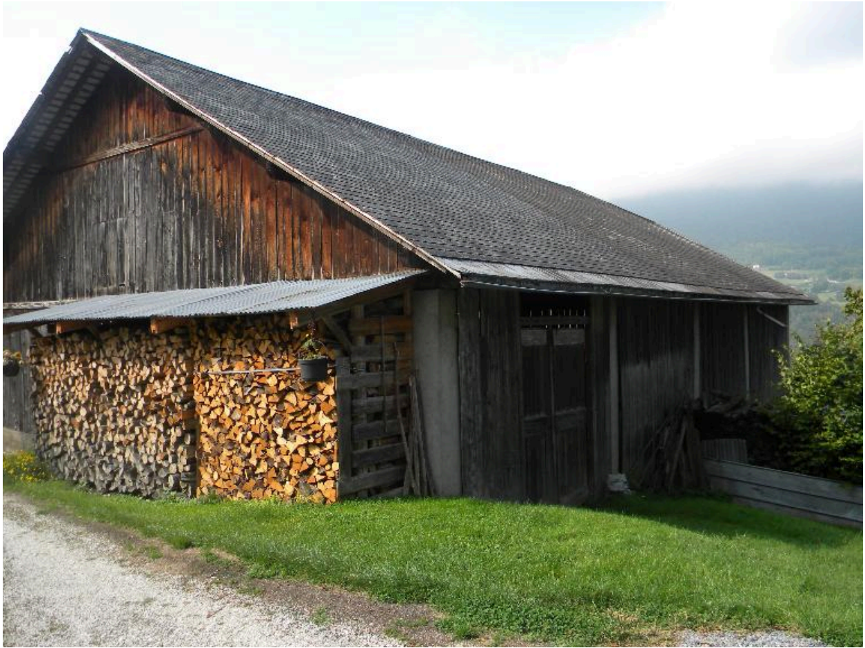
Vue de la façade arrière.
