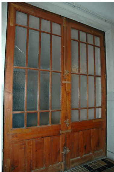
Porte ouvrant sur la cour Phot. Maryannick Chalabi IVR82_20076900308NUCA
