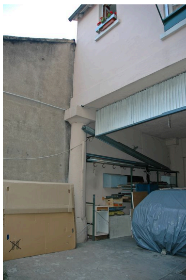
Loge de concierge. Angle sud-ouest reposant sur une colonne en pierre Phot. Maryannick Chalabi IVR82_20076900305NUCA
