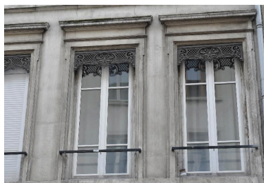
Vue rapprochée des fenêtres Phot. Magali Delavenne IVR82_20146902939NUCA
