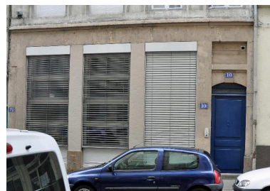
Vue rapprochée du rez-de-chaussée Phot. Magali Delavenne IVR82_20146902938NUCA
