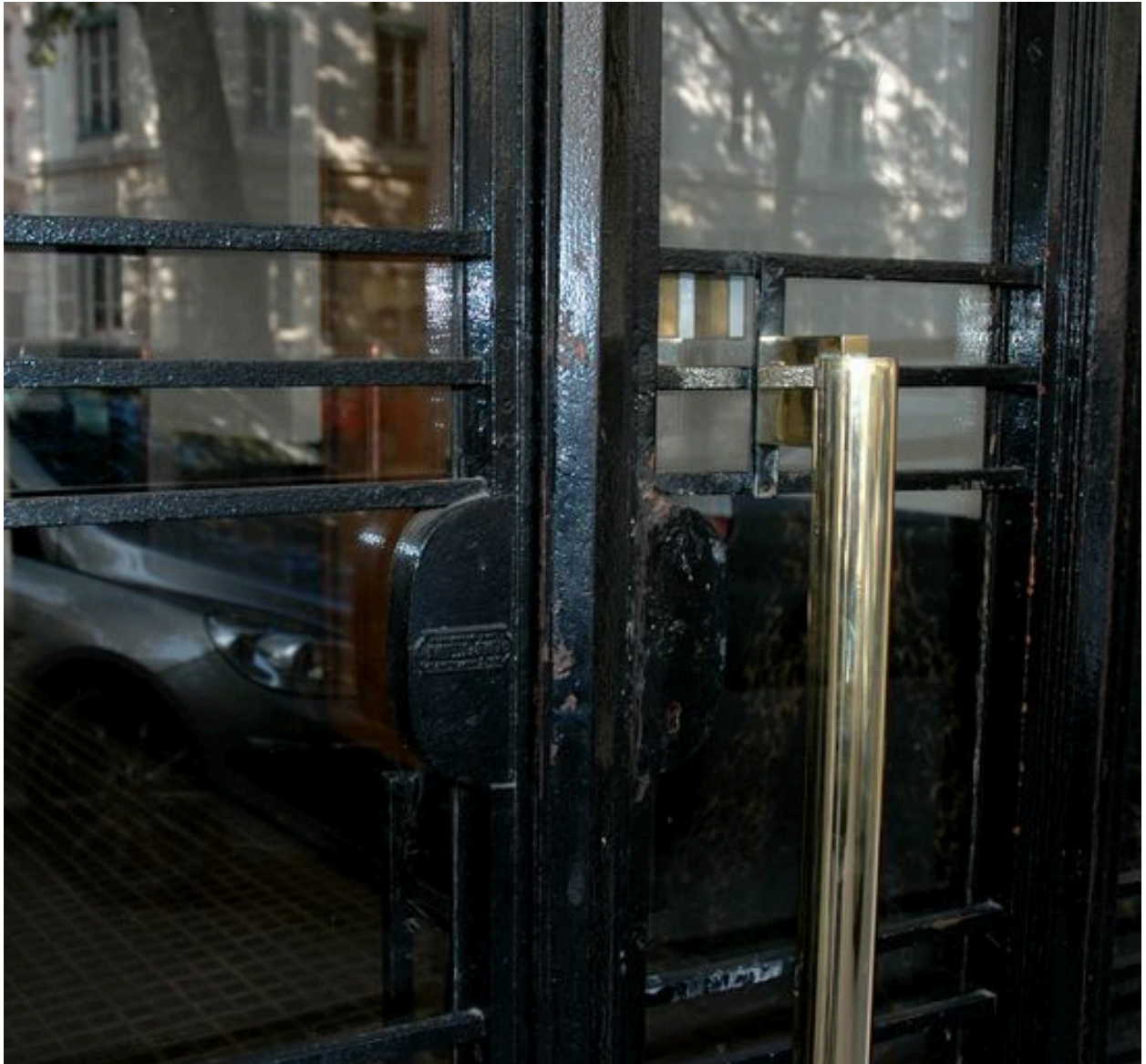
Porte d'entrée : détail de la serrure
