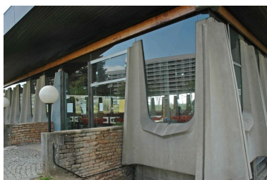
Façade postérieure Phot. Didier Gourbin IVR82_20066902166NUCA
