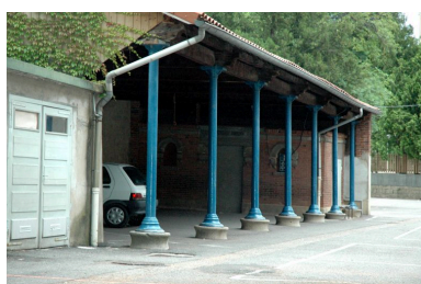
Préau sur colonnettes en fonte. Phot. Simone Hartmann-Nussbaum IVR82_20134200646NUCA
