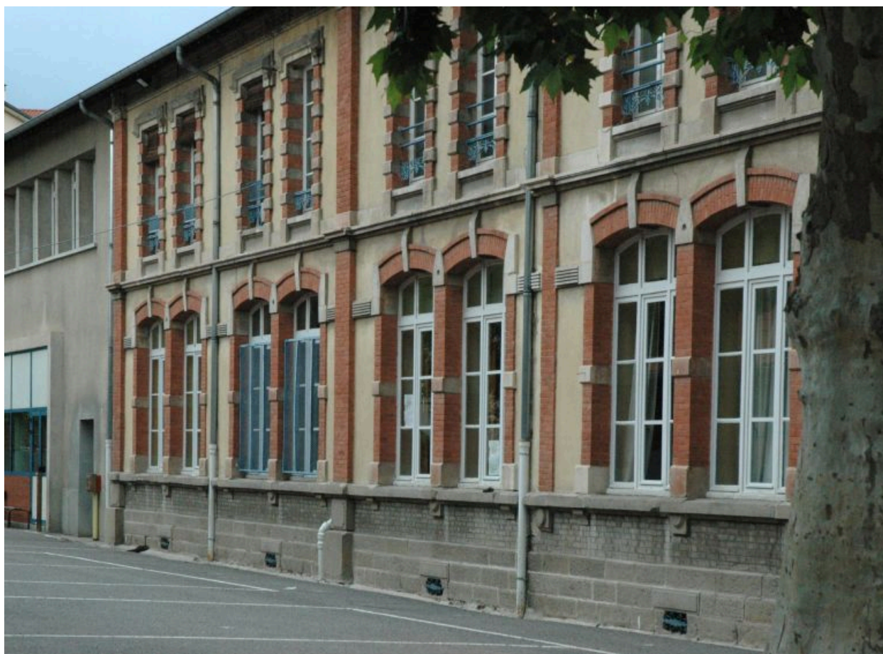
Vue partielle de l'élévation sur cour.
