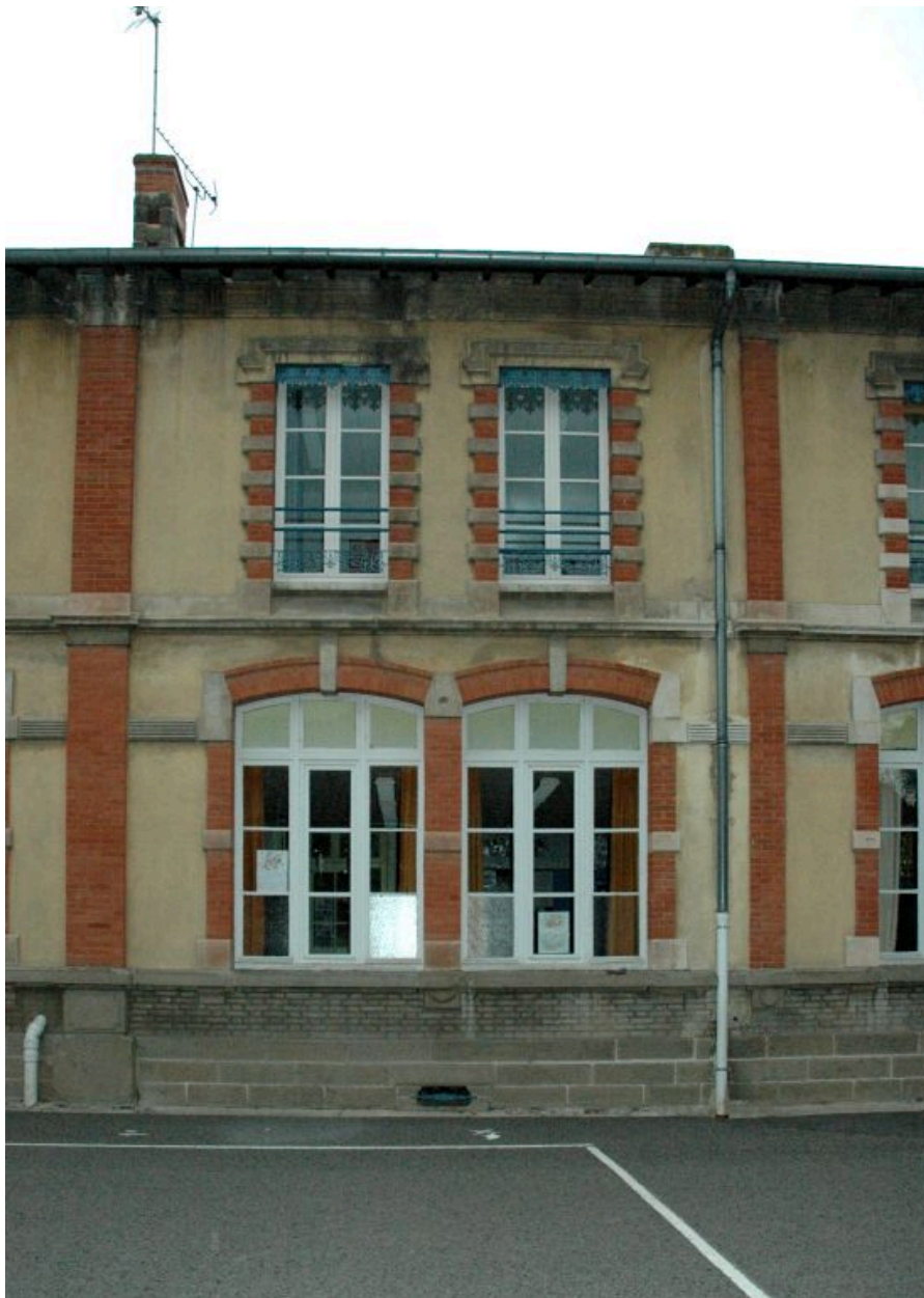
Vue d'une travée jumelée.
