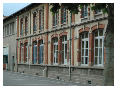
Vue partielle de l'élévation sur cour. Phot. Simone Hartmann-Nussbaum IVR82_20134200644NUCA
