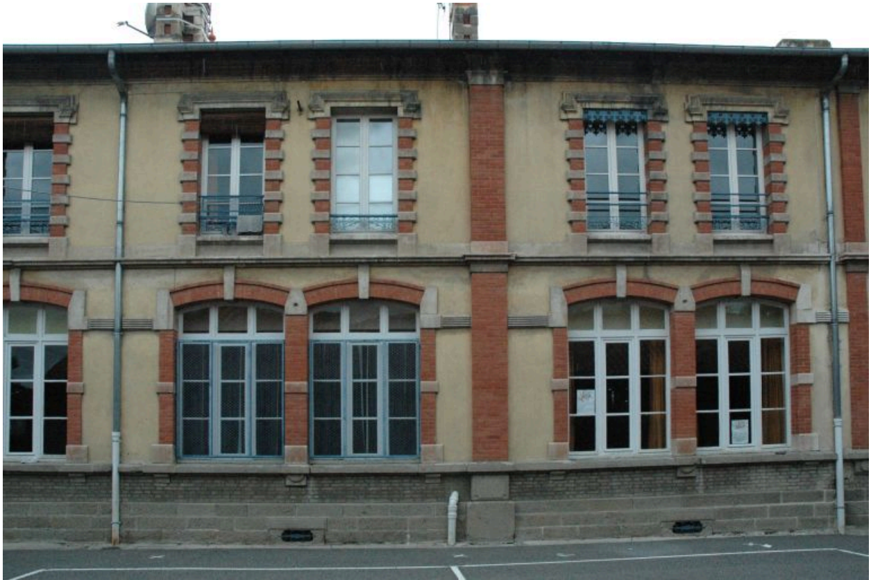
Vue partielle des travées jumelées.
