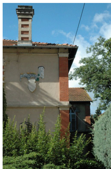
Chaîne d'angle en brique. Phot. Simone Hartmann-Nussbaum IVR82_20134200648NUCA
