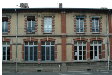
Vue partielle des travées jumelées. Phot. Simone Hartmann-Nussbaum IVR82_20134200643NUCA
