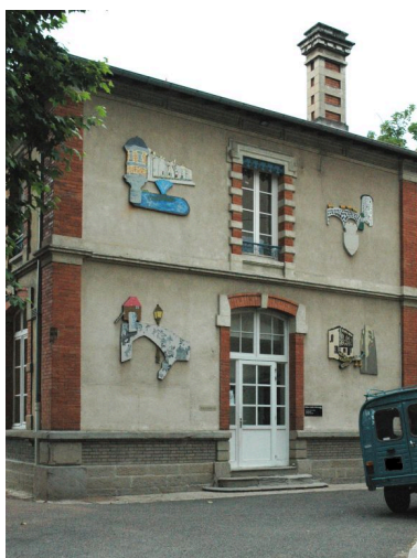
Elévation sur le boulevard. Phot. Simone Hartmann-Nussbaum IVR82_20134200645NUCA
