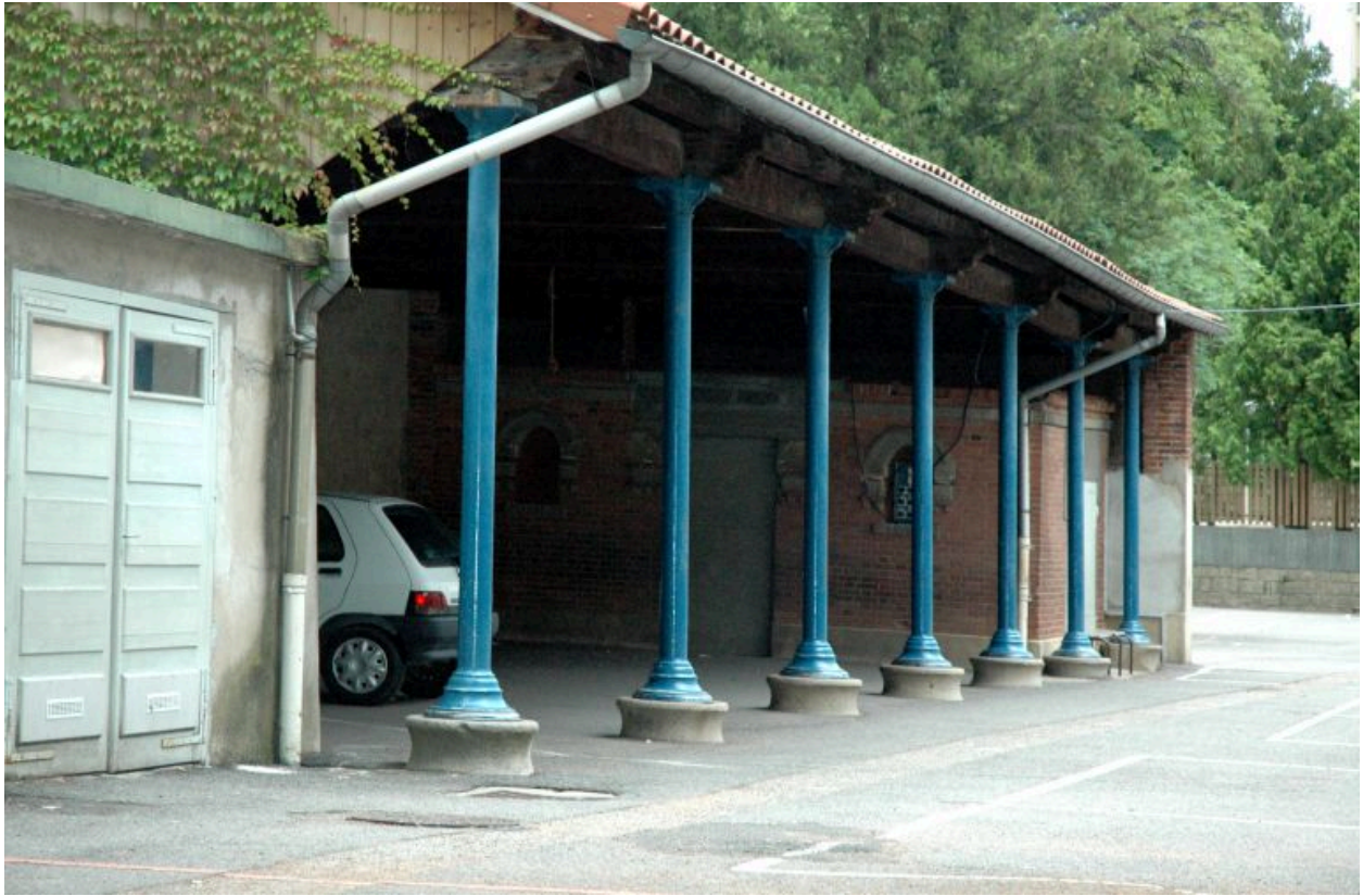
Préau sur colonnettes en fonte.
