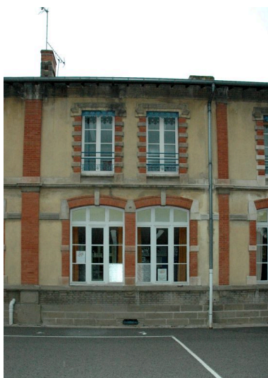
Vue d'une travée jumelée. Phot. Simone Hartmann-Nussbaum IVR82_20134200642NUCA
