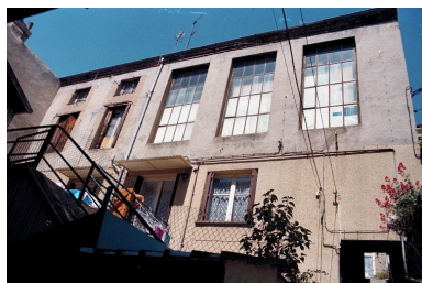
Façade principale de l'immeuble situé en milieu de parcelle Phot. Cendrine Sanquer IVR82_19974201951ZE
