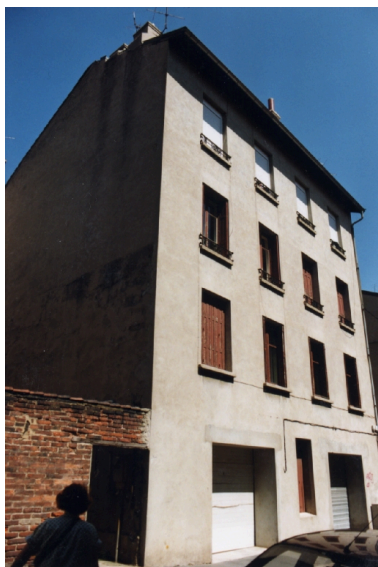
Façade principale Phot. Cendrine Sanquer IVR82_19974202108ZE
