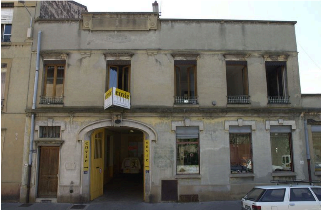
Vue de la façade du bâtiment principal
