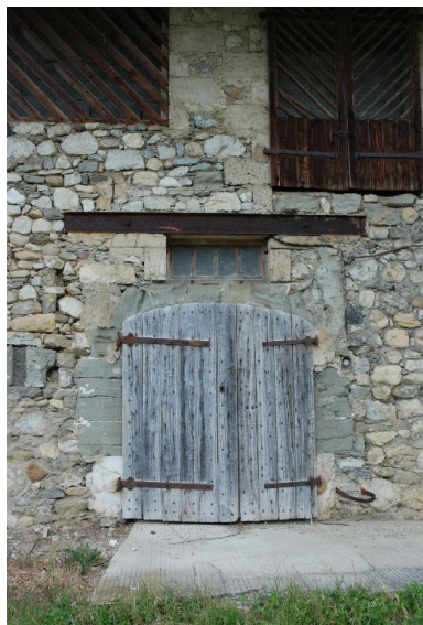
Détail : porte de l'étable. Phot. Caroline Guibaud IVR82_20157303089NUCA
