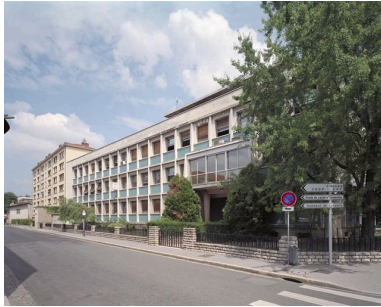
Vue générale de la façade principale sur la rue Philippe-de-Lassalle
