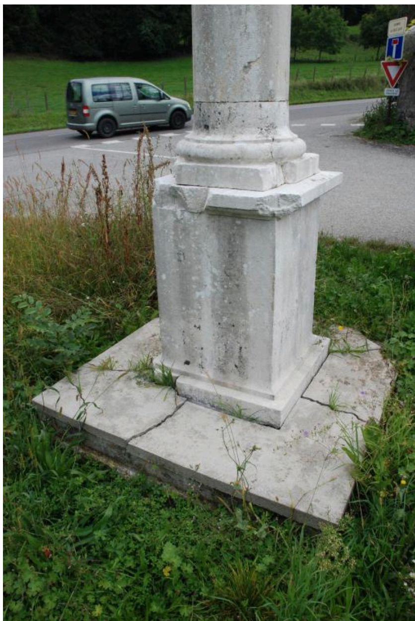
Détail arrière du piédestal de la croix.
