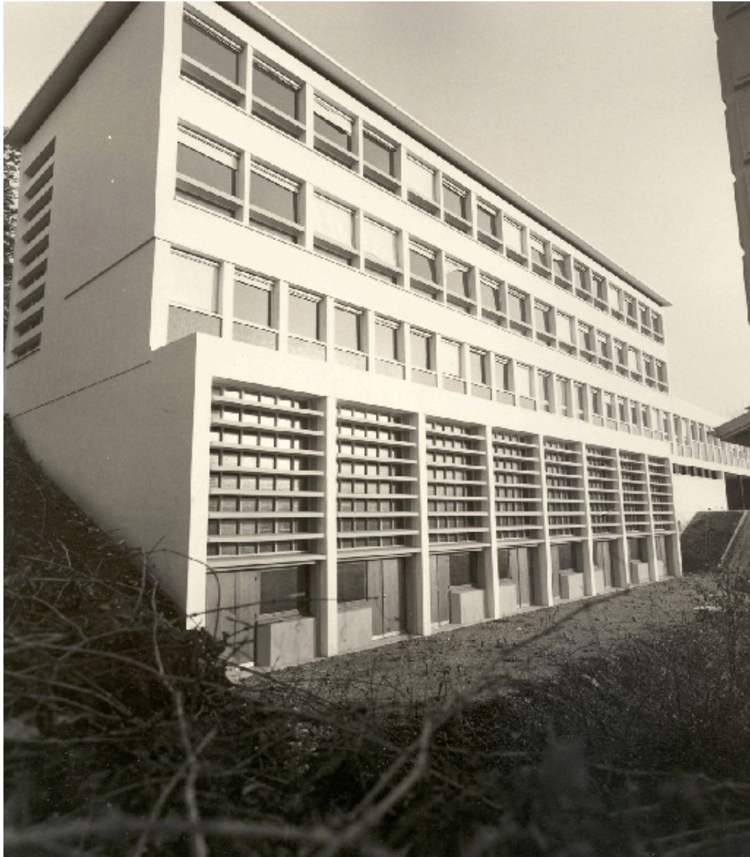
Bâtiment de 1962 : façade sur jardin
