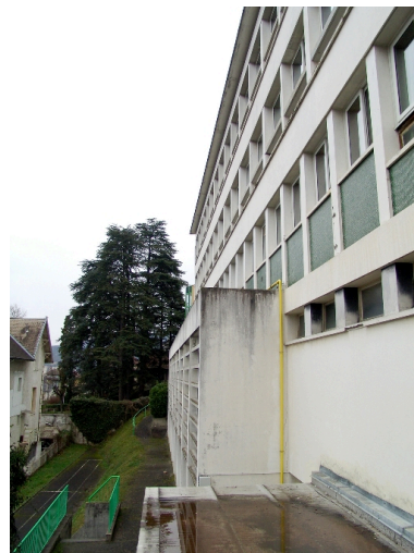
Bâtiment de 1962 : façade sur jardin Phot. François Fouger IVR82_20077300084NUCA
