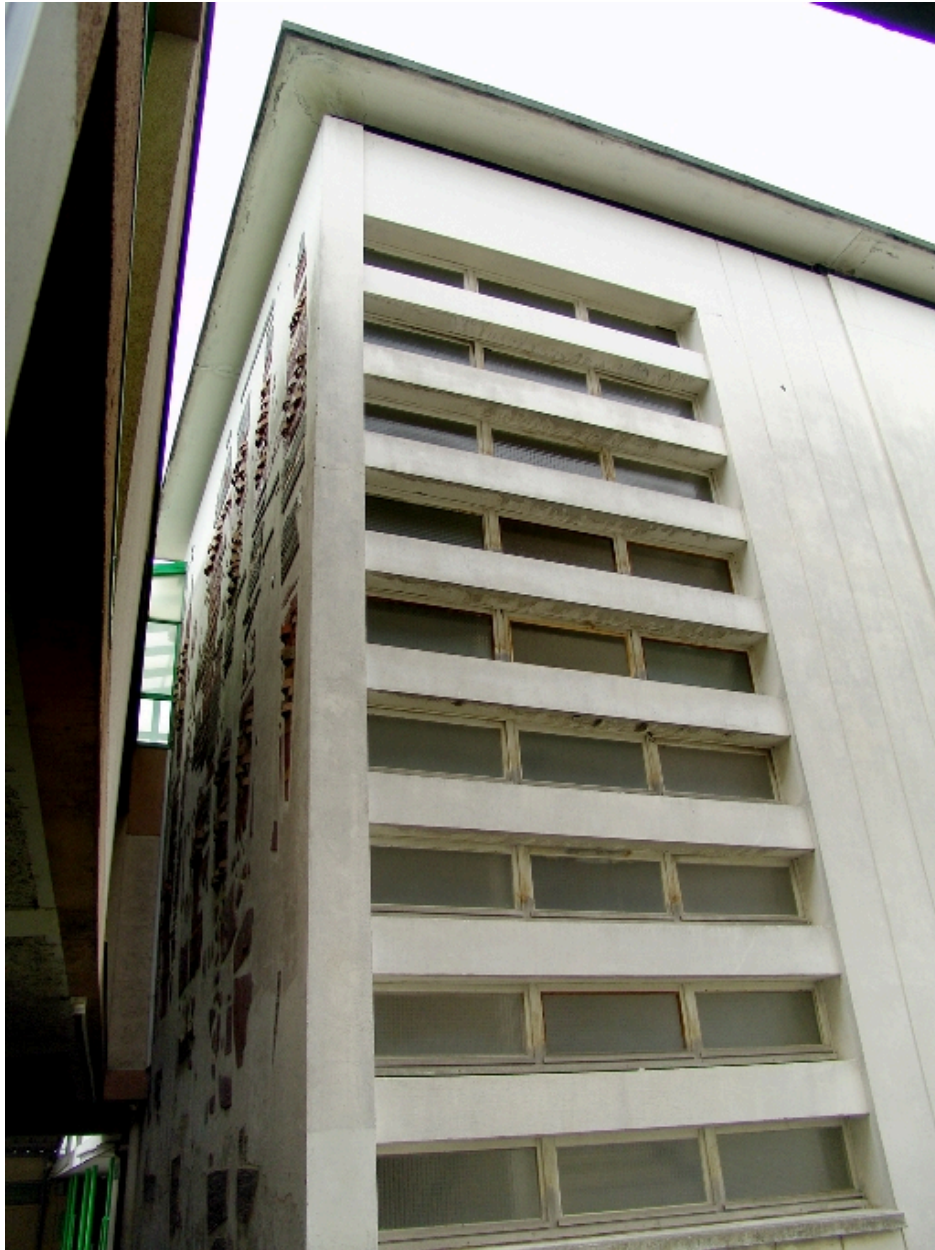
Bâtiment de 1962 : baies de la cage d'escalier
