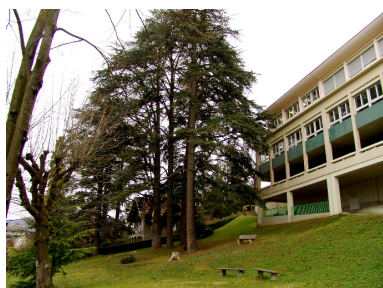
Bâtiment de 1992 : élévation ouest sur jardin Phot. François Fouger IVR82_20077300078NUCA
