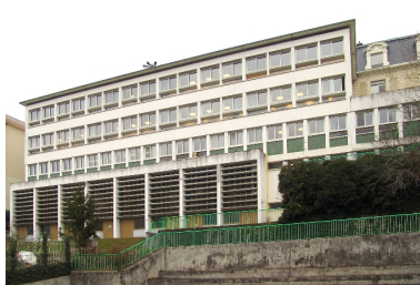
Bâtiment de 1962 : façade sur jardin, partie nord Phot. François Fouger IVR82_20077300086NUCA
