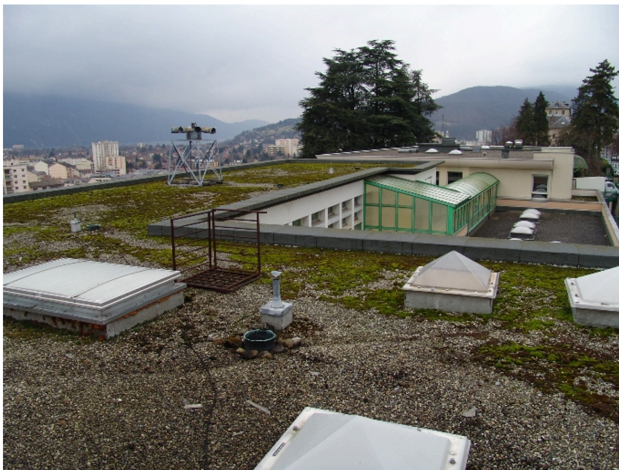
Bâtiment de 1962 : vue des terrasses
