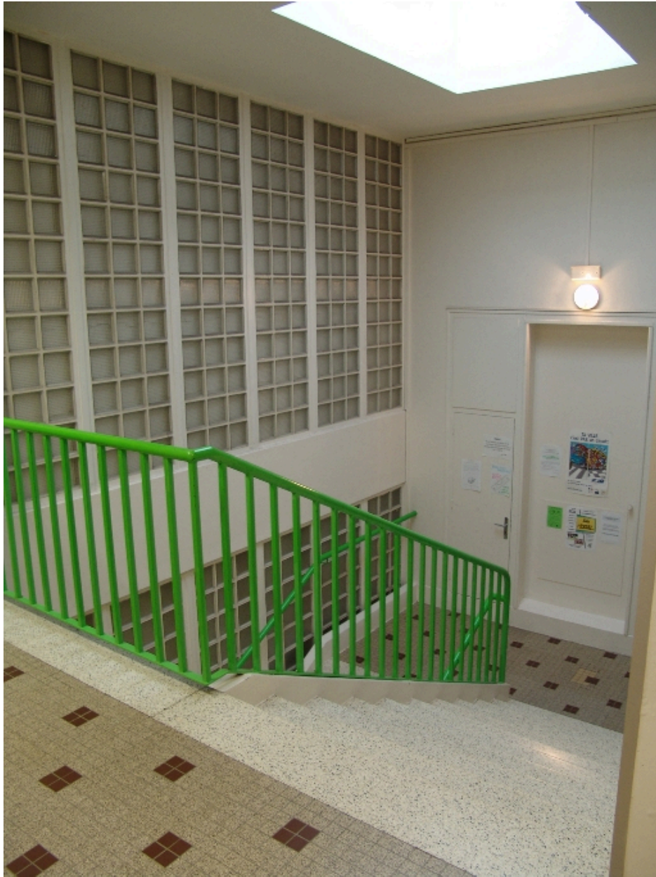
Bâtiment de 1962 : escalier intérieur
