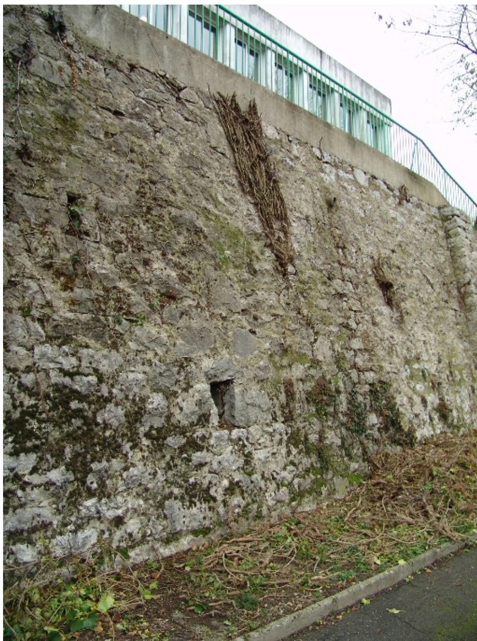
Bâtiment de 1962 : mur de soutènement
