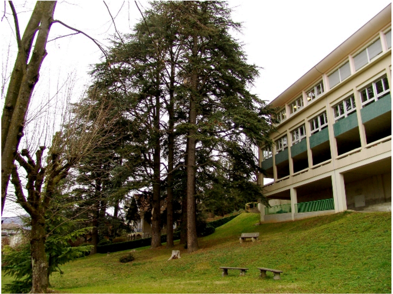
Bâtiment de 1992 : élévation ouest sur jardin
