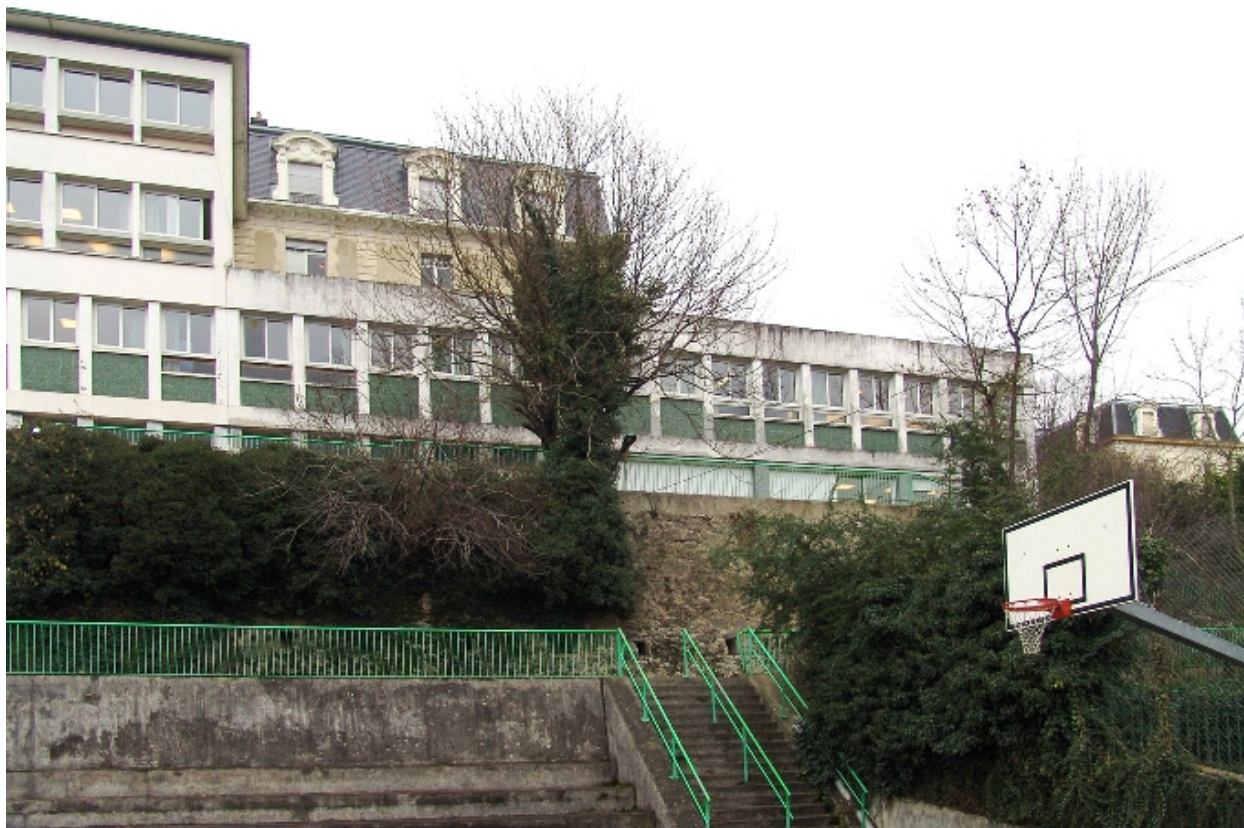
Bâtiment de 1962 : façade sur jardin, partie sud
