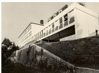
Bâtiment de 1962 : vue d'ensemble prise du sud-ouest Repro. François Fouger IVR82_20077300107NUCB
