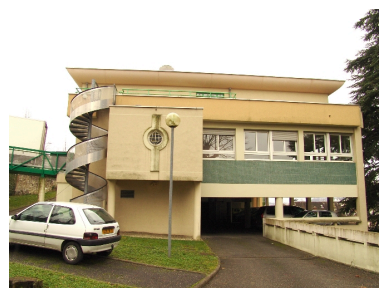
Bâtiment de 1992 : élévation nord Phot. François Fouger IVR82_20077300077NUCA
