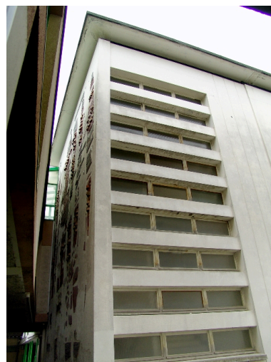
Bâtiment de 1962 : baies de la cage d'escalier Phot. François Fouger IVR82_20077300076NUCA
