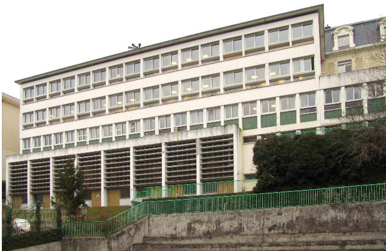
Bâtiment de 1962 : façade sur jardin, partie nord
