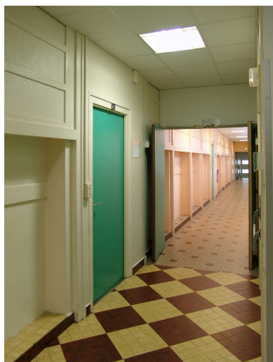
Bâtiment de 1962 : couloir Phot. François Fouger IVR82_20077300089NUCA
