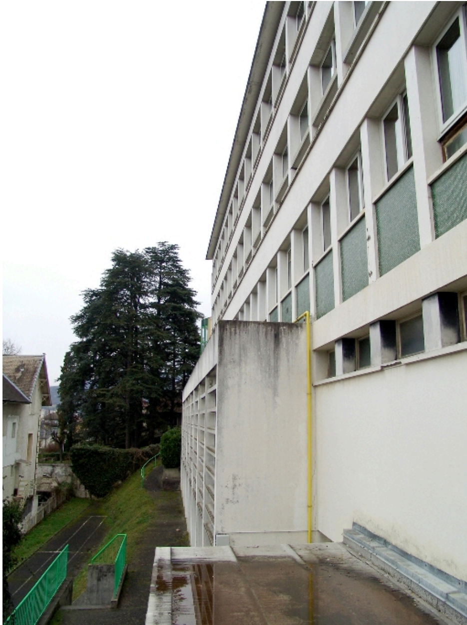
Bâtiment de 1962 : façade sur jardin
