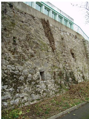
Bâtiment de 1962 : mur de soutènement Phot. François Fouger
