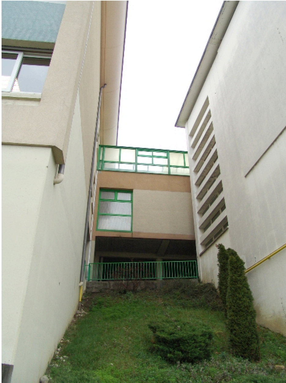
Jonction entre les deux bâtiments
