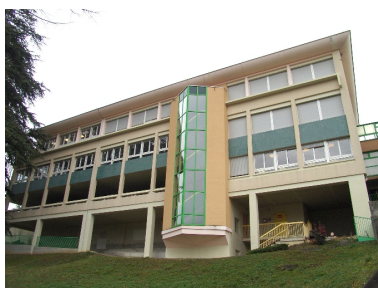
Bâtiment de 1992 : élévation ouest Phot. François Fouger IVR82_20077300082NUCA
