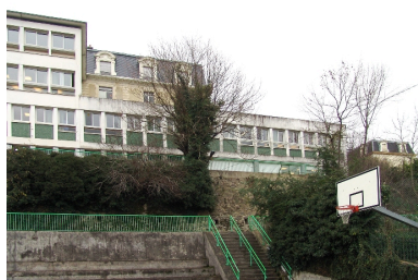
Bâtiment de 1962 : façade sur jardin, partie sud Phot. François Fouger IVR82_20077300085NUCA
