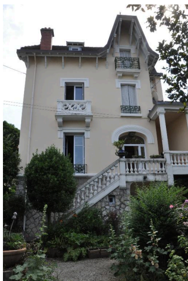
Elévation principale orientée à l'ouest Phot. Denys Harreau IVR82_20137300693NUCA
