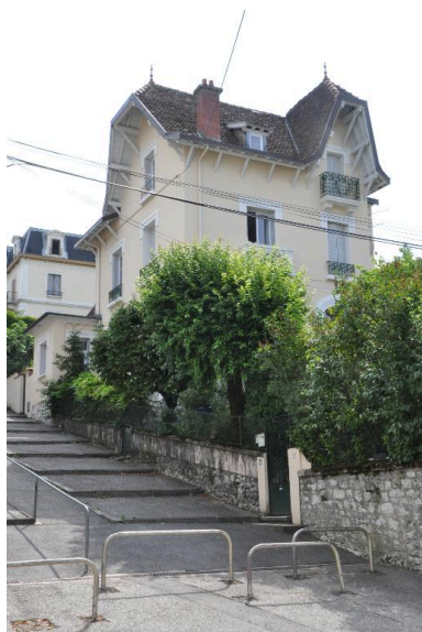
Vue d'ensemble depuis le bas de la montée Léon-Cléry Phot. Denys Harreau IVR82_20137300698NUCA
