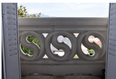
Les rosaces en ciment moulé du balcon vues depuis l'intérieur Phot. Denys Harreau IVR82_20137300683NUCA
