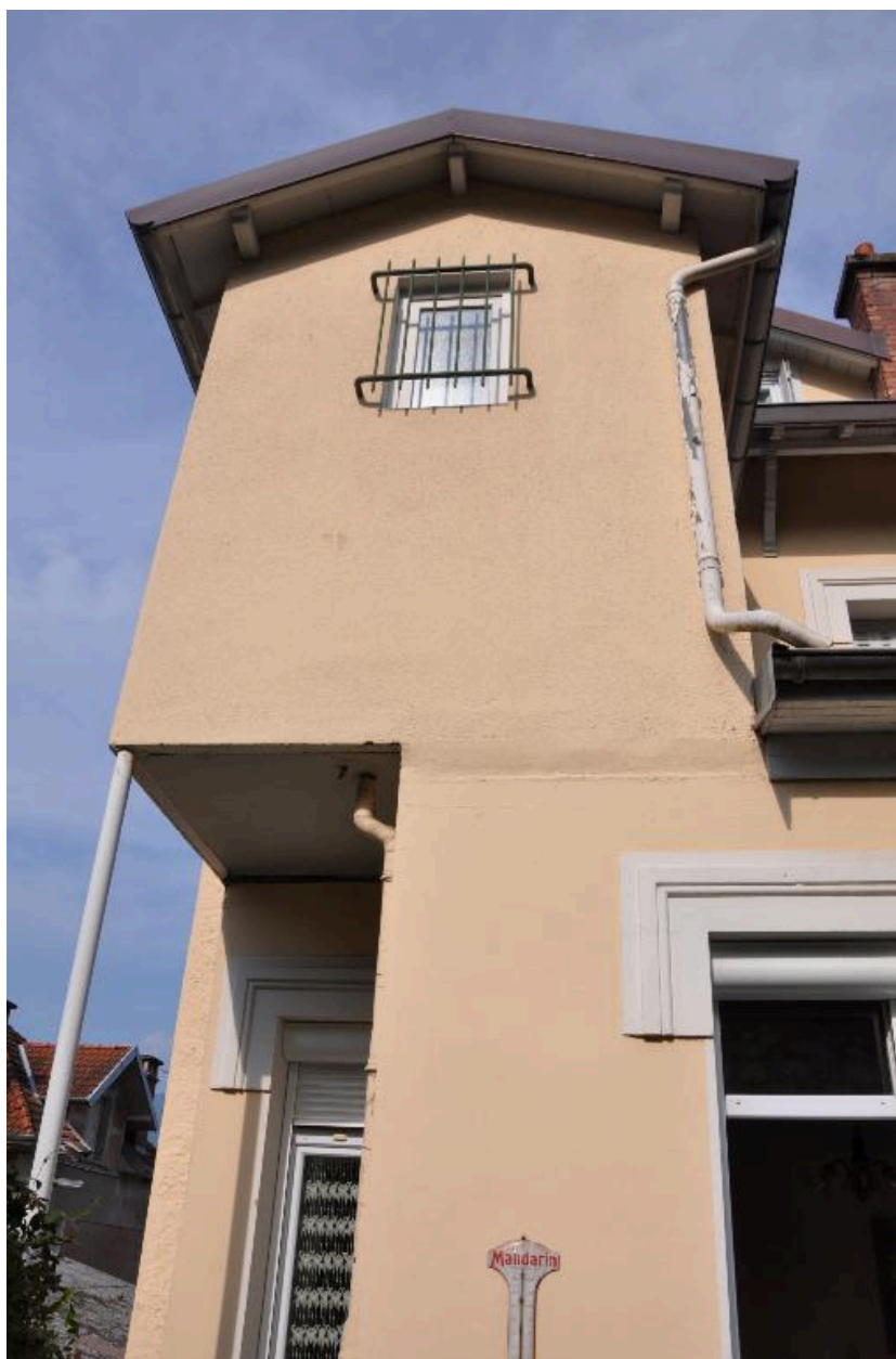
Logette sur l'élévation orientale
