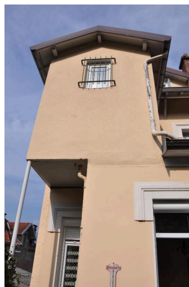
Logette sur l'élévation orientale Phot. Denys Harreau IVR82_20137300682NUCA
