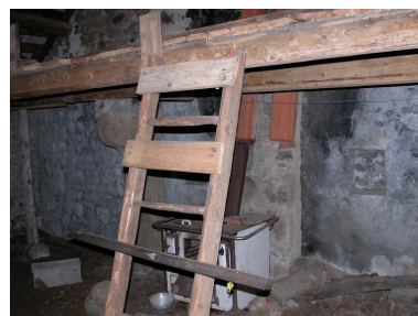
Vue intérieure de la logette. Phot. Caroline Guibaud IVR82_20124201467NUCA
