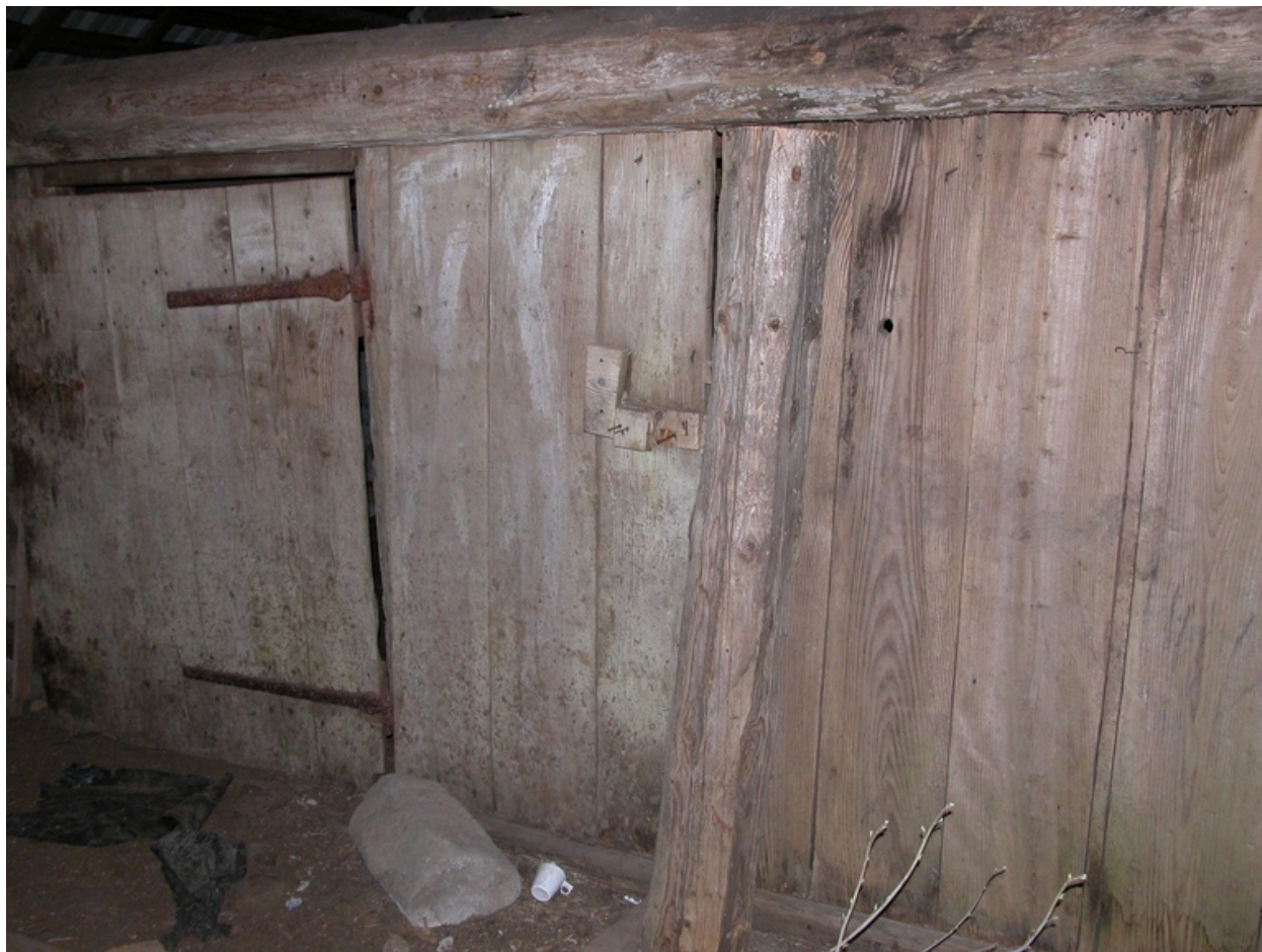
Vue intérieure : cloison séparant la logette de l'étable.
