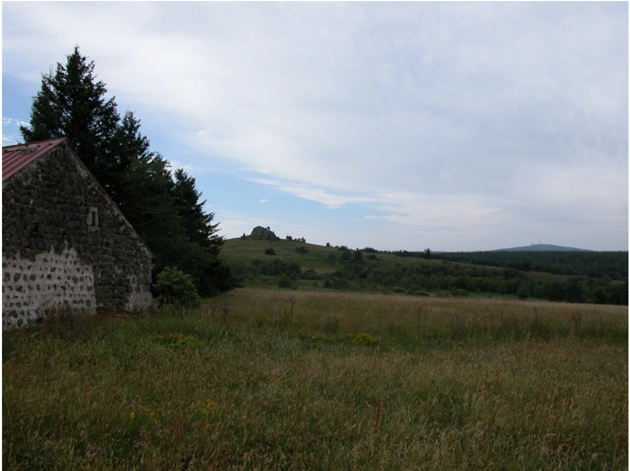
Vue du pignon nord avec la grande pierre Bazanne dans le fond.
