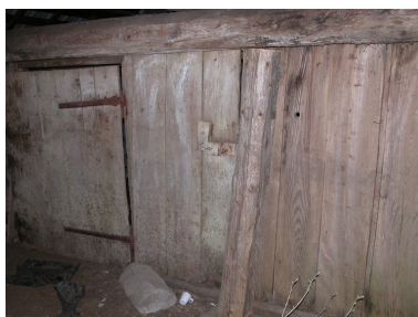
Vue intérieure : cloison séparant la logette de l'étable. Phot. Caroline Guibaud IVR82_20124201468NUCA
