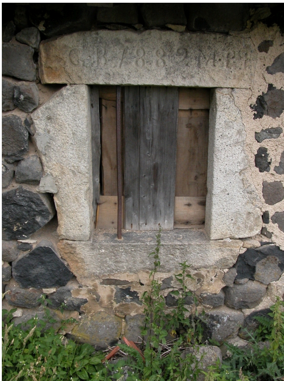
Détail de la fenêtre de la logette.
