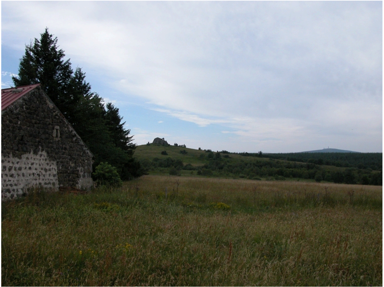
Vue du pignon nord avec la grande pierre Bazanne dans le fond.
