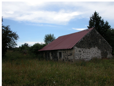
Vue d'ensemble depuis le nord-est. Phot. Caroline Guibaud IVR82_20124201469NUCA
