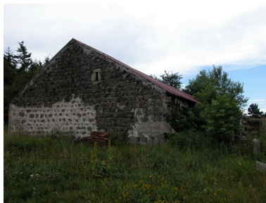
Vue du pignon nord. Phot. Caroline Guibaud IVR82_20124201471NUCA
