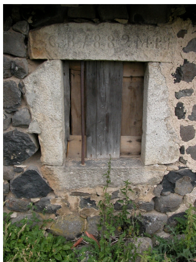
Détail de la fenêtre de la logette. Phot. Caroline Guibaud IVR82_20124201474NUCA
