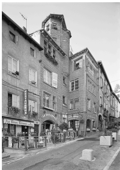
Vue d'ensemble Phot. Jean-Marie Refflé IVR82_19900100324P
