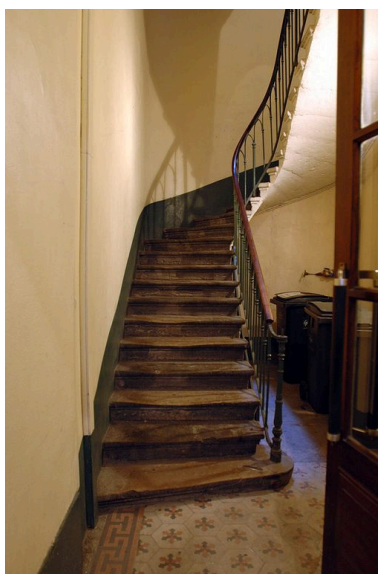
Départ d'escalier et revêtement de sol
