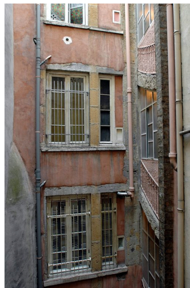
Élévations sur courette Phot. Véronique Belle IVR82_20086902961NUCA
