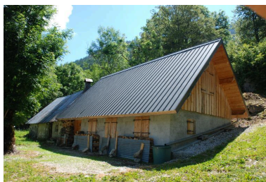
Vue d'ensemble depuis l'est (au premier plan, chalet mitoyen). Phot. Caroline Guibaud IVR84_20177301217NUCA
