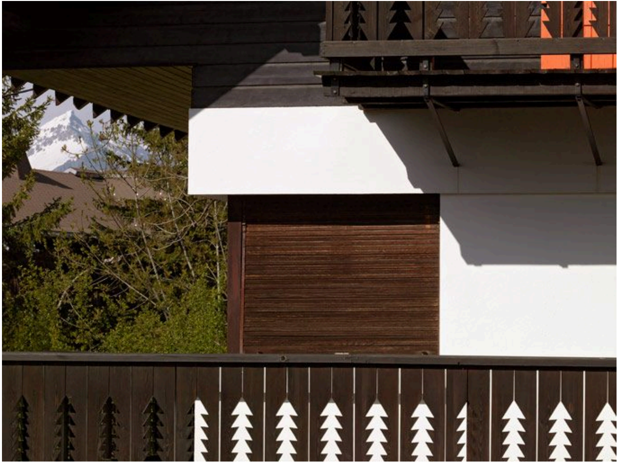
Chalet la Chaumette, 31 route du Téléphérique. 1er étage. Détail de la fenêtre d'angle
