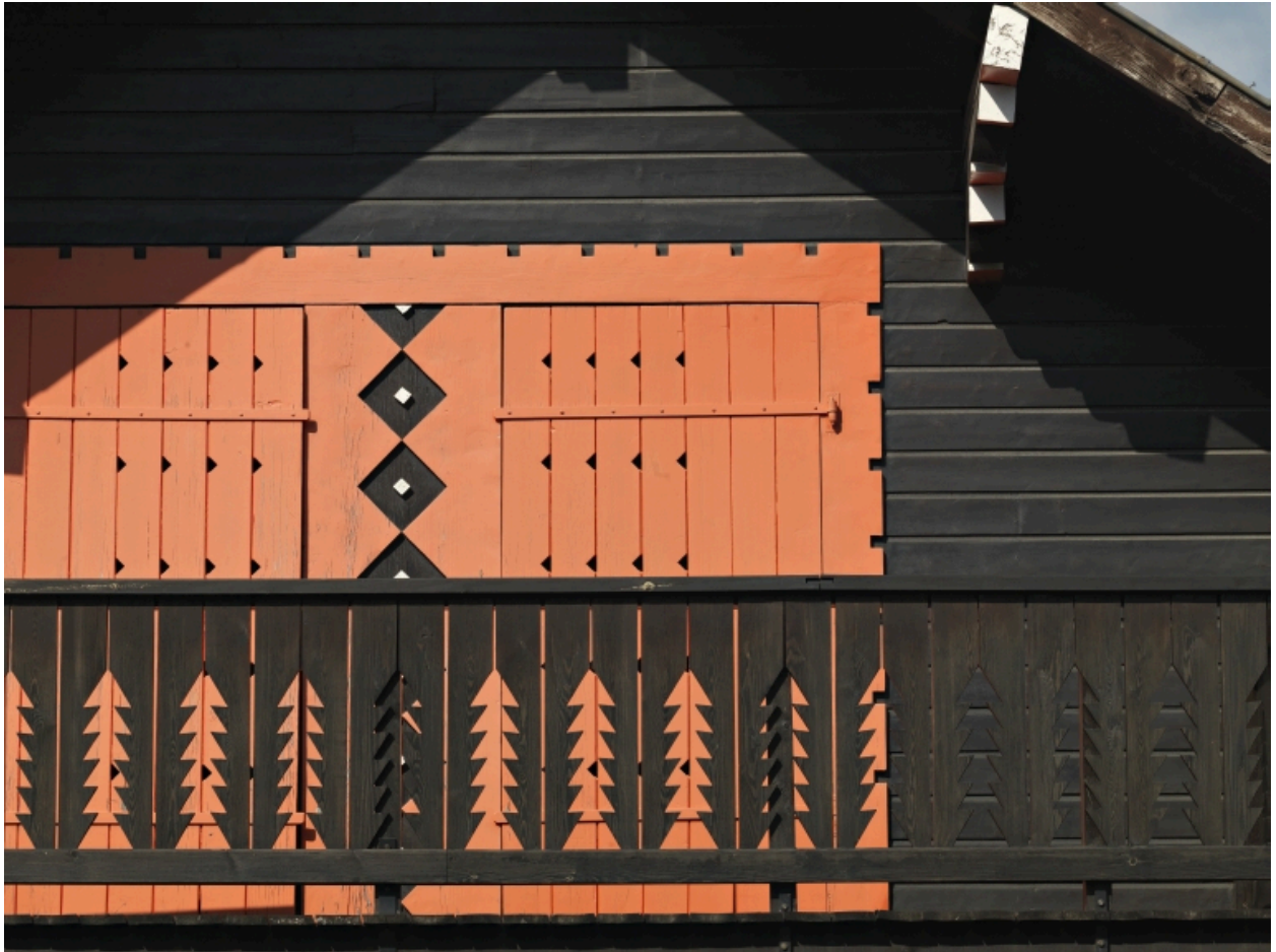
Chalet la Chaumette, 31 route du Téléphérique. Etage de comble. Détail des volets
