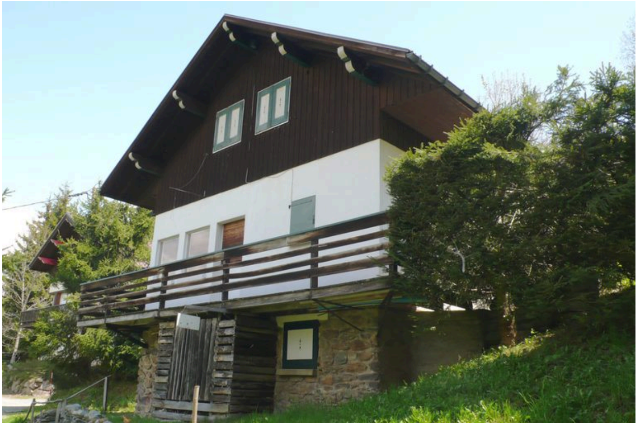
Chalet les Neiges, 265 impasse de la Madone. Elévation antérieure
