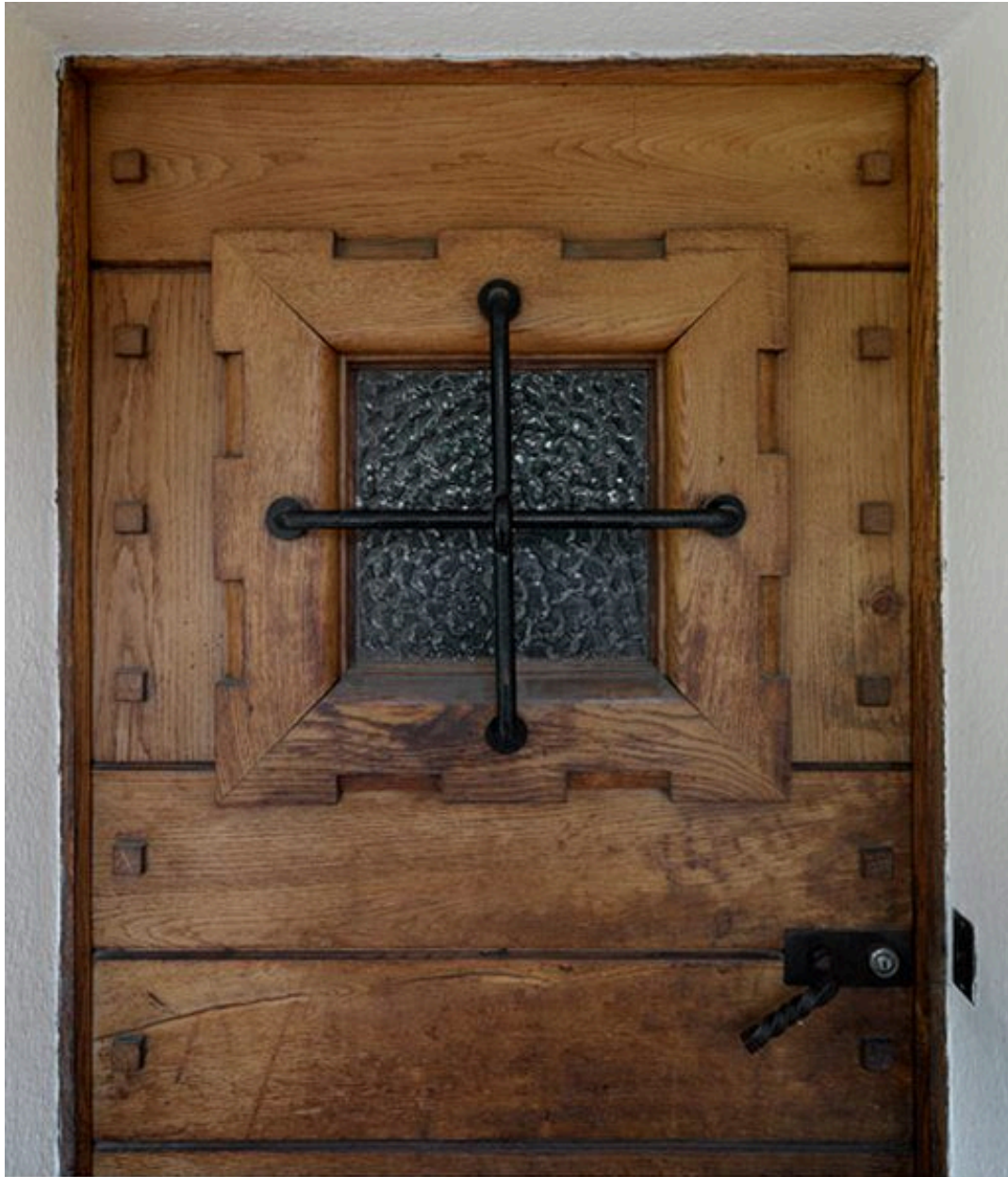
Chalet les Sorbiers, 373 route du Bouchet, construit en 1950. Détail de l'huissierie de la porte d'entrée
