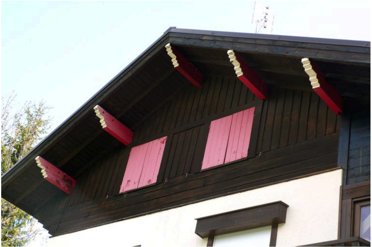
Chalet les Brimbelles, 241 impasse de la Madone. Détail de l'avant-toit
