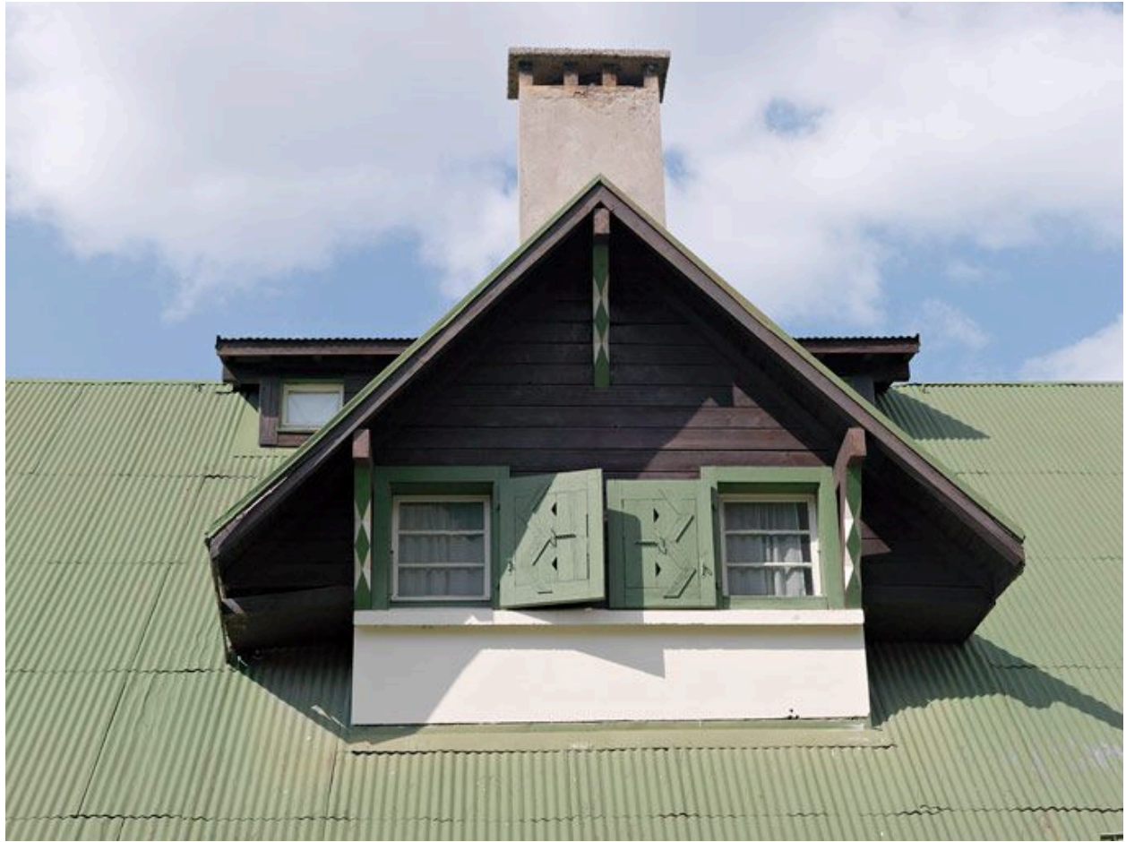
Chalet Reine des neiges, 456 route de Rochebrune, construit en 1937. Lucarne de toit
