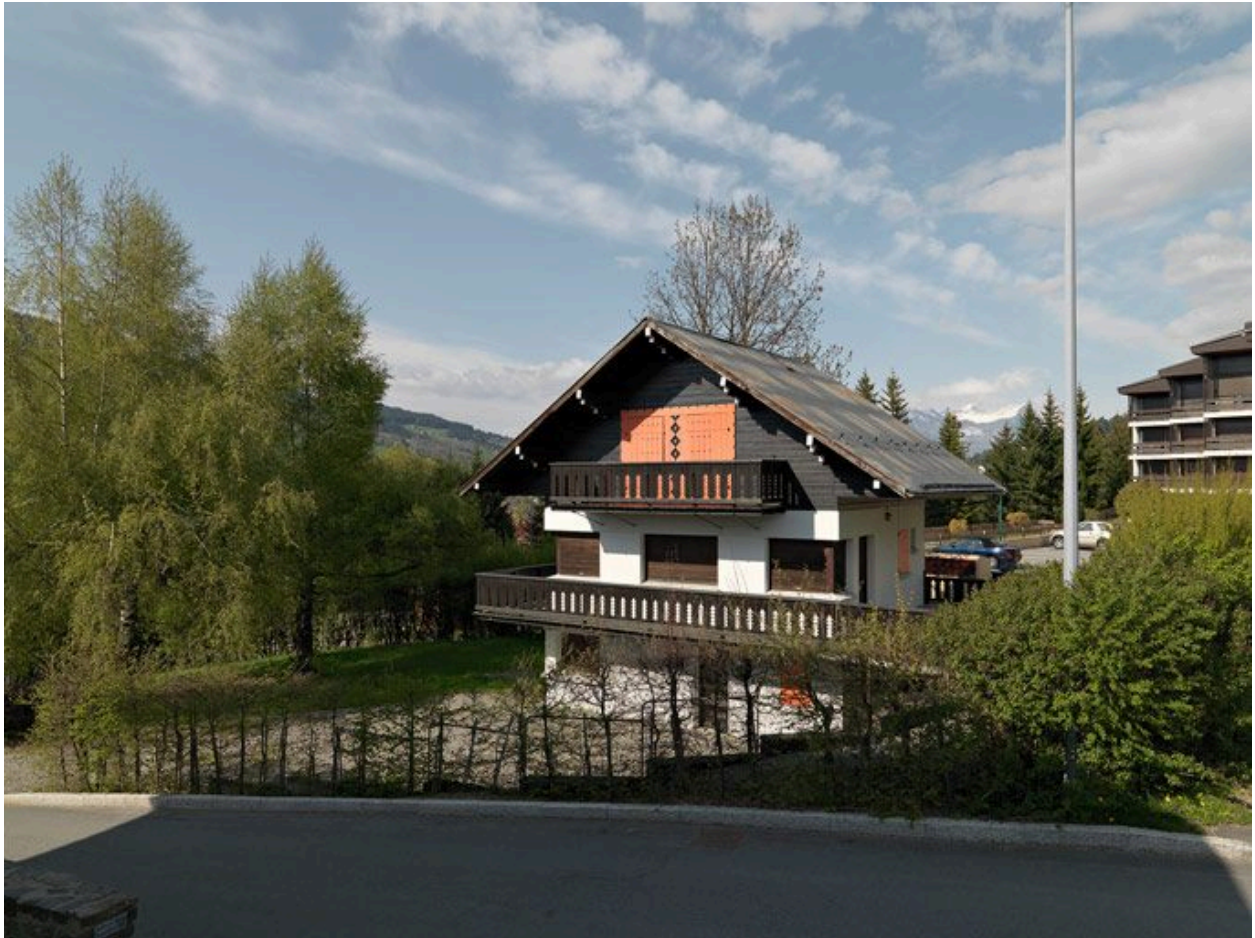
Chalet la Chaumette, 31 route du Téléphérique. Vue d'ensemble depuis le sud-est
