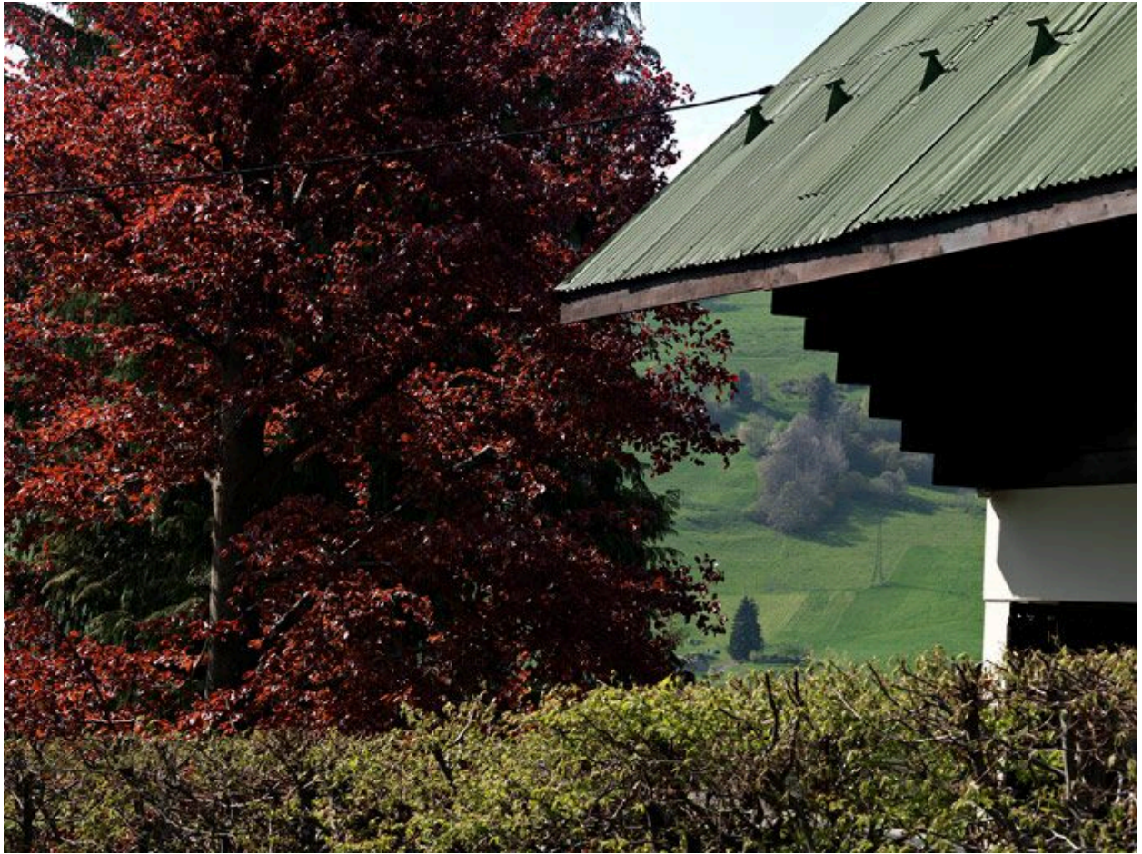
Chalet Reine des neiges, 456 route de Rochebrune, construit en 1937. Détail d'avant-toit
