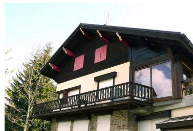
Chalet les Brimbelles, 241 impasse de la Madone Phot. Jean-François Lyon-Caen IVR82_20127401664NUCA
