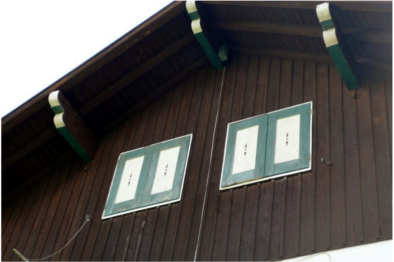
Chalet les Neiges, 265 impasse de la Madone. Détail de l'avant-toit et des baies du comble
