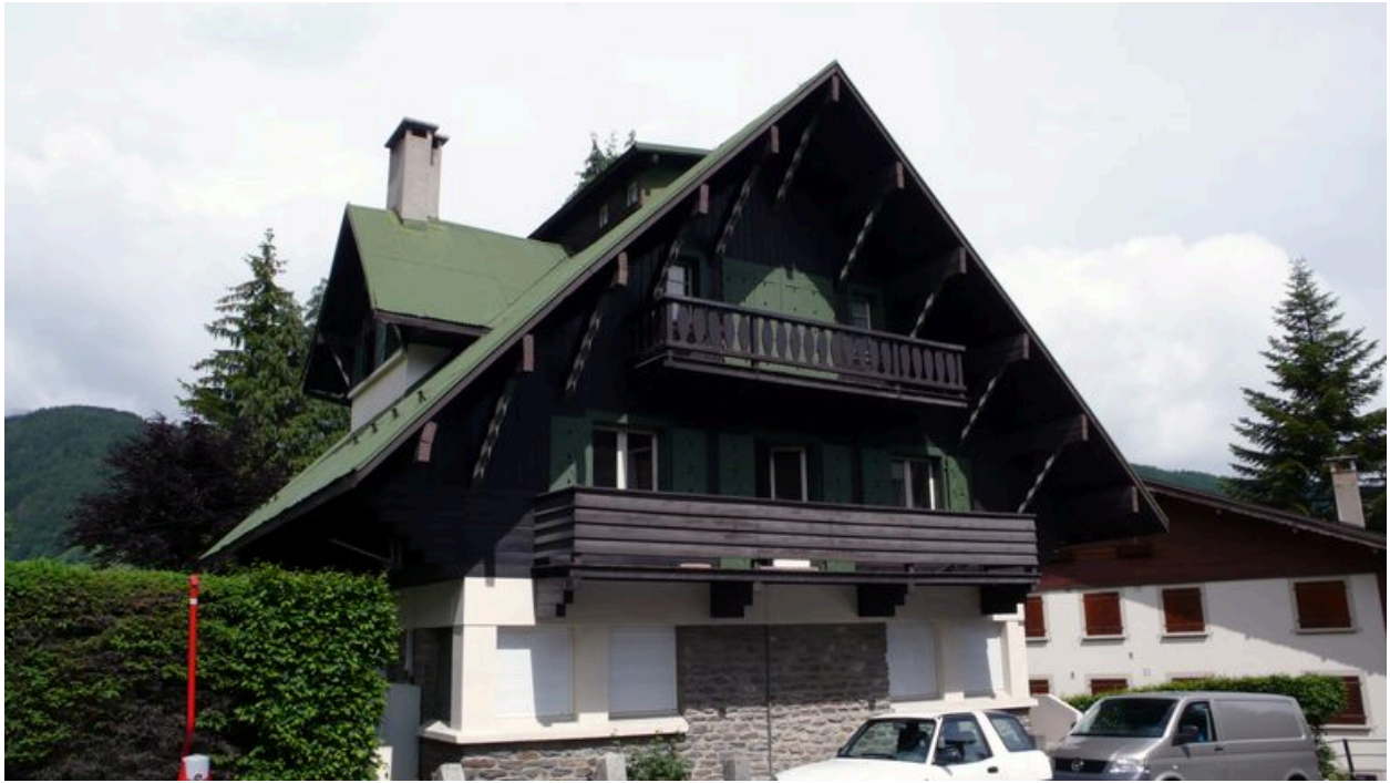
Chalet Reine des neiges, 456 route de Rochebrune, construit en 1937
