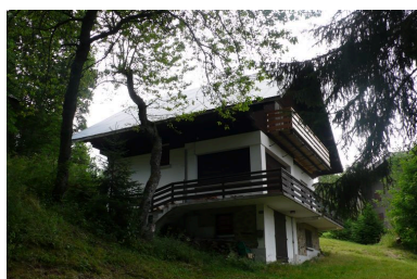
Chalet les Jonquilles, 2315 route Edmond de Rothschild, construit en 1936 pour E. Hazemann. Vue depuis le nord-ouest Phot. Jean-François Lyon-Caen IVR82_20127401743NUCA
