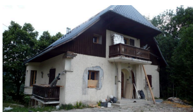
Chalet Saint-Bernard, 193 impasse de la Combe. Façade antérieure Phot. Jean-François Lyon-Caen IVR82_20127401789NUCA
