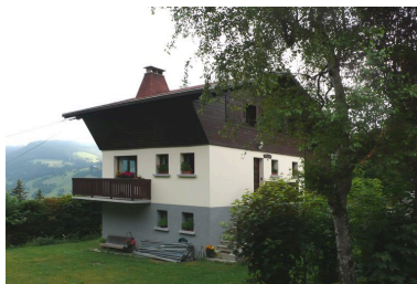
Chalet le Blizzard, 86 route des Pettoreaux Phot. Jean-François Lyon-Caen IVR82_20127401663NUCA
