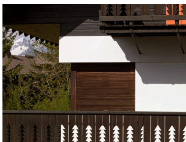
Chalet la Chaumette, 31 route du Téléphérique. 1er étage. Détail de la fenêtre d'angle Phot. Eric Dessert IVR82_20107401380NUCA
