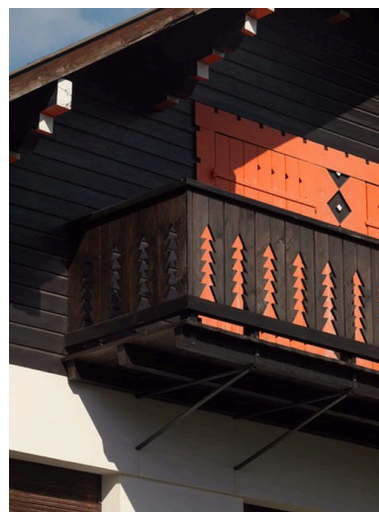
Chalet la Chaumette, 31 route du Téléphérique. Etage de comble. Détail du balcon Phot. Eric Dessert IVR82_20107401381NUCA
