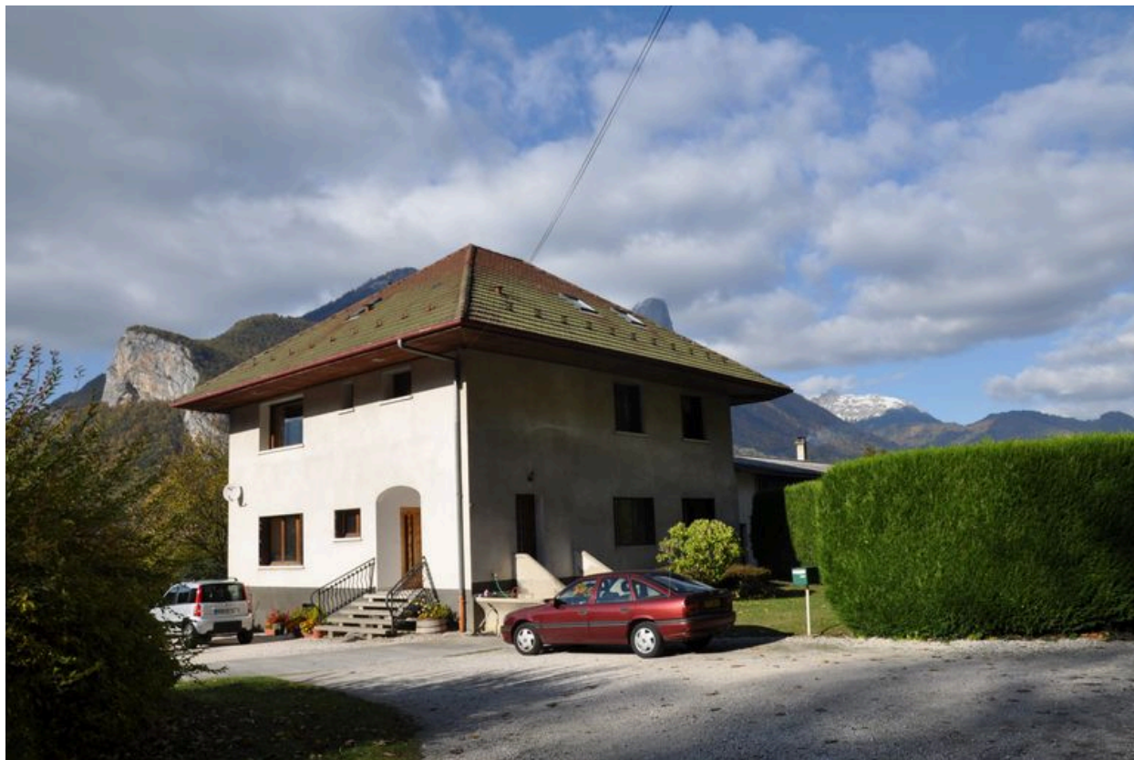
Vue de la maison adossée à la scierie Demaison prise depuis la rue du Coq
