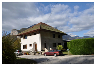
Vue de la maison adossée à la scierie Demaison prise depuis la rue du Coq Phot. Samir Mahfoudi, Autr. Samir Mahfoudi IVR82_20117401050NUCA
