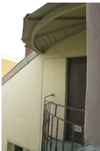
Détail de l'avant-toit au-dessus des balcons Phot. Maryannick Chalabi IVR82_20016900127NUCA
