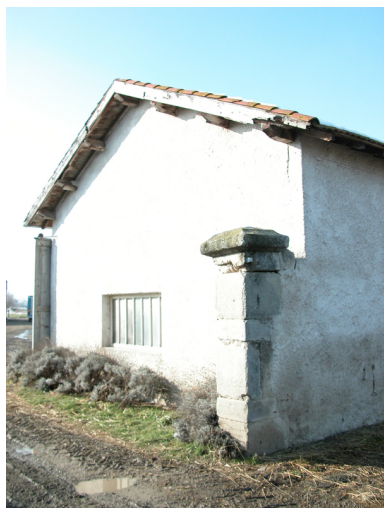
Détail du pilier subsistant du portail est. Phot. Thierry Monnet IVR82_20114200790NUCA
