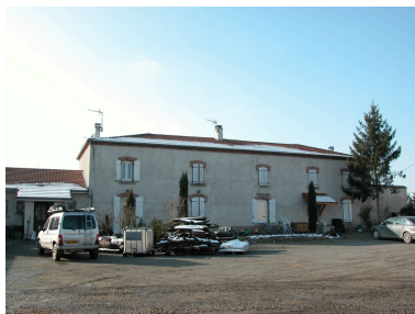
Vue d'ensemble du logis. Phot. Thierry Monnet IVR82_20114200562NUCA
