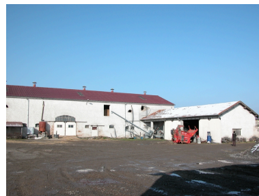
Vue d'ensemble de la grange-étable et des remises en retour. Phot. Thierry Monnet IVR82_20114200563NUCA
