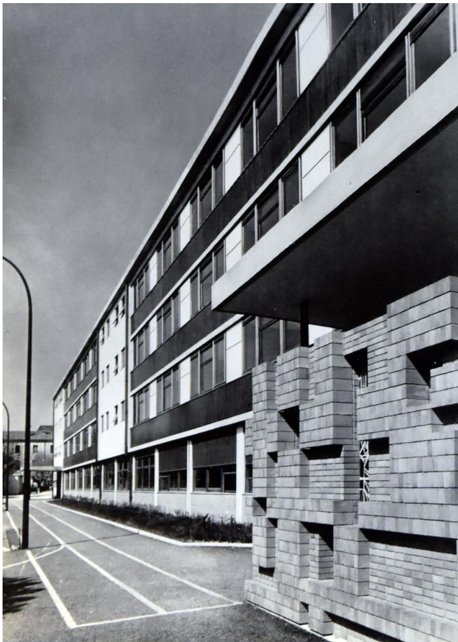
Elévation sur cour depuis le sud, v. 1961 (Phot. Littoz-Baritel In Noviant, Internat du lycée de garçons, 1963)
