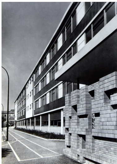
Elévation sur cour depuis le sud, v. 1961 (Phot. Littoz-Baritel In Noviant, Internat du lycée de garçons, 1963) Repro. Catherine Guégan IVR84_20240100300NUCA
