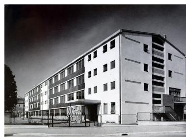
Vue d'ensemble depuis le sud (Phot. Littoz-Baritel In Noviant, Internat du lycée de garçons, 1963) Repro. Catherine Guégan IVR84_20240100301NUCA
