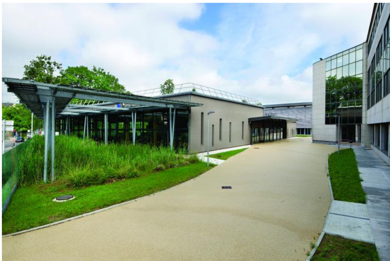
Bâtiments vus depuis l'entrée de service ; à droite l'internat après restructuration et modification de la façade
