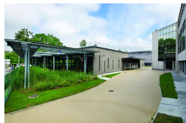
Bâtiments vus depuis l'entrée de service ; à droite l'internat après restructuration et modification de la façade Phot. Franck Trabouillet IVR84_20200100732NUCAQ
