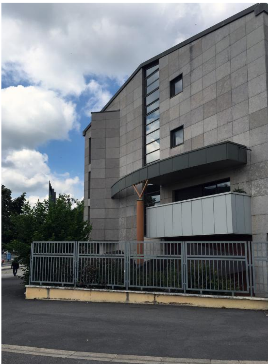
Mur pignon sud après travaux de restructuration, 2020
