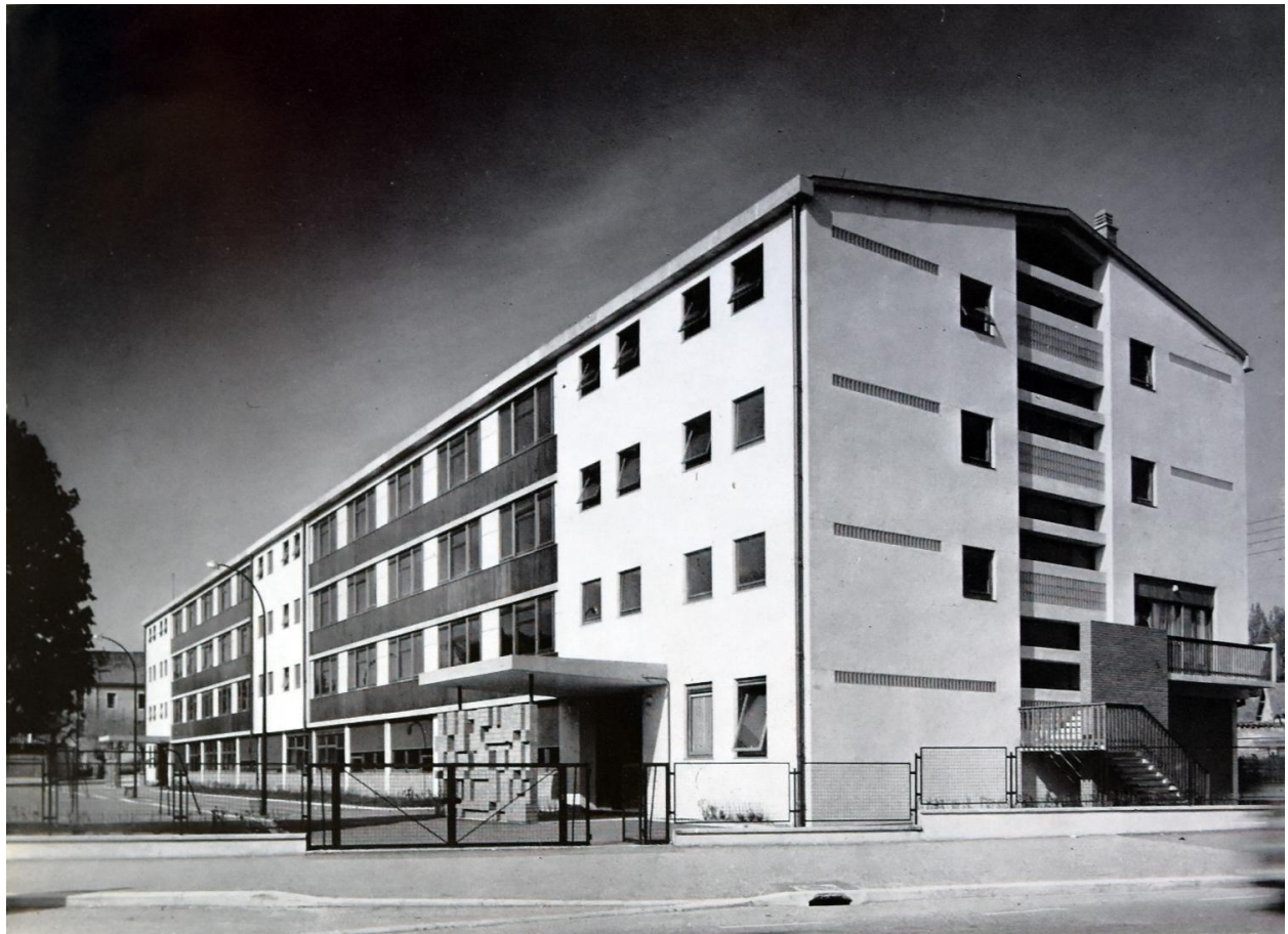
Vue d'ensemble depuis le sud (Phot. Littoz-Baritel In Noviant, Internat du lycée de garçons, 1963)
