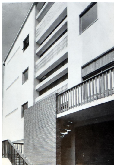
Pignon sud v. 1961 (Phot. Littoz- Baritel In Noviant, Internat du lycée de garçons, 1963) Repro. Catherine Guégan, Autr. Littoz-Baritel IVR84_20240100304NUCA
