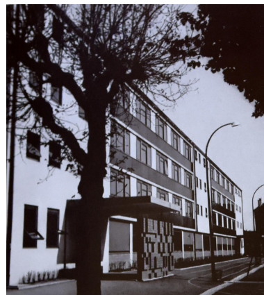
Elévation sur cour depuis le nord, v. 1961 (Phot. Littoz-Baritel In Noviant, Internat du lycée de garçons, 1963) Repro. Catherine Guégan, Autr. Littoz-Baritel IVR84_20240100309NUCA
