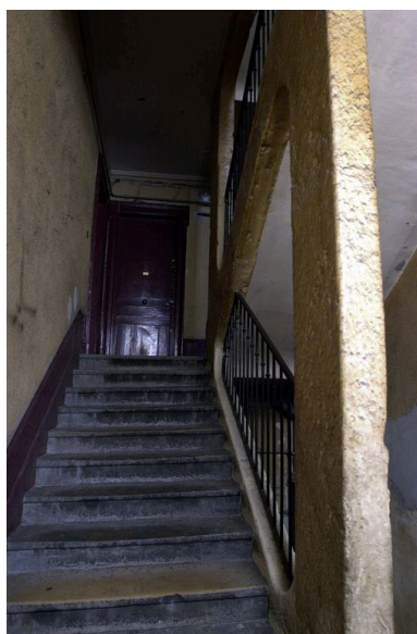
Escalier, 2e volée prise depuis le premier repos Phot. Bernard Ducouret IVR82_20036902040NUCA
