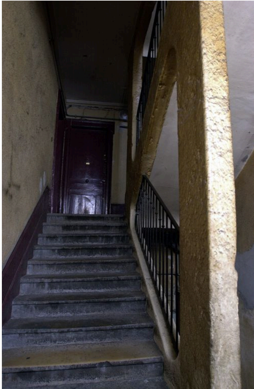
Escalier, 2e volée prise depuis le premier repos
