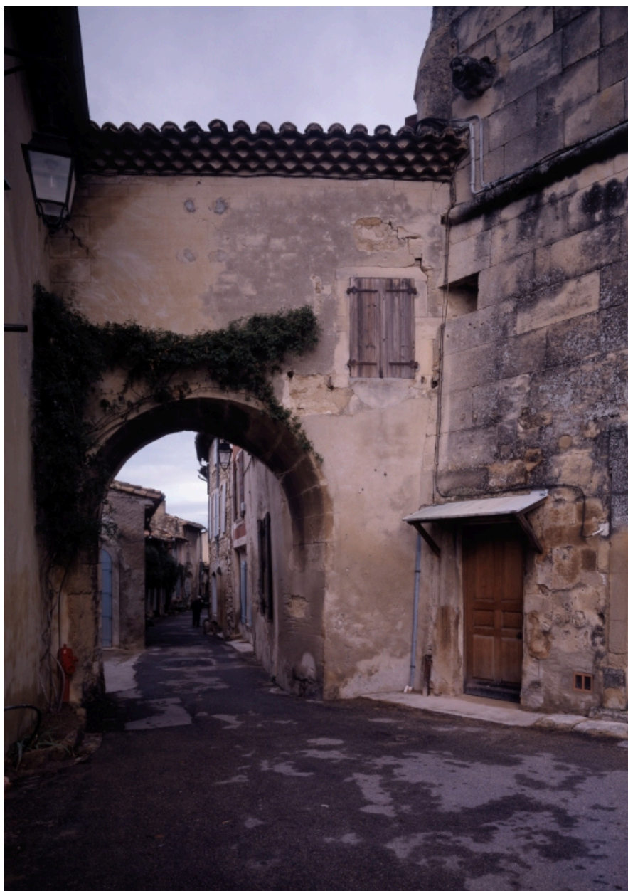
Rue Saint-Sauveur, soustet adossé au mur de la collégiale : ancienne porte du quartier canonial.
