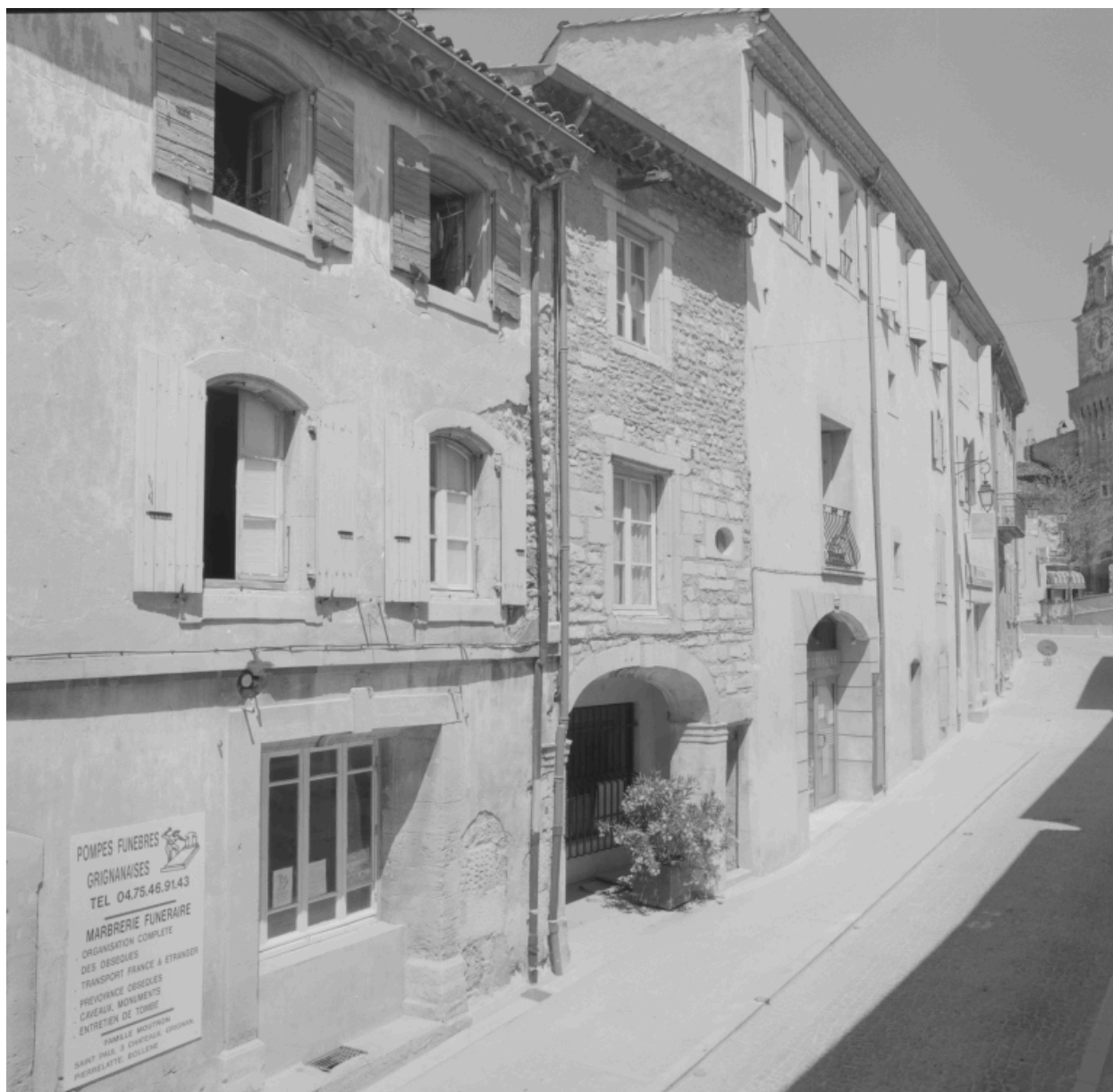
Rue du Grand Faubourg. Vue des façades donnant sur la rue.
