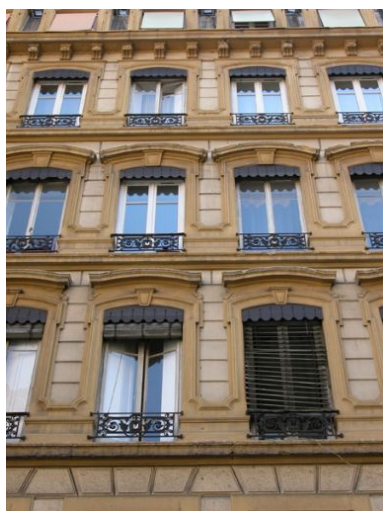
Façade principale rue Mercière, détail des niveaux 3 à 5 Phot. Bernard Ducouret IVR82_20046905746NUCA
