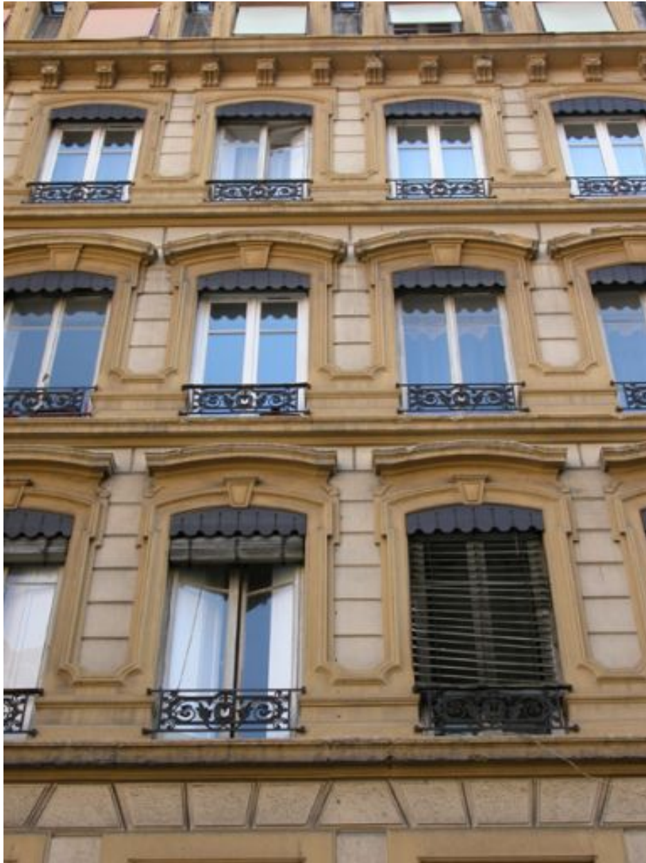
Façade principale rue Mercière, détail des niveaux 3 à 5
