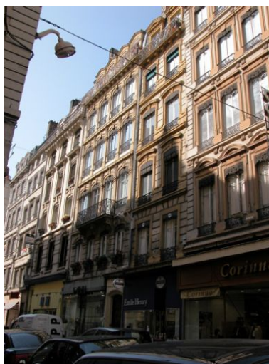
Façade rue de Brest, vue générale Phot. Bernard Ducouret IVR82_20046905724NUCA
