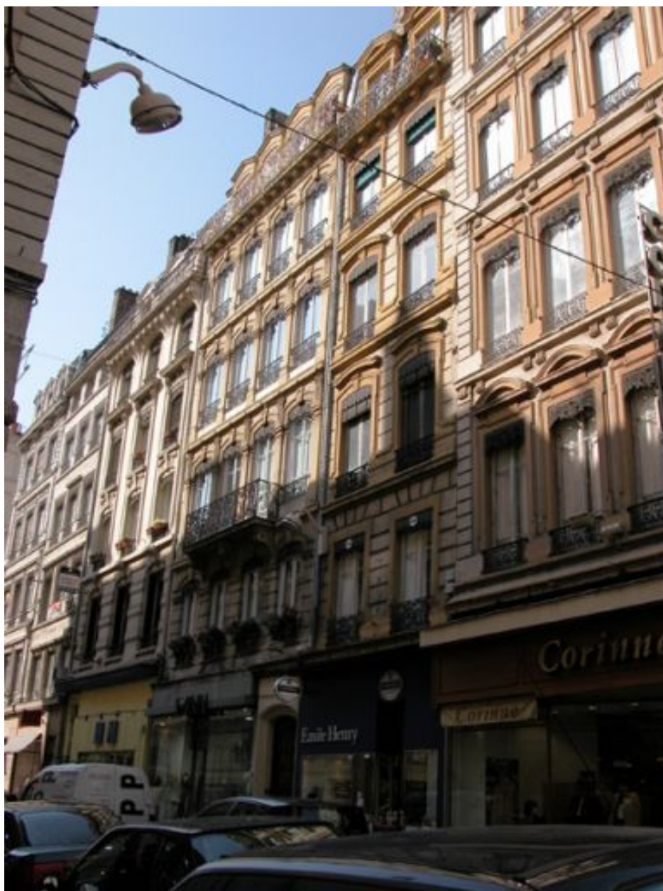
Façade rue de Brest, vue générale
