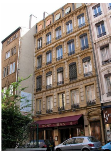
Façade principale rue Mercière, vue générale Phot. Bernard Ducouret IVR82_20046905744NUCA
