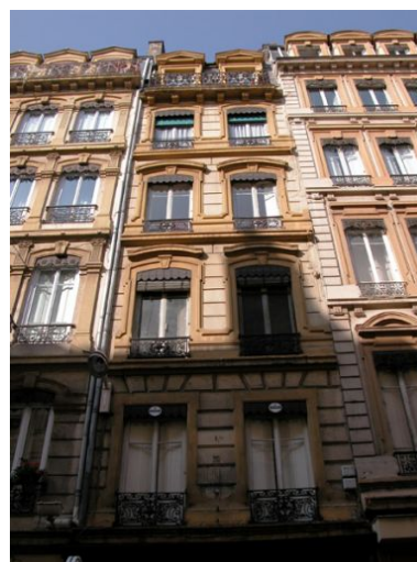
Façade rue de Brest, vue par-dessous Phot. Bernard Ducouret IVR82_20046905747NUCA
