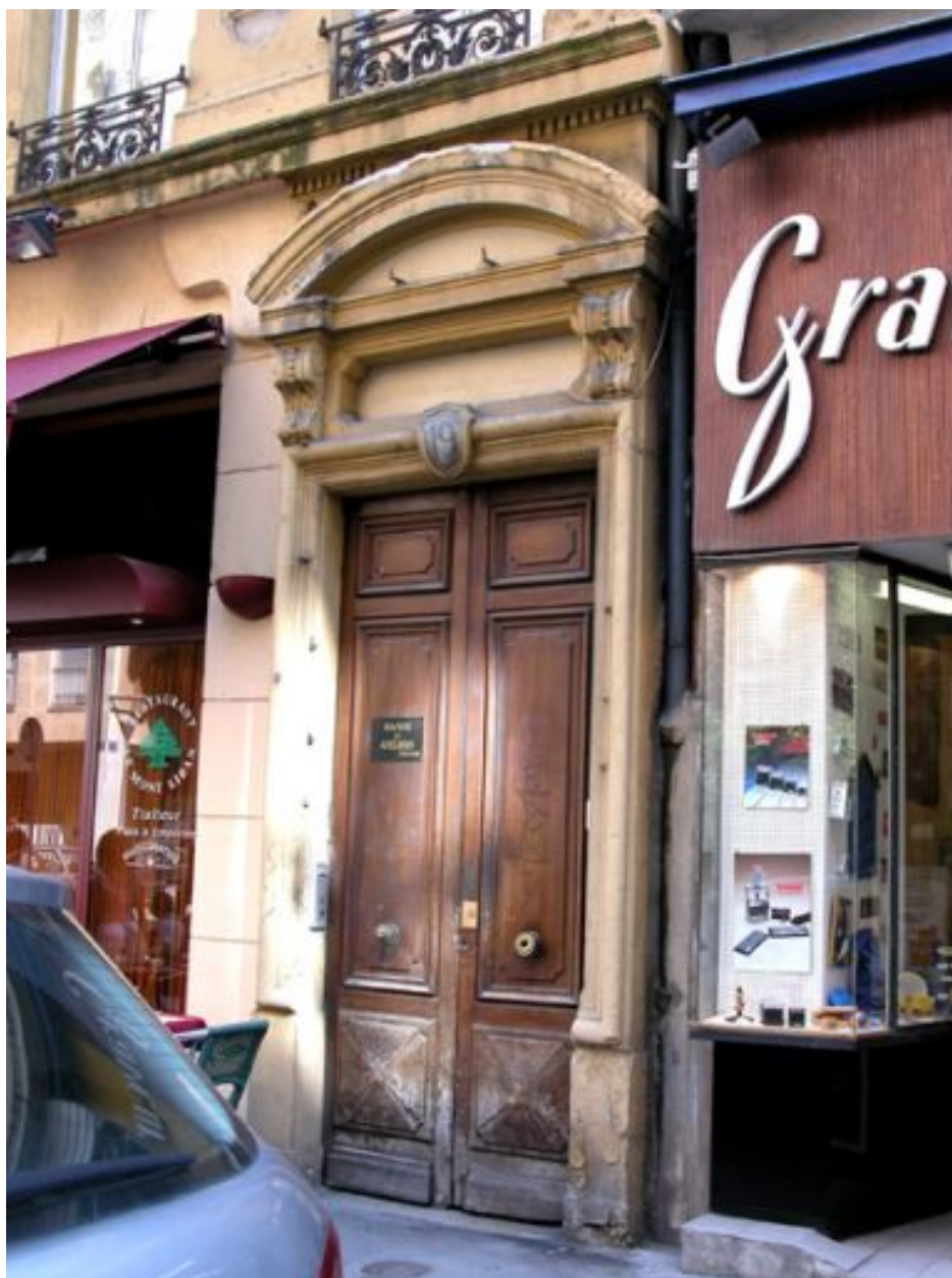
Façade principale rue Mercière, porte
