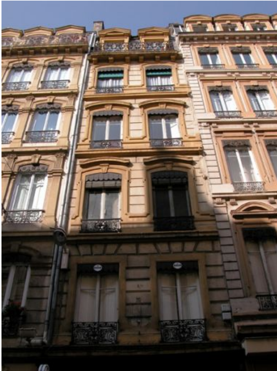
Façade rue de Brest, vue par-dessous
