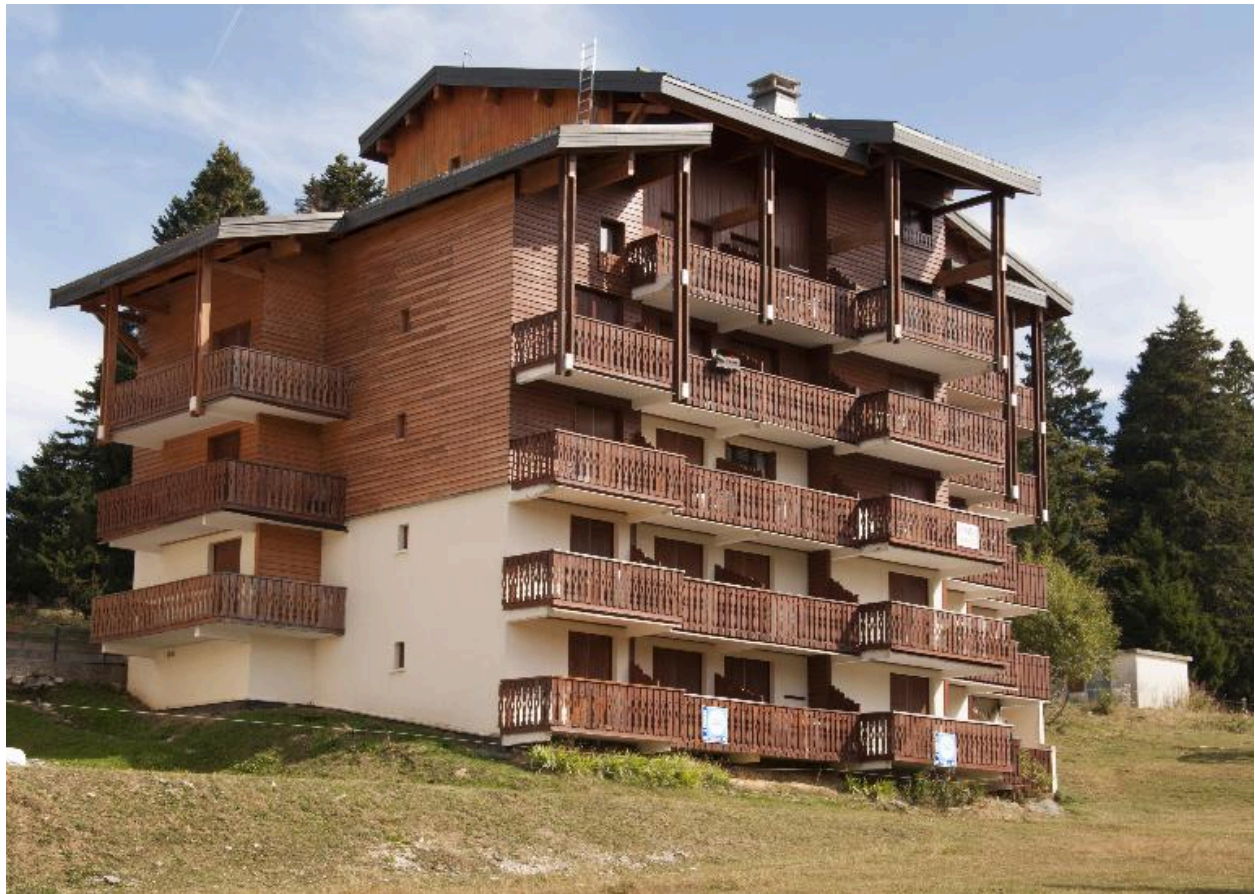
Immeuble Le Mont-Blanc : façades sud et ouest
