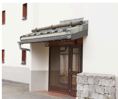
Immeuble Les Belledonnes : entrée et tronc d'arbre servant d'arrêt de neige Phot. Denys Harreau IVR84_20167305926NUCA
