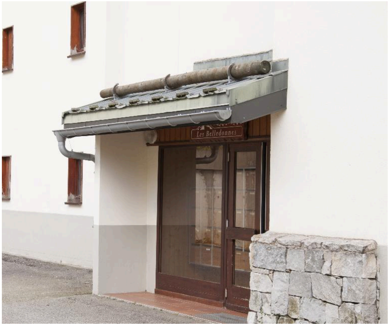
Immeuble Les Belledonnes : entrée et tronc d'arbre servant d'arrêt de neige
