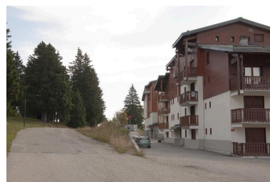
Façades postérieures Phot. Denys Harreau IVR84_20167305925NUCA
