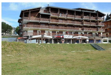
Immeuble Les Belledonnes : façade sud Phot. Denys Harreau IVR84_20167305924NUCA
