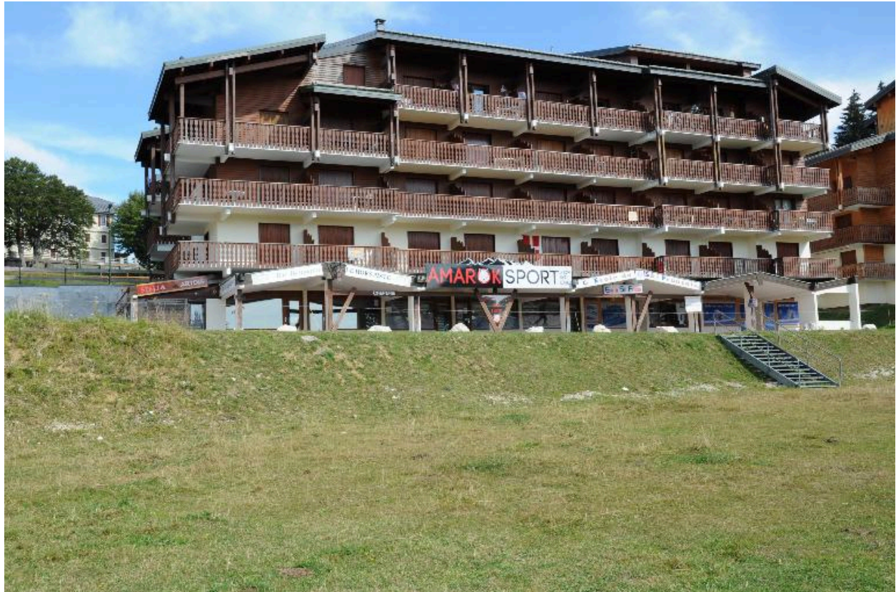
Immeuble Les Belledonnes : façade sud
