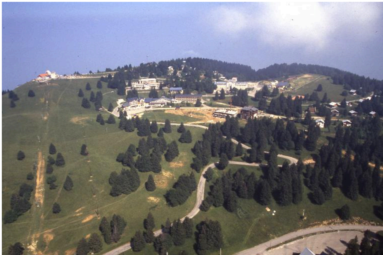
Les Belledonnes en construction, vers 1987
