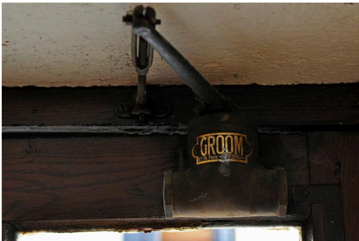
Vue intérieure, détail du groom de la porte de cour
