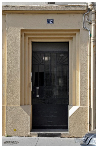
Vue rapprochée de la porte Phot. Magali Delavenne IVR84_20176901507NUCA
