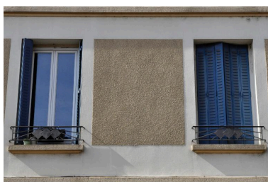
Vue rapprochée des fenêtres du premier étage : garde-corps en ferronnerie, décor dans l'enduite, volets métalliques Phot. Magali Delavenne IVR84_20176901508NUCA
