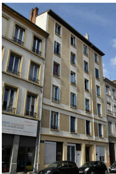
Vue générale, élévation sur rue Phot. Magali Delavenne IVR84_20176901505NUCA
