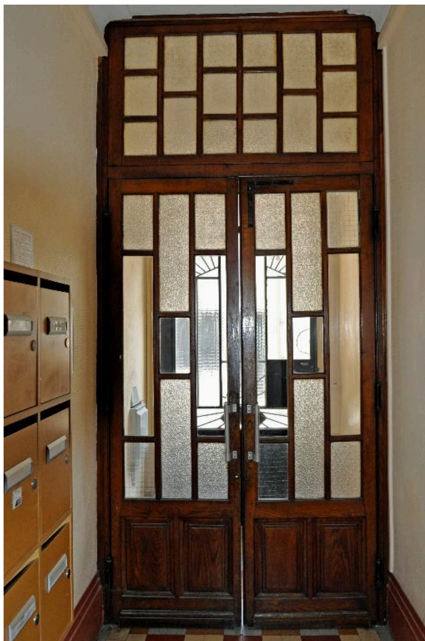
Vue intérieure, la porte du vestibule-sas
