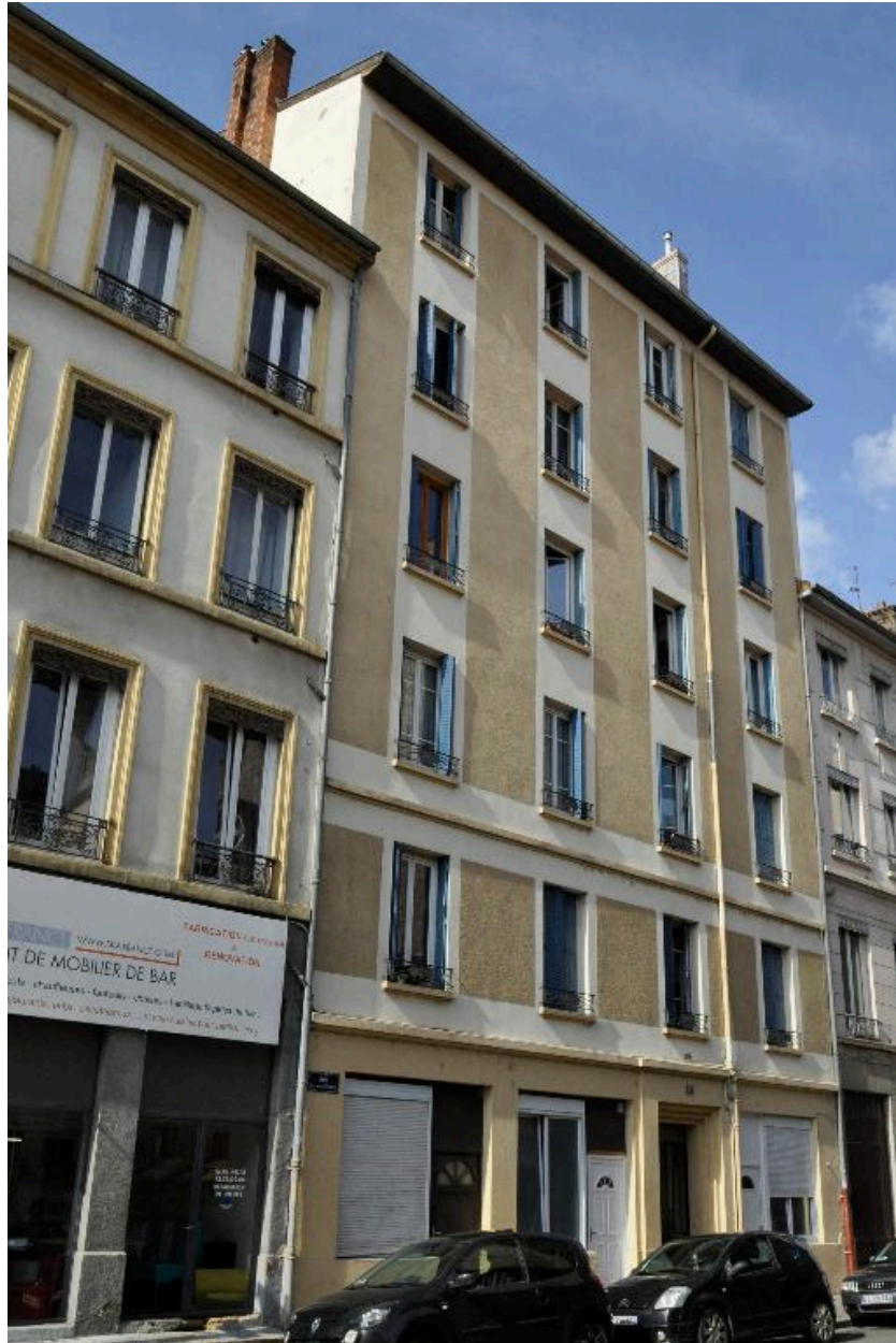
Vue générale, élévation sur rue
