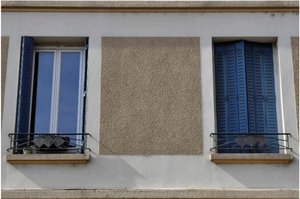
Vue rapprochée des fenêtres du premier étage : garde-corps en ferronnerie, décor dans l'enduite, volets métalliques
