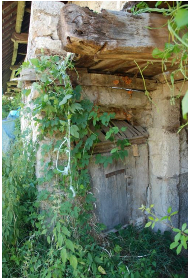
Réduit (poulailler ?) sous l'escalier. Phot. Thierry Monnet IVR84_20207400569NUCA
