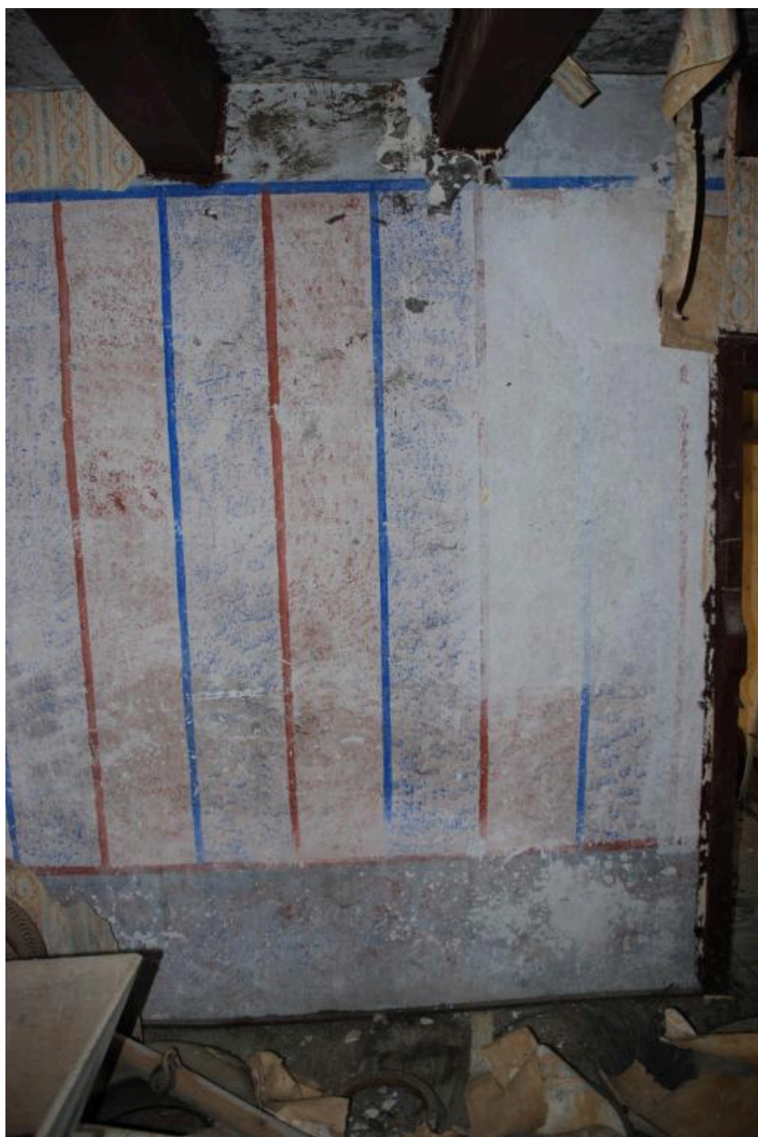
Vue intérieure de la chambre sud : décor mural peint.
