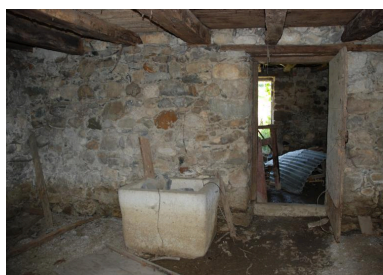
Vue intérieure de la cave nord-est (saloir). Phot. Thierry Monnet IVR84_20207400564NUCA
