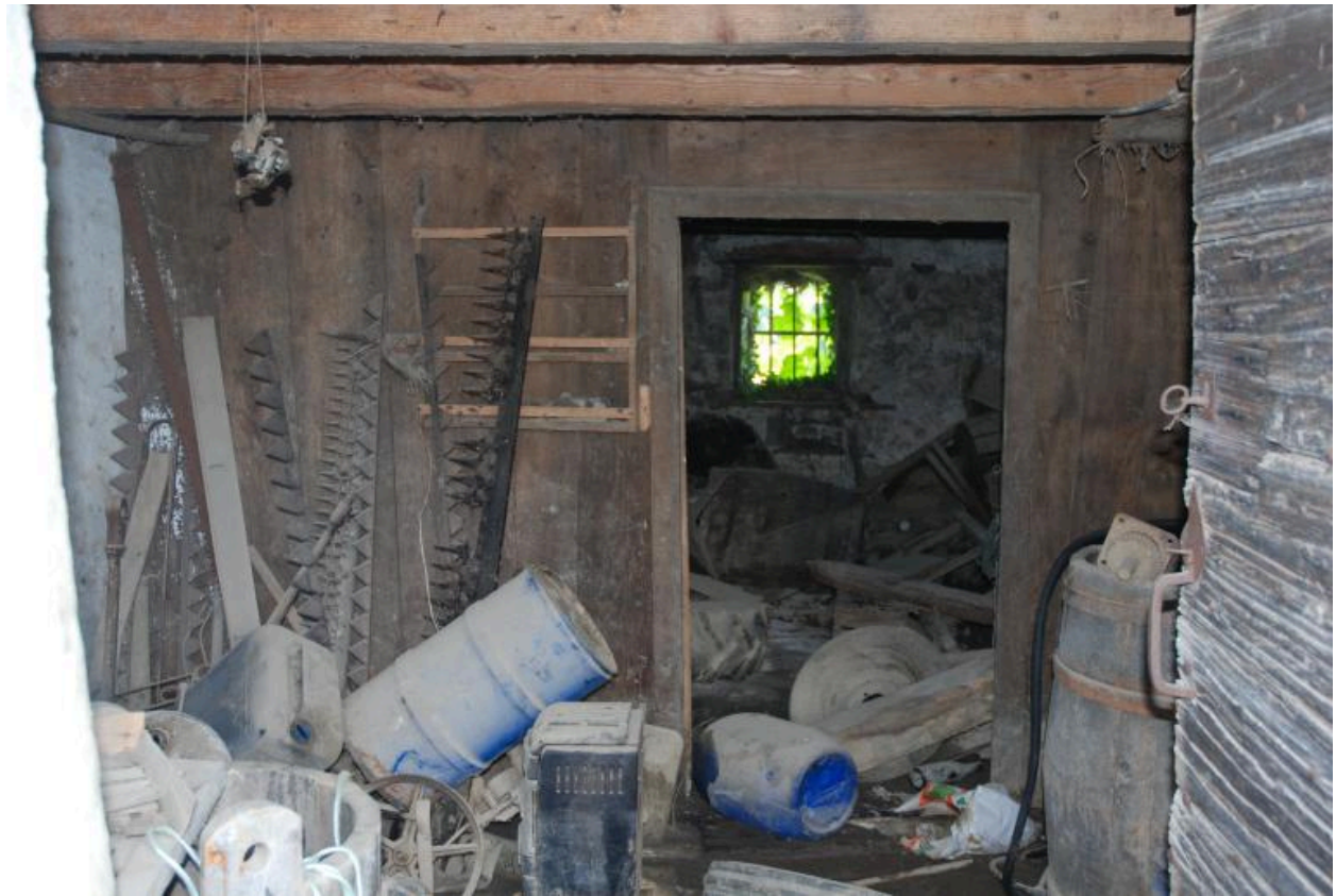
Vue intérieure de la cave sud-ouest.
