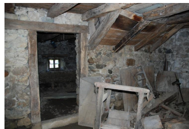
Vue intérieure du cuvage, porte de communication vers la cave nord-est. Phot. Thierry Monnet IVR84_20207400563NUCA
