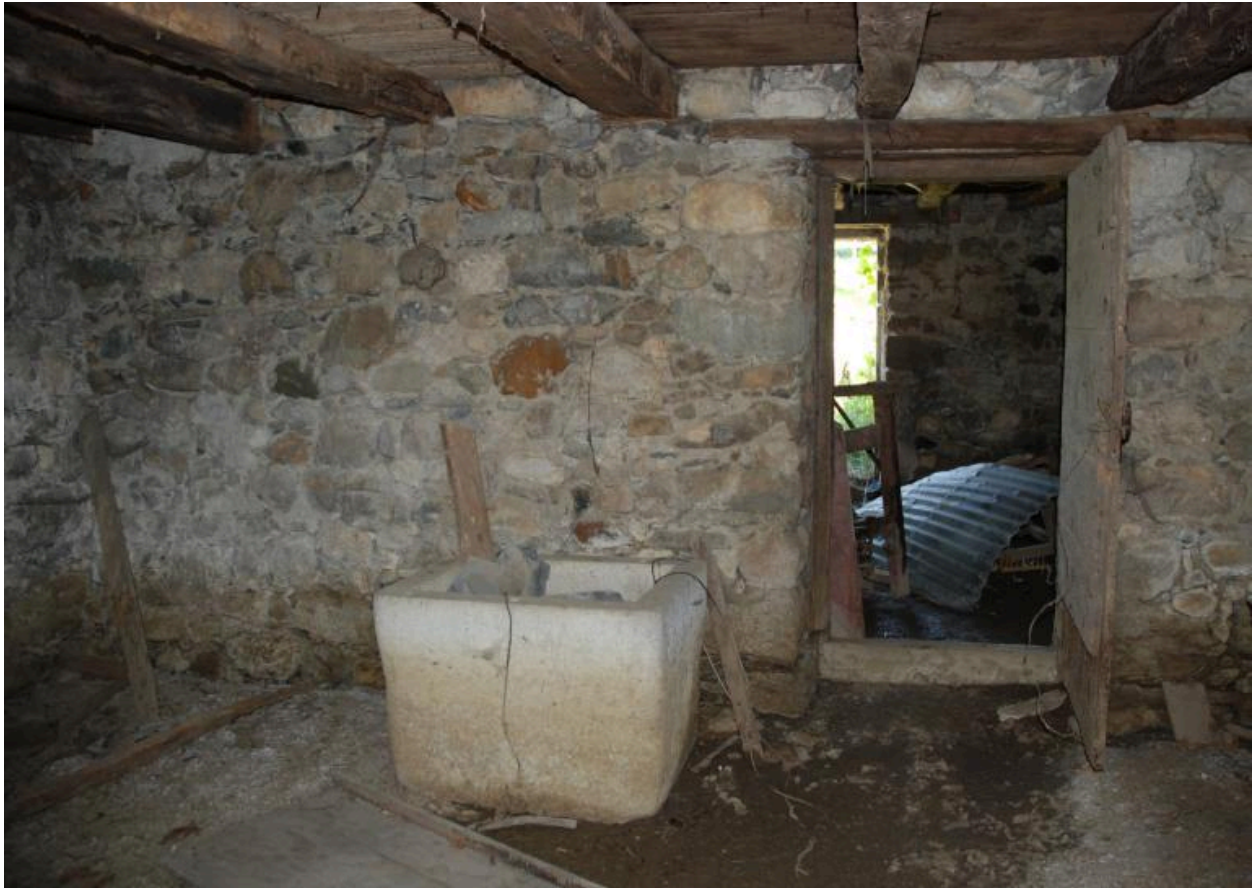
Vue intérieure de la cave nord-est (saloir).
