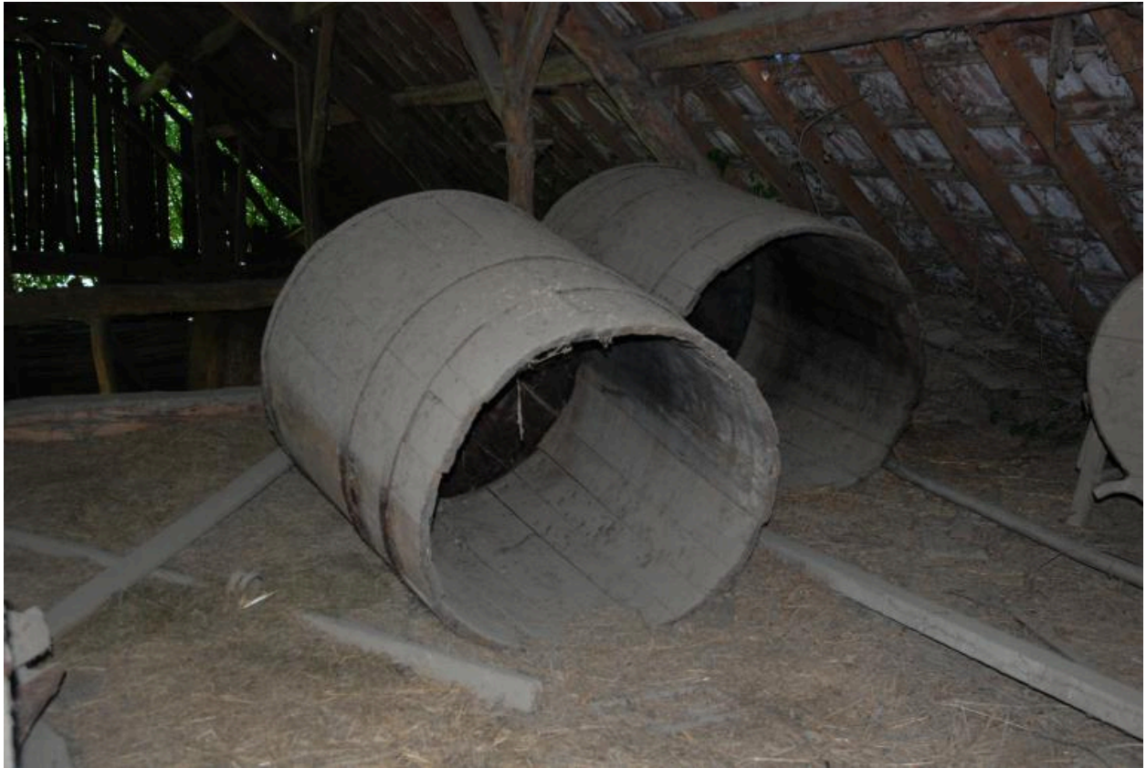
Vue intérieure du comble : cuves à grain.
