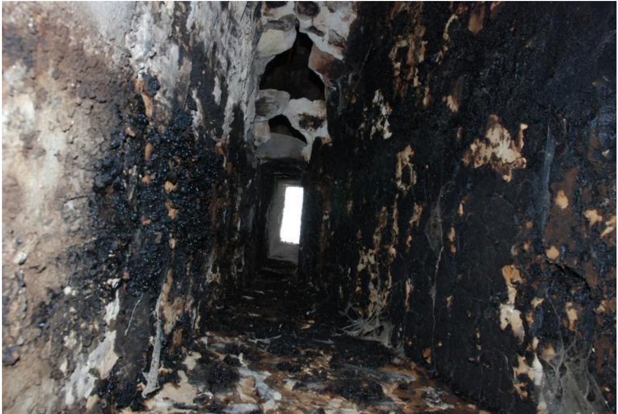
Vue intérieure du conduit de cheminée.
