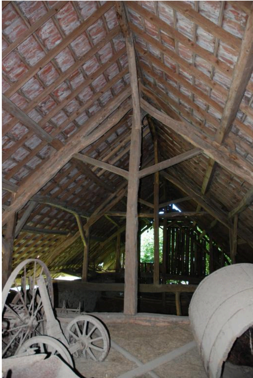
Vue intérieure du comble, depuis l'est.
