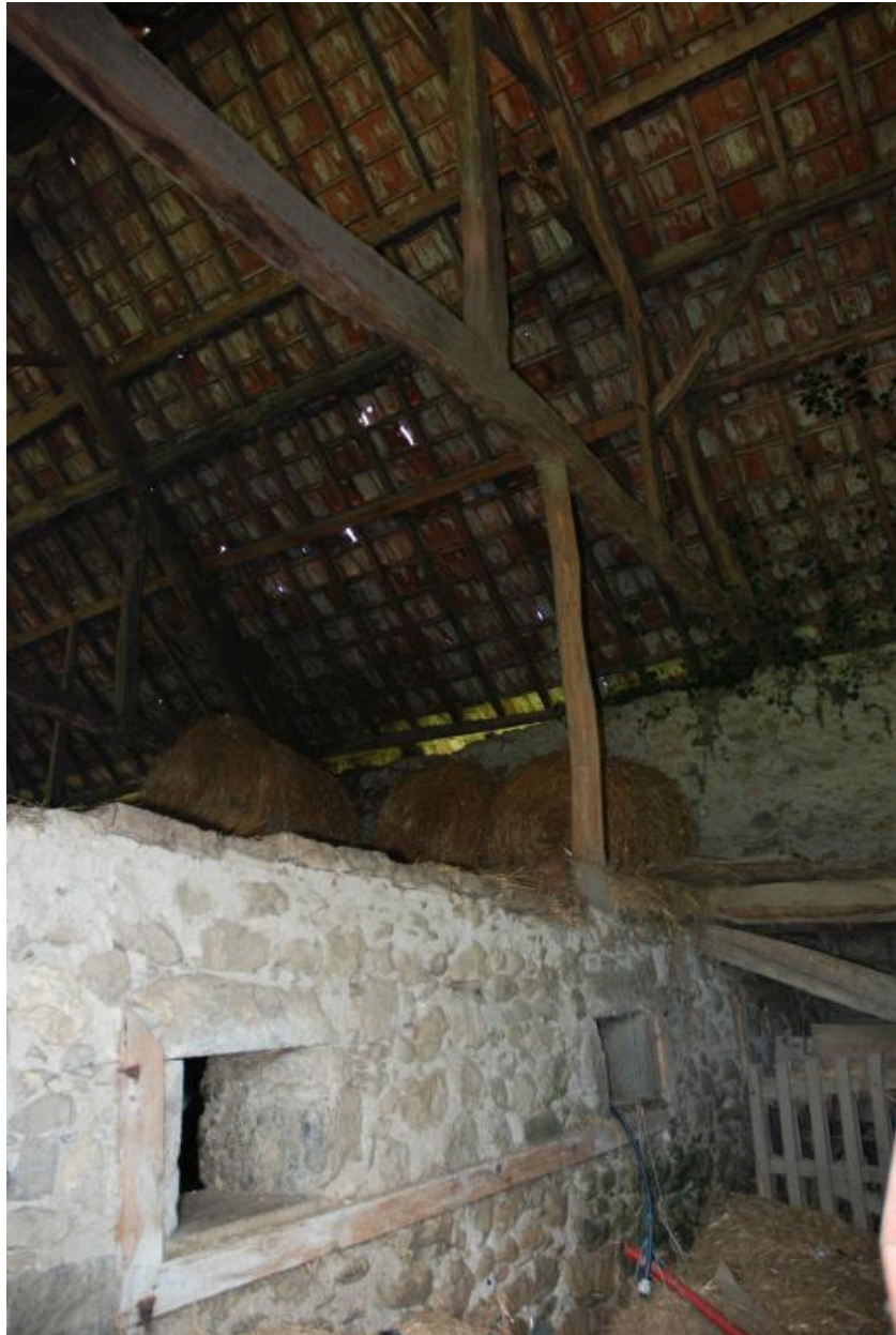
Vue intérieure de la grange, mur de séparation avec l'étable.
