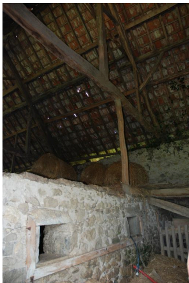
Vue intérieure de la grange, mur de séparation avec l'étable. Phot. Thierry Monnet IVR84_20207400556NUCA
