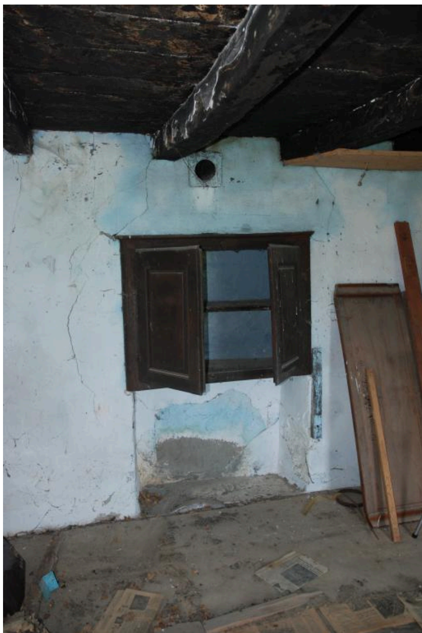
Vue intérieure du pêle : placard au revers de la cheminée.
