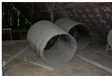
Vue intérieure du comble : cuves à grain. Phot. Thierry Monnet IVR84_20207400572NUCA
