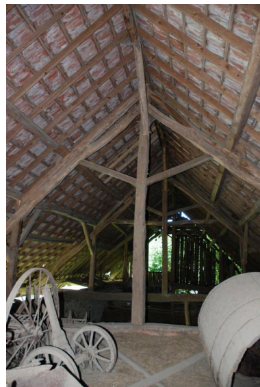
Vue intérieure du comble, depuis l'est. Phot. Thierry Monnet IVR84_20207400573NUCA
