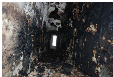
Vue intérieure du conduit de cheminée. Phot. Thierry Monnet IVR84_20207400576NUCA
