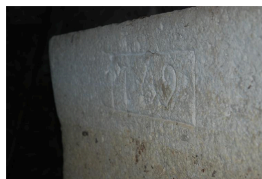
Vue intérieure de la cave nord-est, détail du saloir (date portée). Phot. Thierry Monnet IVR84_20207400579NUCA
