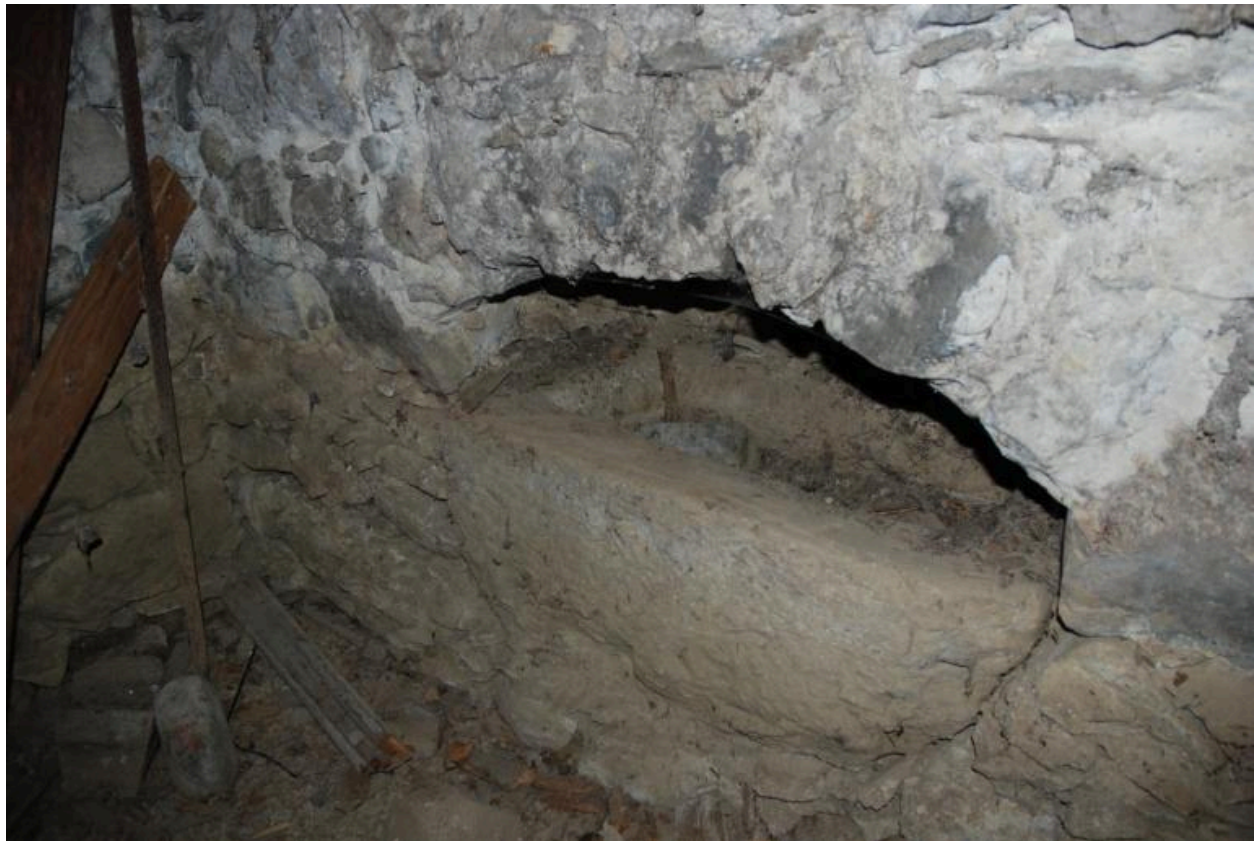
Vue intérieure de la cave nord-est : niche et cuve.
