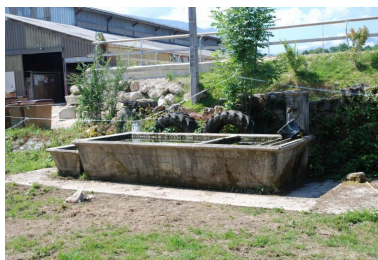
Vue du bassin. Phot. Thierry Monnet IVR84_20207400567NUCA
