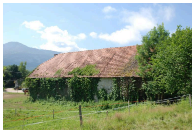
Vue arrière. Phot. Thierry Monnet IVR84_20207400561NUCA
