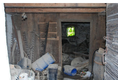
Vue intérieure de la cave sud-ouest. Phot. Thierry Monnet IVR84_20207400558NUCA
