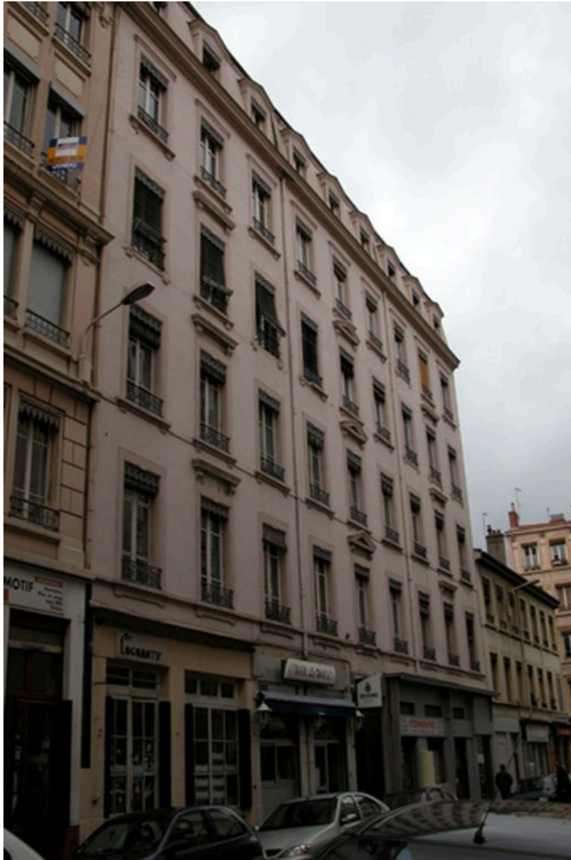
Elévation principale, depuis le nord
