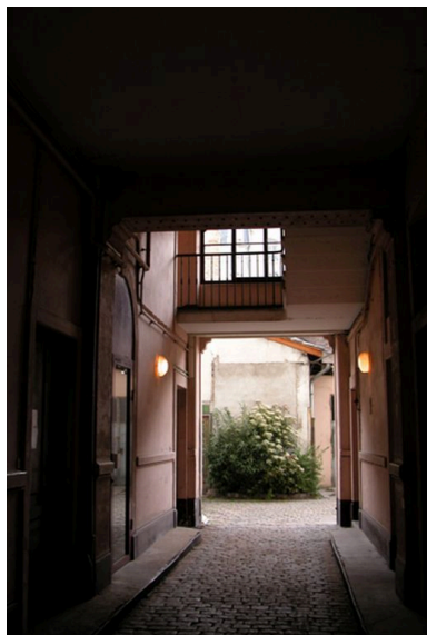
Vue du passage couvert depuis la rue Phot. N. Giroud IVR82_20046904188NUCA
