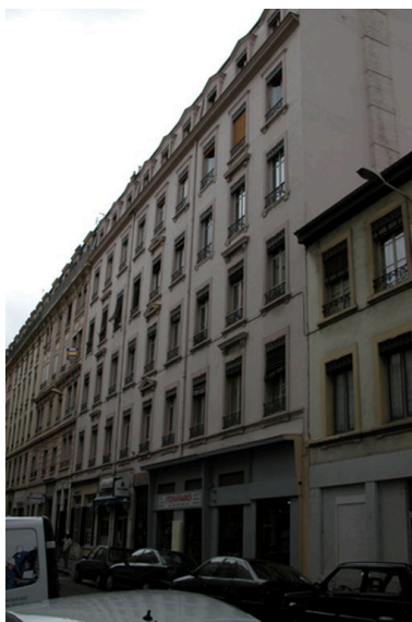
Elévation principale depuis le sud Phot. N. Giroud IVR82_20046904187NUCA
