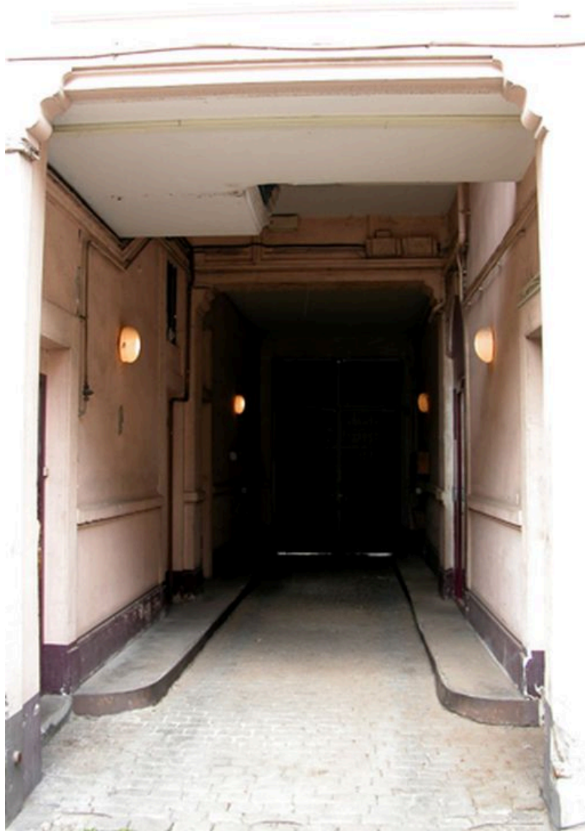
Vue du passage couvert depuis la cour
