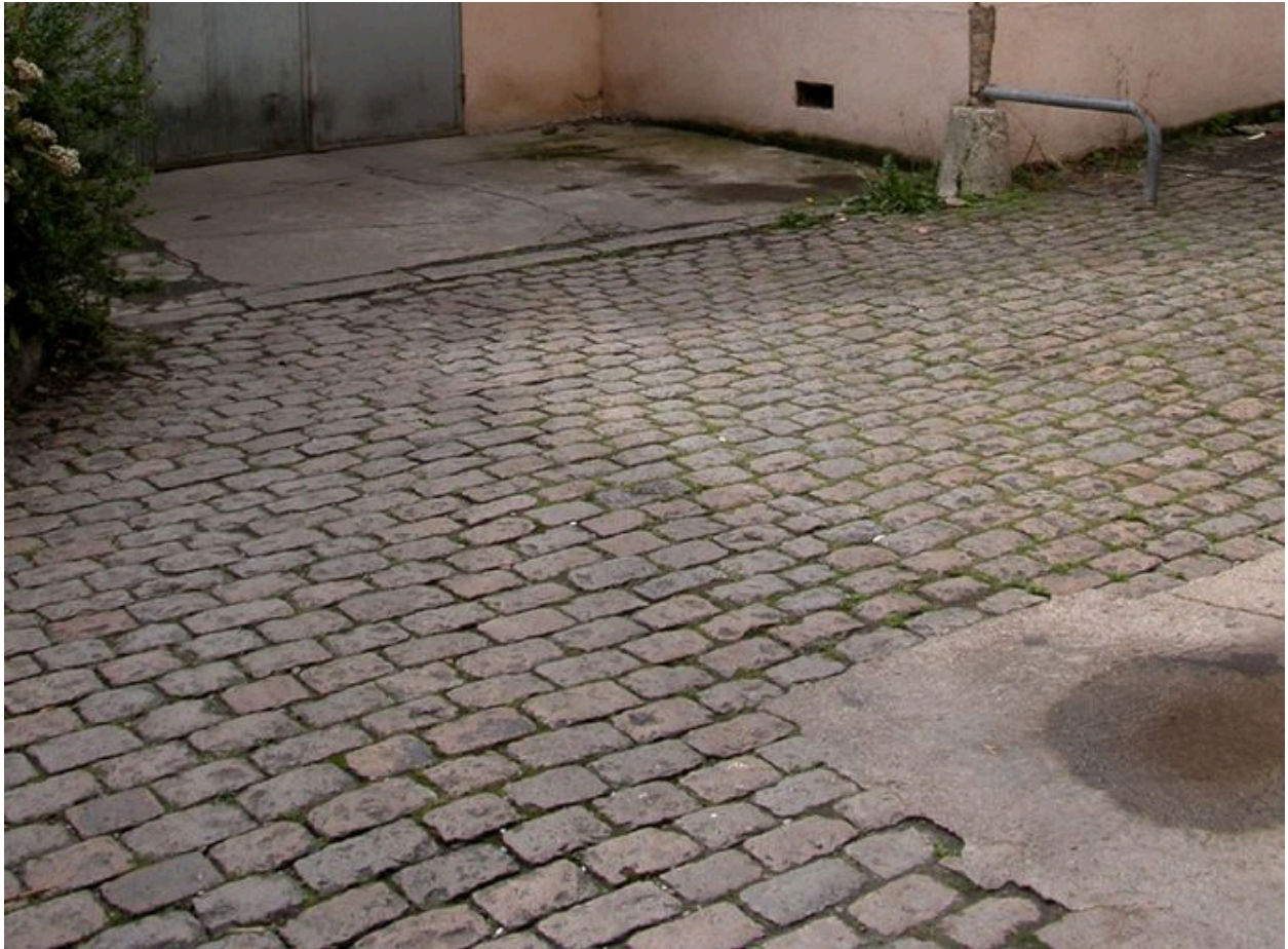
Pavement de la cour et chasse-roue à l'entrée des bâtiments sur cour
