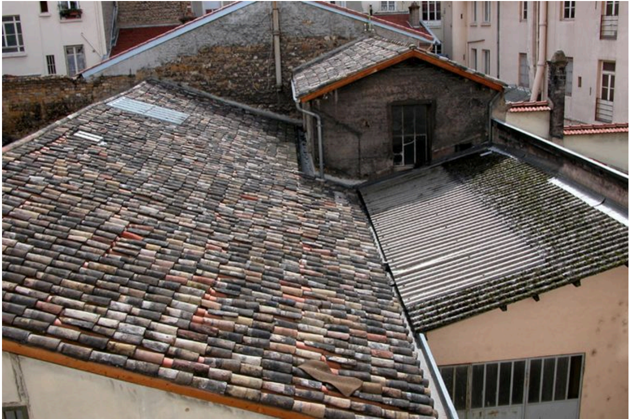
Vue des toits des bâtiments sur cour
