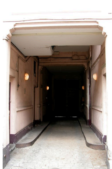
Vue du passage couvert depuis la cour Phot. N. Giroud IVR82_20046904192NUCA
