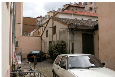
Vue de la cour, depuis le sud Phot. N. Giroud IVR82_20046904193NUCA
