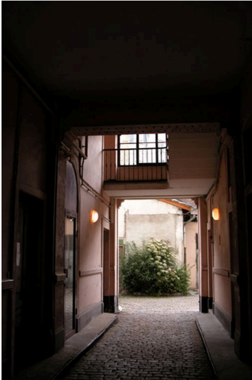
Vue du passage couvert depuis la rue
