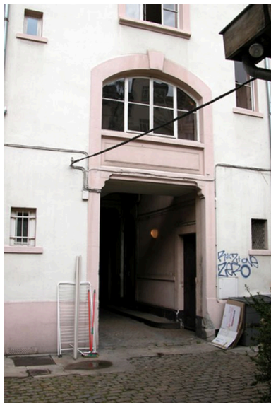
Vue de l'entrée du passage couvert depuis la cour Phot. N. Giroud IVR82_20046904191NUCA
