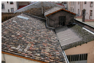
Vue des toits des bâtiments sur cour
