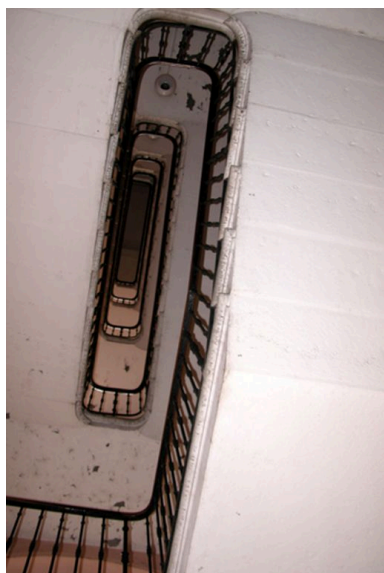
Vue de la cage d'escalier
