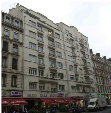
Vue générale depuis le nord-ouest Phot. Maryannick Chalabi IVR82_20046904304NUCA
