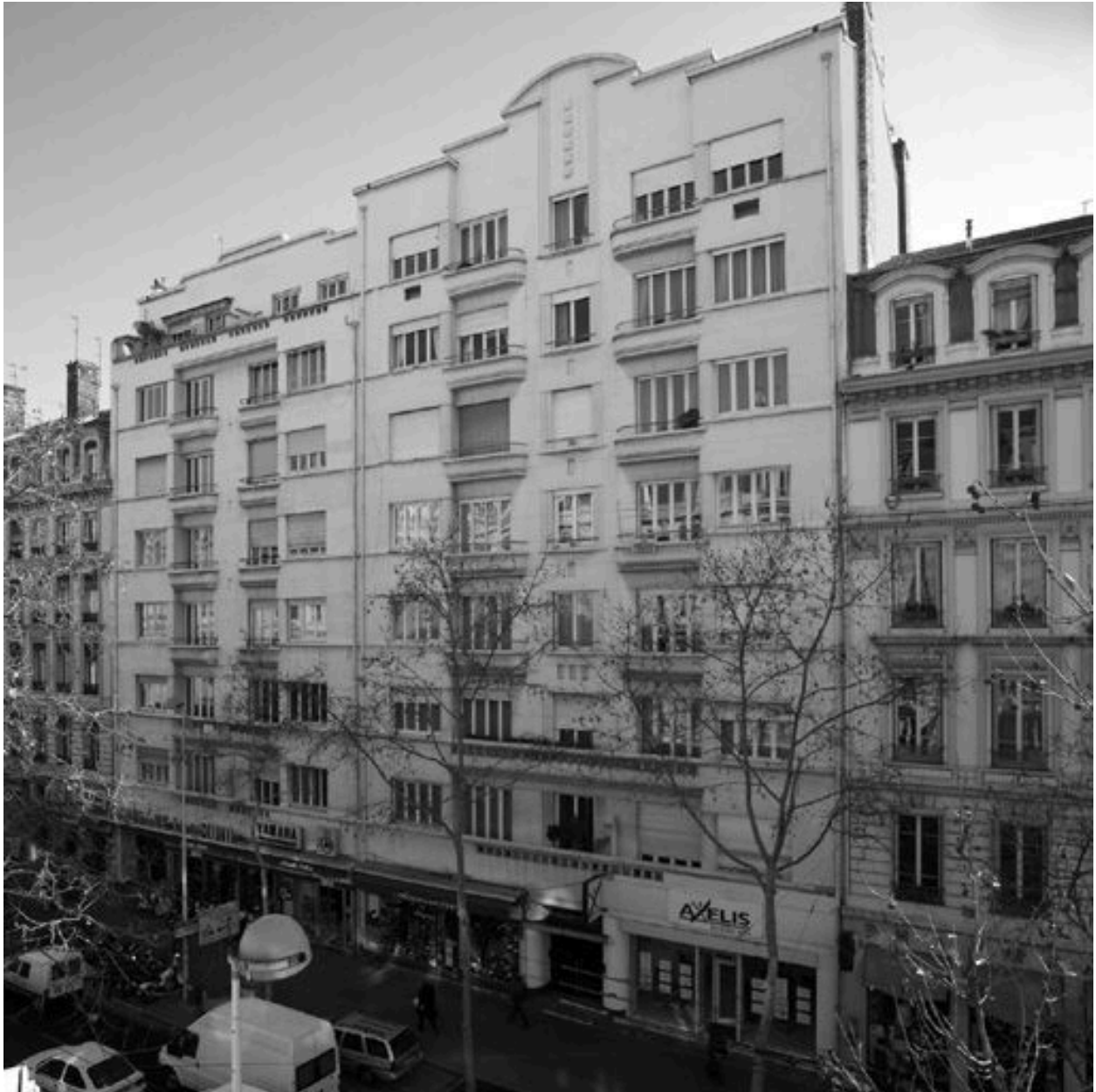
Vue générale depuis le sud-ouest
