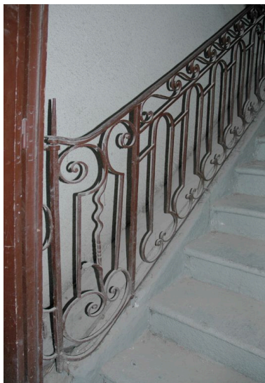
Escalier dans oeuvre : départ de la rampe en fer forgé. Phot. Simone Hartmann-Nussbaum IVR82_20124202570NUCA
