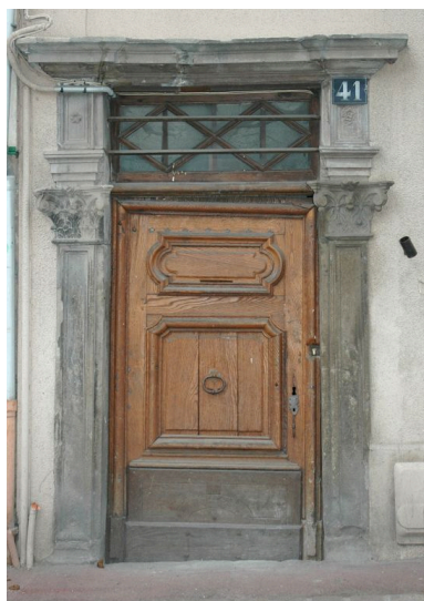
Porte piétonne à pilastres cannelés et chapiteaux composites. Vantail en bois à grands cadres moulurés, 17e siècle. Phot. Simone Hartmann-Nussbaum IVR82_20124202567NUCA
