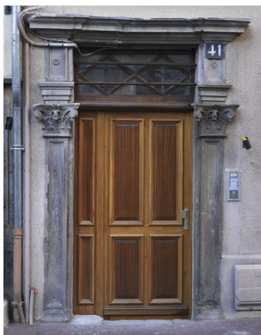
Vue de la porte après travaux exécutés en 2007. Phot. Didier Gourbin IVR82_20074200262NUCA
