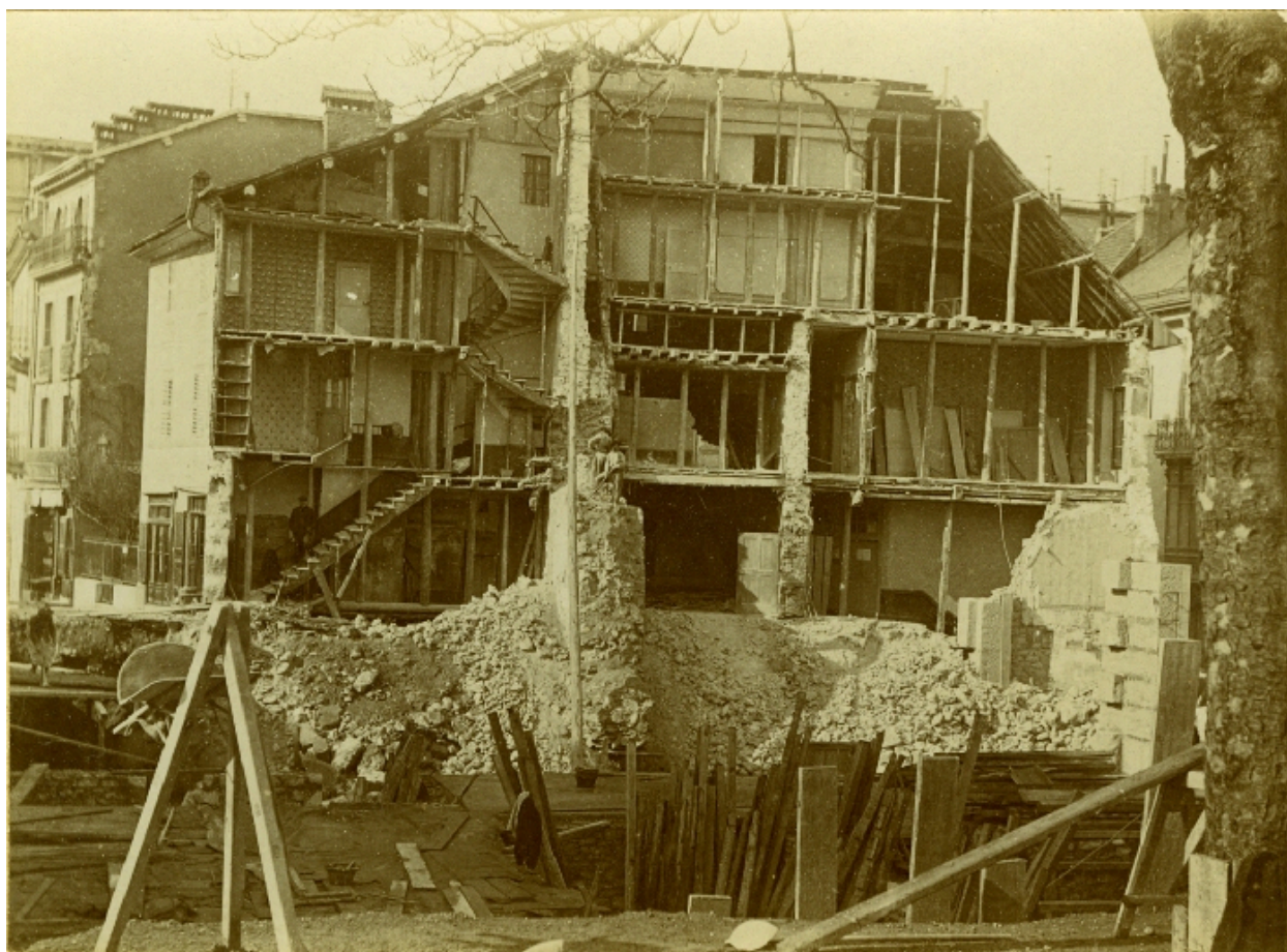
L'hôtel en cours de démolition
