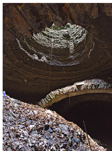
Hôtel-Dieu de Clermont- Ferrand. L'hôtel-Dieu, les galeries souterraines, galerie sud-ouest, puits de manutention et d'aération. Phot. Jean-Michel Périn IVR83_20156300160NUC4A
