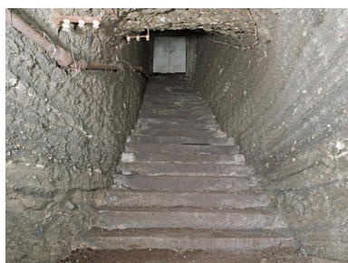
Hôtel-Dieu de Clermont-Ferrand. L'hôtel-Dieu, les galeries souterraines, galerie sud, escalier desservant l'entrée principale située dans le corps de bâtiment médian. Phot. Jean-Michel Périn IVR83_20156300159NUC4A
