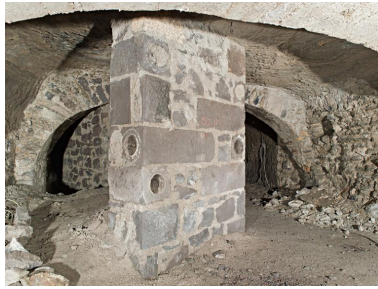
Hôtel-Dieu de Clermont-Ferrand. L'hôtel-Dieu, les galeries souterraines, galerie sud-ouest, pilier de soutènement comprenant, en réemploi, des boisseaux en trachy-andésite de l'ancienne conduite d'eau potable de Clermont-Ferrand
