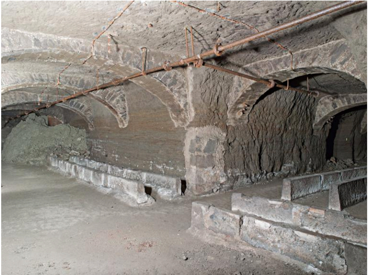
Hôtel-Dieu de Clermont-Ferrand. L'hôtel-Dieu, les galeries souterraines, carrefour des galeries nord et nord-est.
