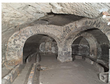
Hôtel-Dieu de Clermont- Ferrand. L'hôtel-Dieu, les galeries souterraines, salle dite "du Bonnet carré" vue du sud-ouest. Phot. Jean-Michel Périn IVR83_20156300152NUC4A
