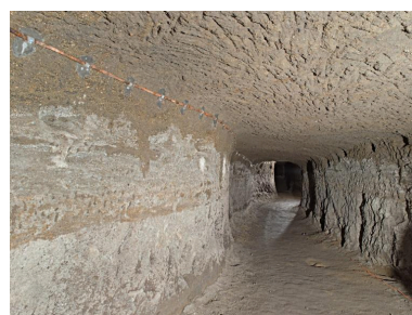
Hôtel-Dieu de Clermont-Ferrand. L'hôtel-Dieu, les galeries souterraines, galerie de liaison orientale. Phot. Jean-Michel Périn IVR83_20156300156NUC4A
