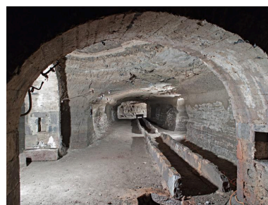
Hôtel-Dieu de Clermont-Ferrand. L'hôtel-Dieu, les galeries souterraines, galerie sud-est vue depuis la salle dite "du Bonnet carré" Phot. Jean-Michel Périn IVR83_20156300153NUC4A
