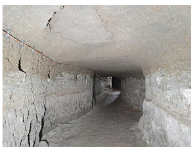
Hôtel-Dieu de Clermont-Ferrand. L'hôtel-Dieu, les galeries souterraines, galerie de liaison orientale. Phot. Jean-Michel Périn IVR83_20156300155NUC4A
