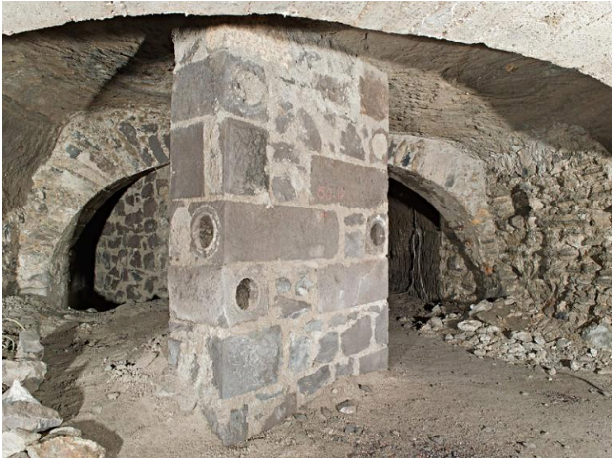
Hôtel-Dieu de Clermont-Ferrand. L'hôtel-Dieu, les galeries souterraines, galerie sud-ouest, pilier de soutènement comprenant, en réemploi, des boisseaux en trachy-andésite de l'ancienne conduite d'eau potable de Clermont-Ferrand
