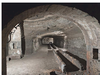
Hôtel-Dieu de Clermont-Ferrand. L'hôtel-Dieu, les galeries souterraines, galerie sud-est vue depuis la salle dite "du Bonnet carré". Phot. Jean-Michel Périn IVR83_20156300154NUC4A
