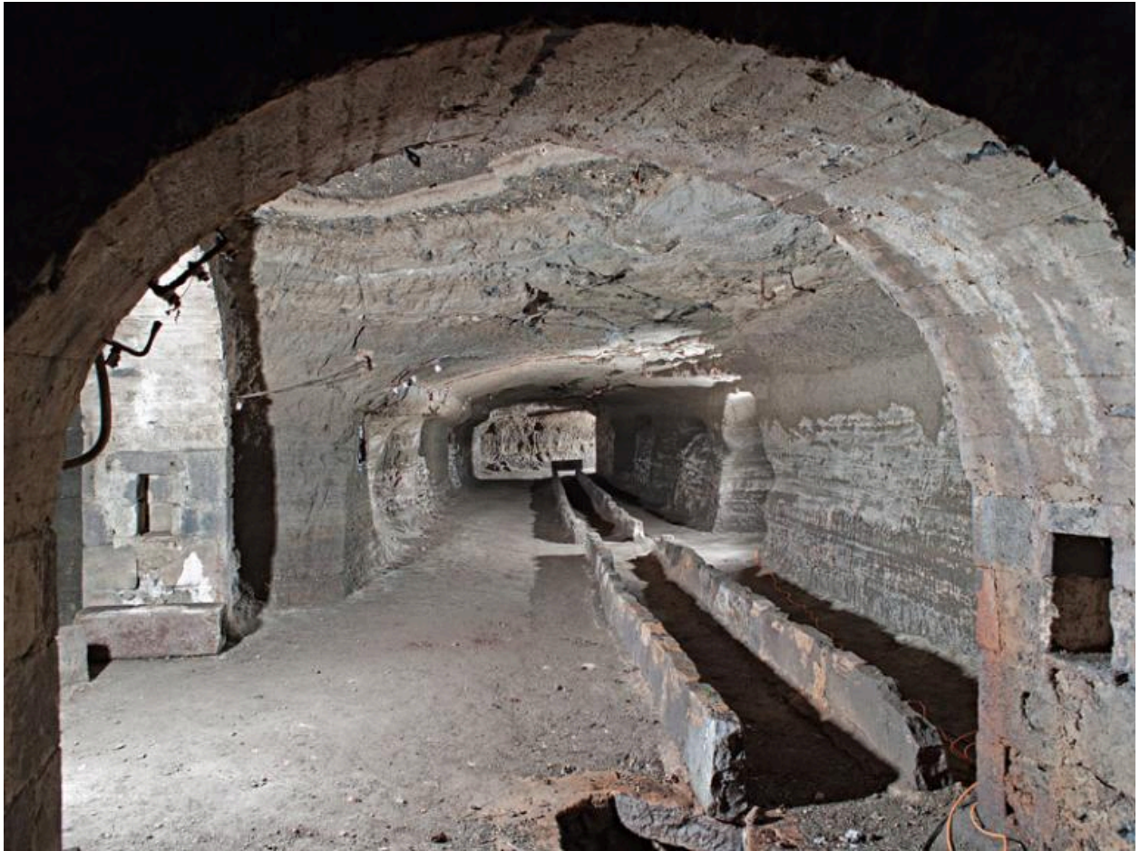
Hôtel-Dieu de Clermont-Ferrand. L'hôtel-Dieu, les galeries souterraines, galerie sud-est vue depuis la salle dite "du Bonnet carré"
