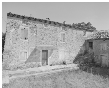
Graillon. Façade du logis de la ferme. Phot. Alain Franchella IVR82_20002600701X
