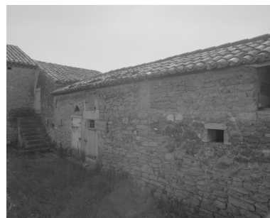
Graillon. Une partie des dépendances agricoles (étables, grenier et fenil). Phot. Alain Franchella IVR82_20002600700X
