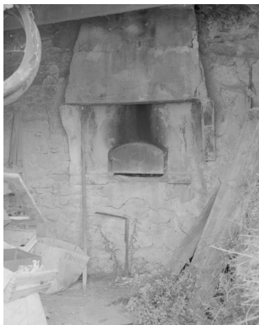
Graillon. Détail du four à pain accolé au logis. Phot. Alain Franchella IVR82_20002600702X
