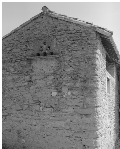
Graillon. Détail du pigeonnier, intégré dans un mur-pignon. Phot. Alain Franchella IVR82_20002600698X
