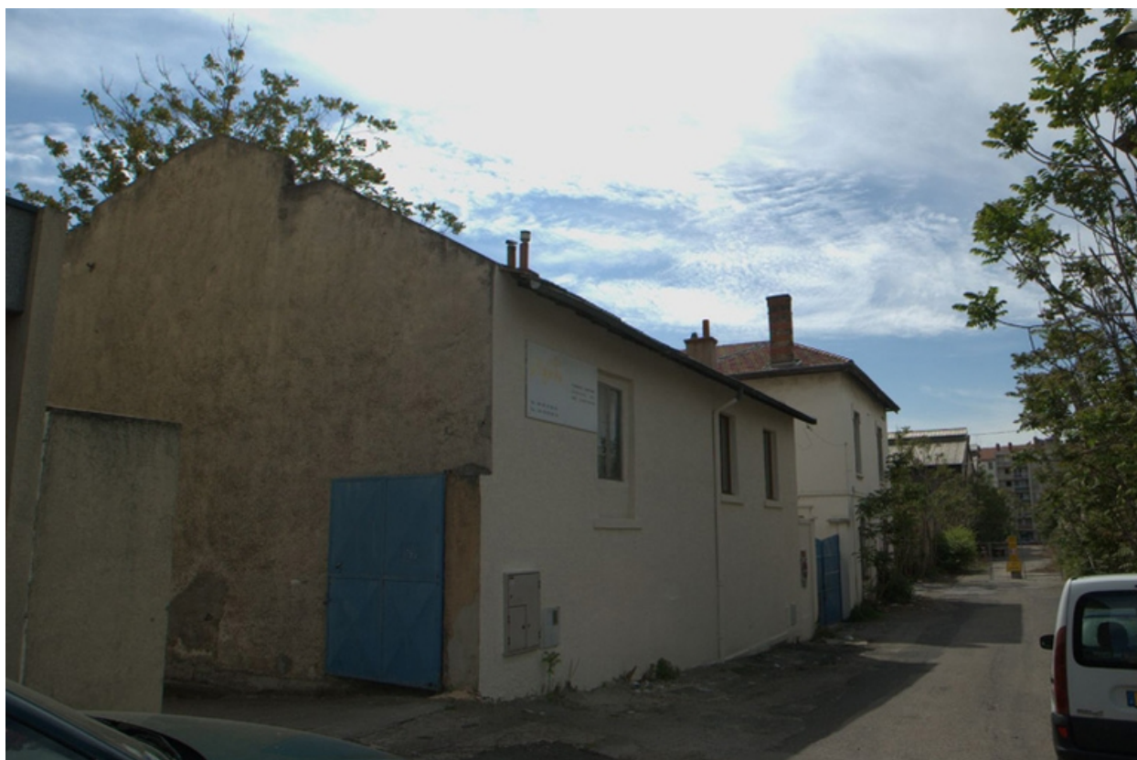
Vue d'ensemble est
