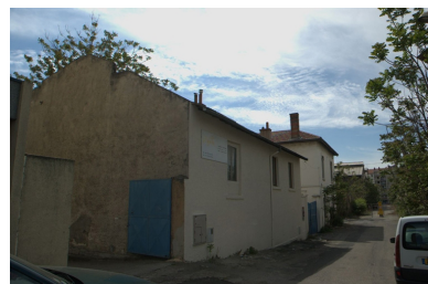
Vue d'ensemble est Phot. Nadine Halitim-Dubois IVR82_20086900481NUCA
