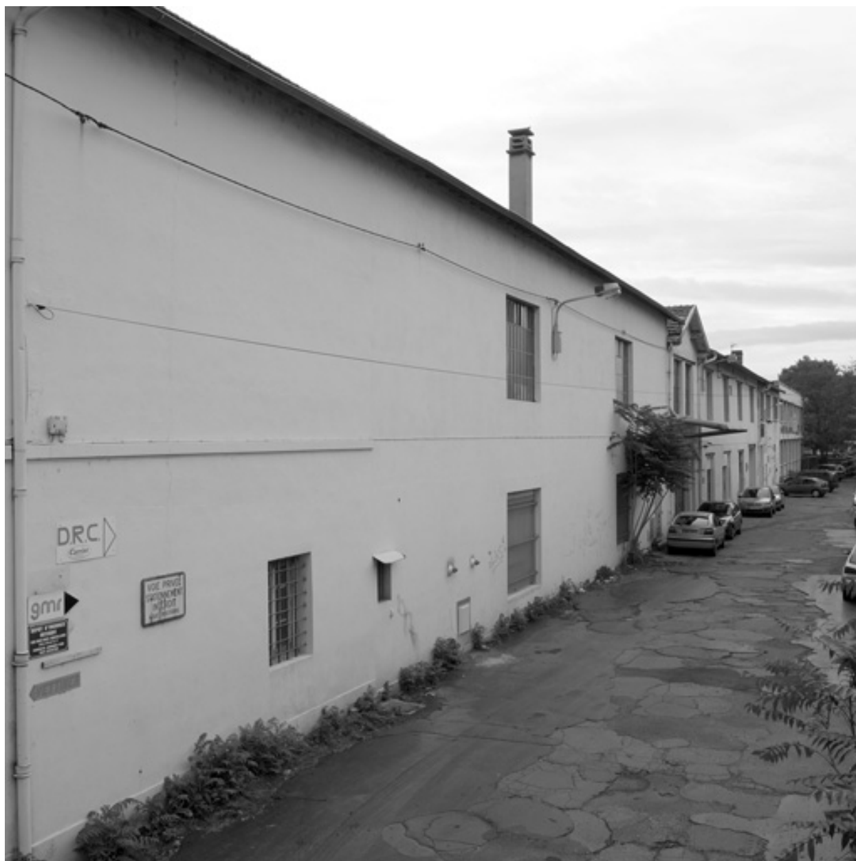
Vue d'ensemble façade ouest
