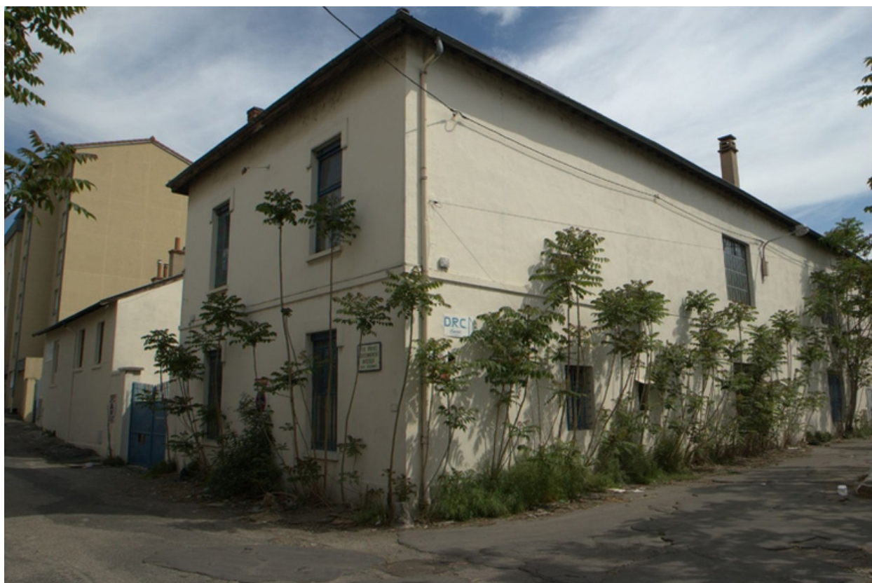
Vue d'ensemble nord-ouest
