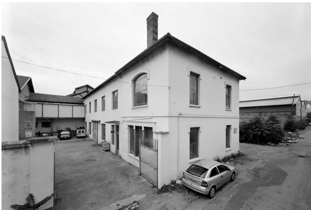
Vue de l'entrée principale, vue sud
